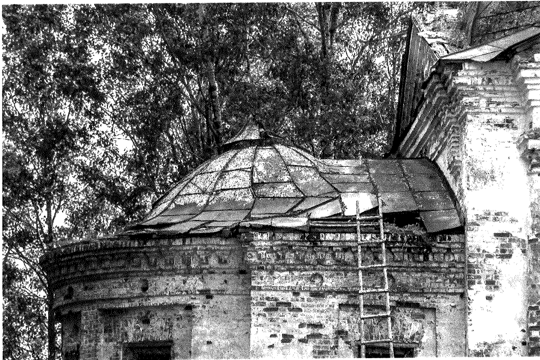
Фото 69 – Алтарная часть. Многообломный карниз с поясом дентикул по периметру всей алтарной части. Купольная металлическая фальцевая кровля
