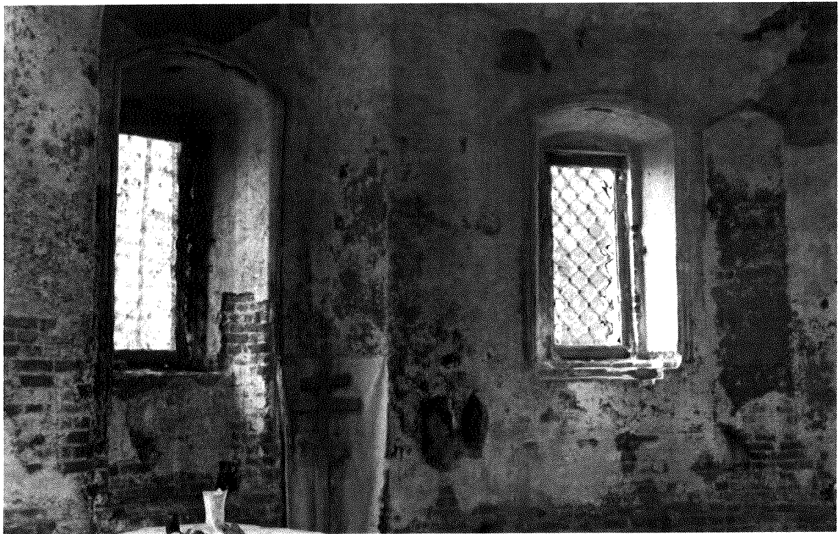
Фото 72 – Алтарная часть. Оконные проёмы. Прямоугольные, с плоской перемычкой с уличной стороны, в интерьере проёмы перекрыты лучковыми перемычками. Кубоватые решетки на окнах
