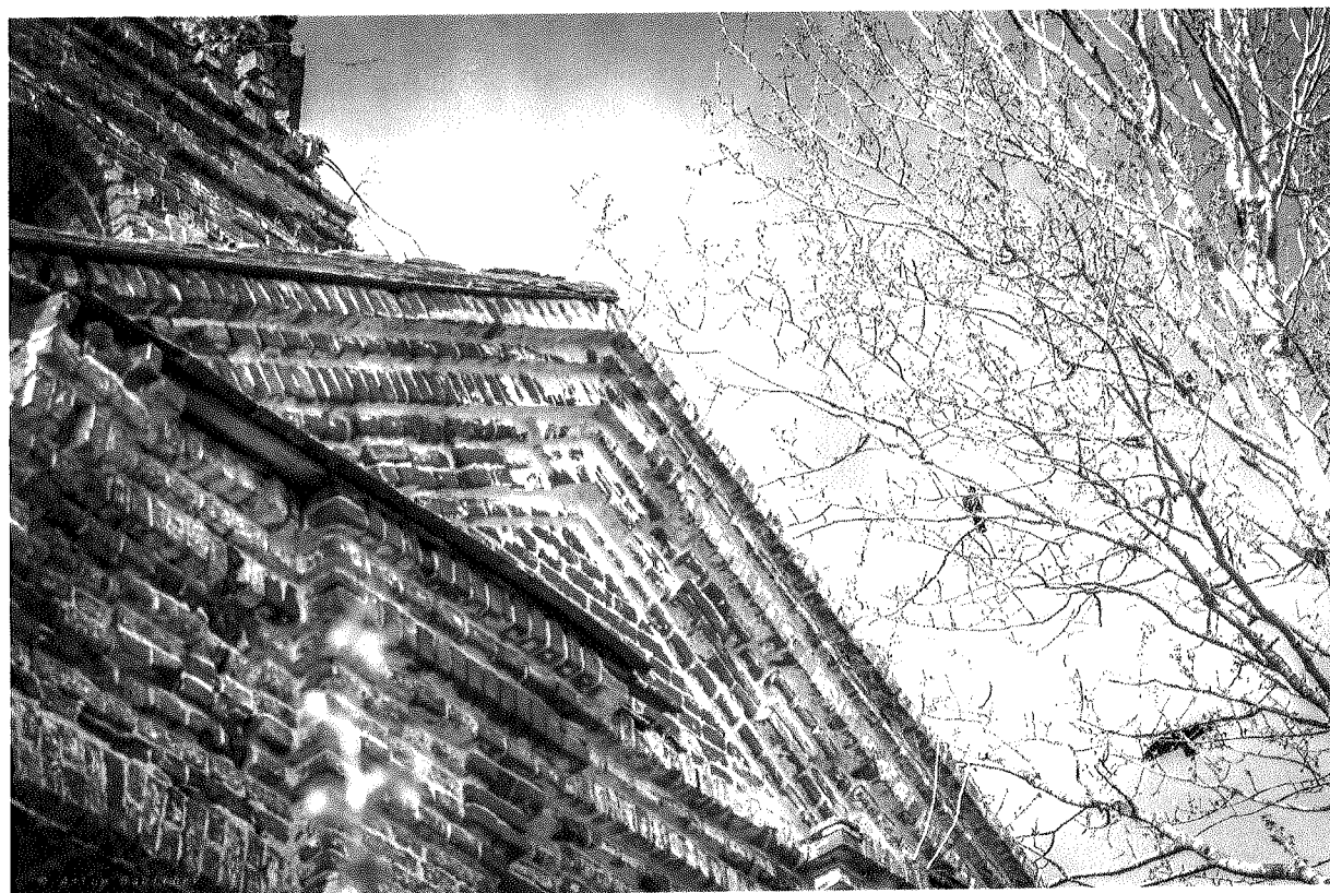
Фото 57 – Четверик. Южный фасад. Колонный портик. Кладочный декор
