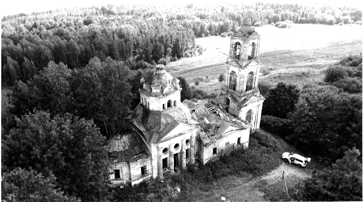
Фото 6 – Состояние храма на лето 2022г. Вид с северо-востока
