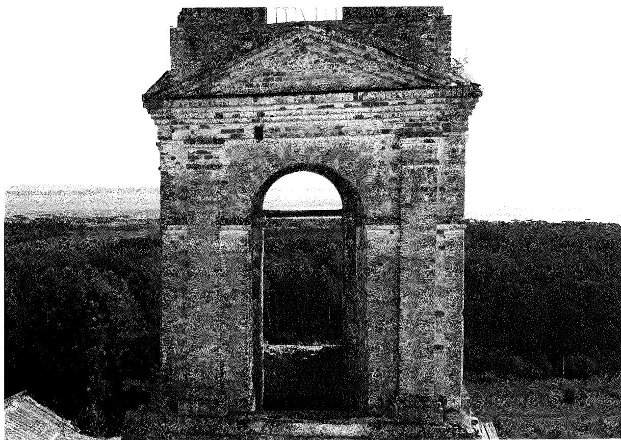
Фото 16 – Колокольня. Второй ярус. Северный фасад
