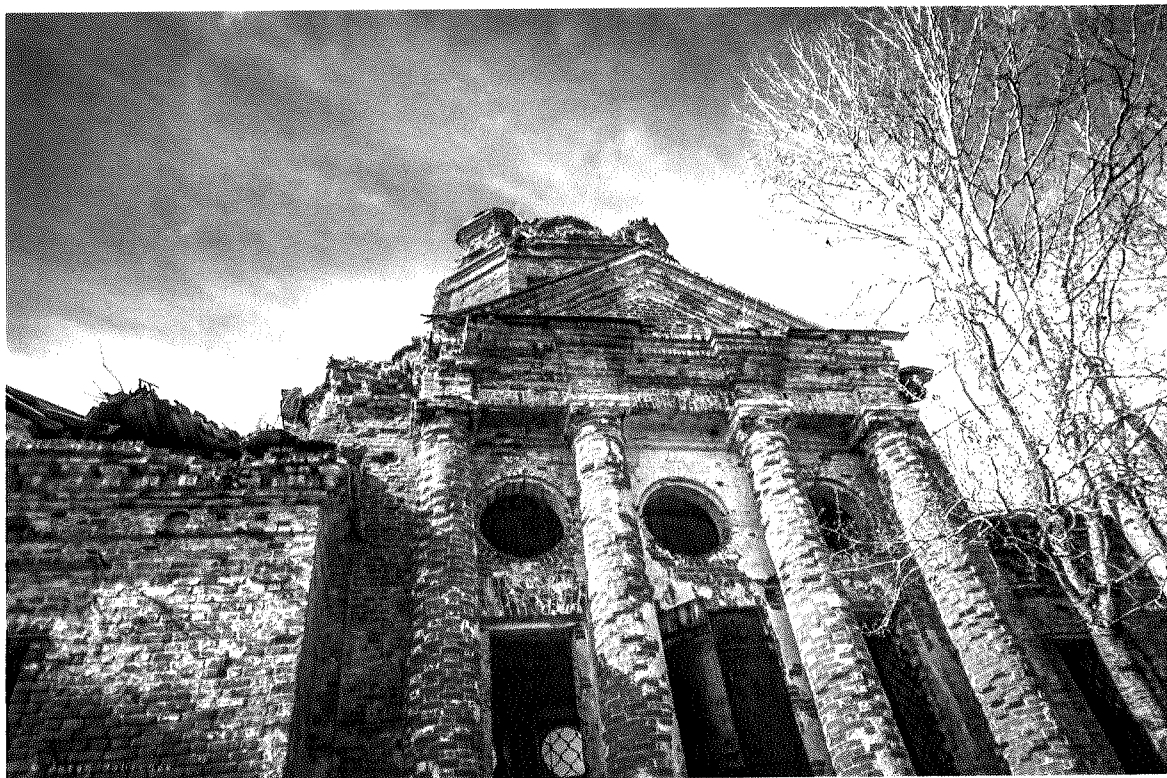
Фото 55 – Четверик. Южный фасад. Колонный портик. Оси проёмов
