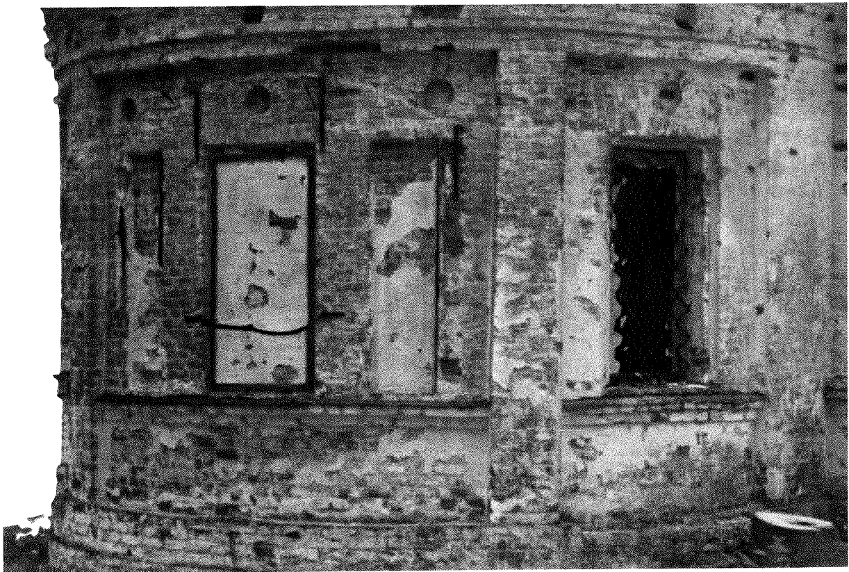
Фото 71 – Алтарная часть. Прямоугольные ниши с размещающимися в них оконными проёмами и круглые ниши над перемычкой на северном и южном фасадах. Оконные проёмы. Прямоугольные, с плоской перемычкой с уличной стороны, в интерьере проёмы перекрыты лучковыми перемычками
