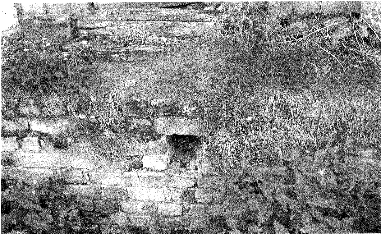
Фото 30 - Колокольня. Продух цокольного пространства в северной стене
