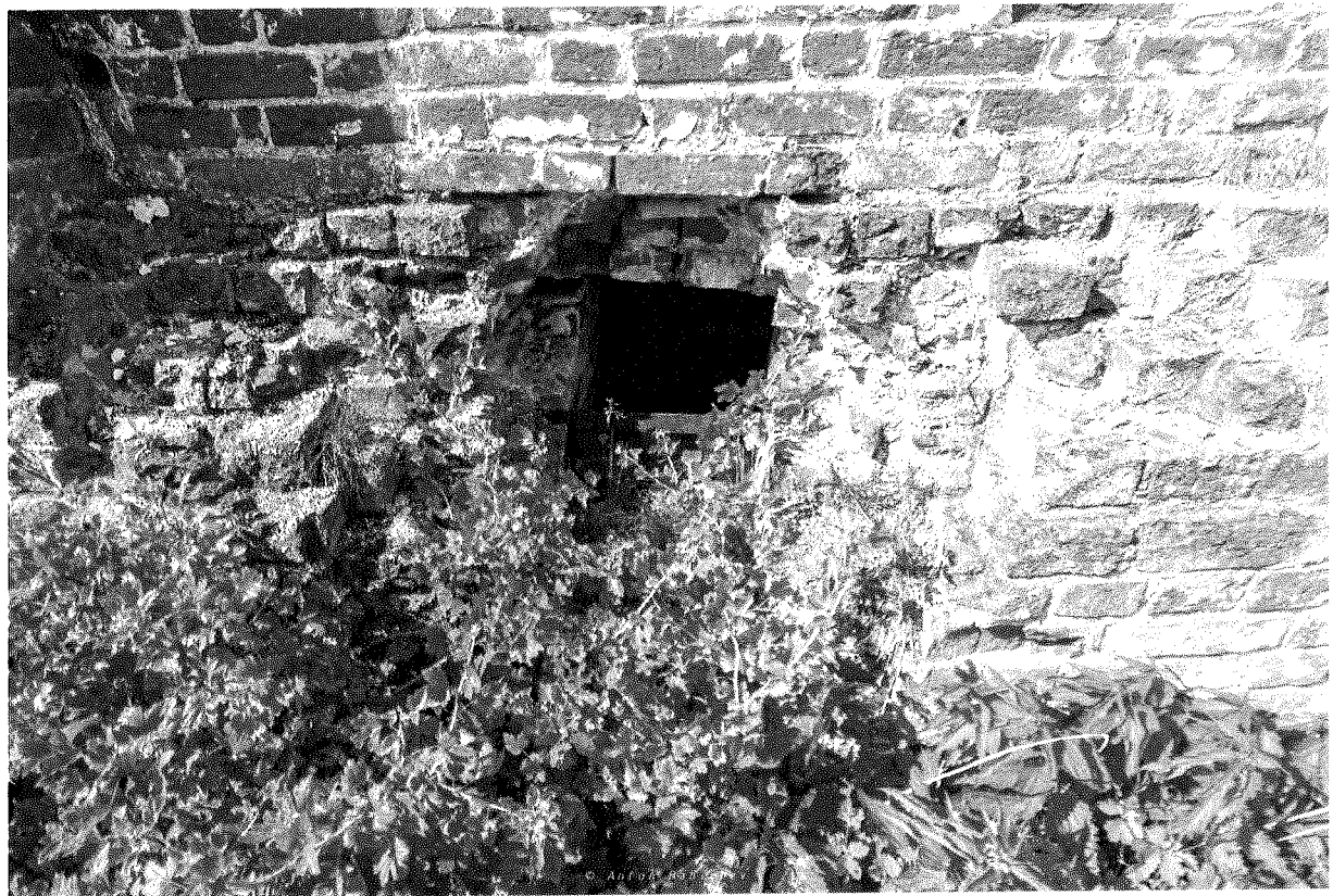
Фото 31 – Колокольня. Продух цокольного пространства в южной стене. Металлическая закладная связь
