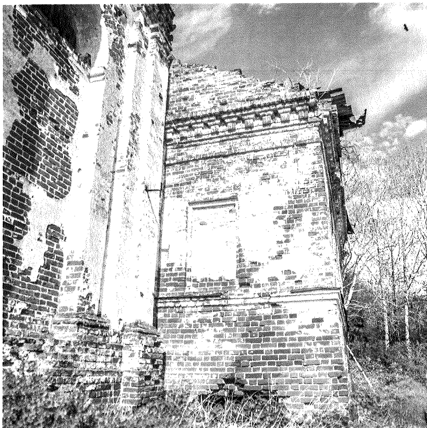
Фото 48. Трапезная. Западный фасад. Южный декоративный проём
