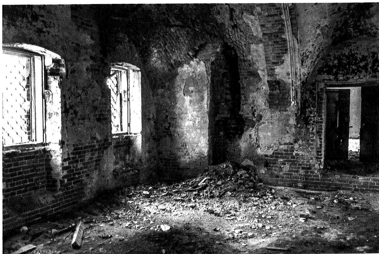
Фото 49. Трапезная. Интерьер. Металлическая связь, проходящая через основание свода. Основание подпружной арки
