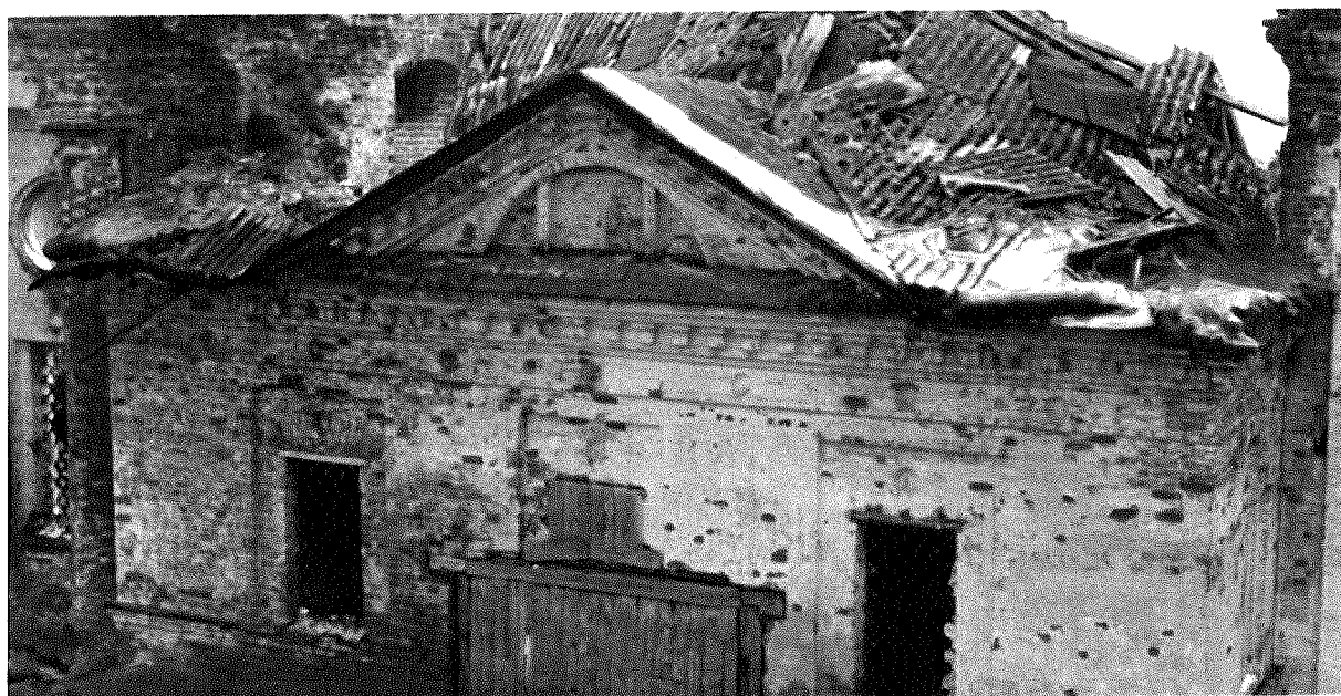
Фото 36 – Трапезная. Северный фасад. Фронтон с глухим проёмом
