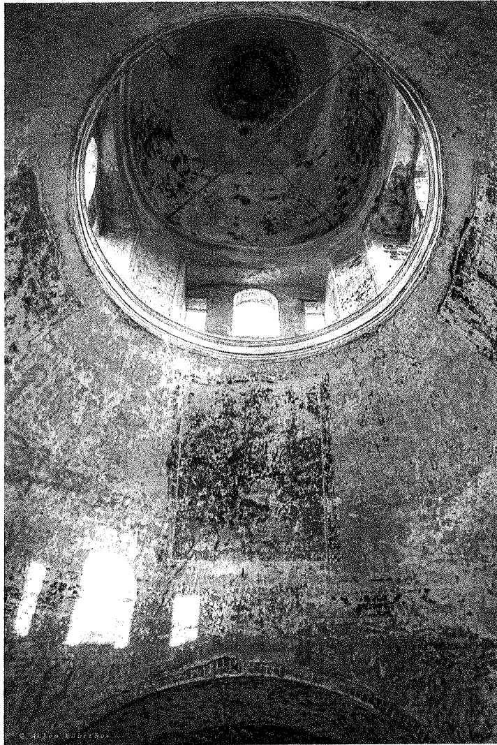
Фото 60 – Четверик. Четырёхдольный сомкнутый свод, переходящий в шельге через большой световой люк в световой восьмерик. Фрагменты фресок на поверхности свода. Металлические связи купола восьмерика
