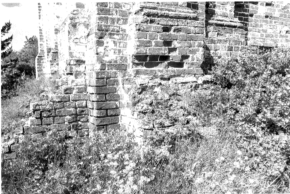
Фото 29 – Колокольня. Контрфорсы в основании западной и южной стен
