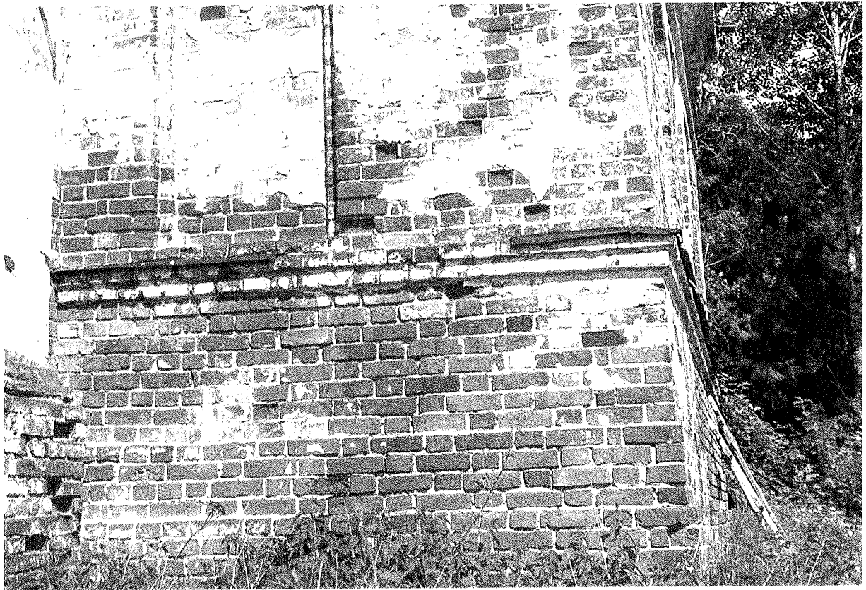
Фото 40 – Трапезная. Южный фасад. Двухступенчатый кладочный пояс с металлическим отливом в уровне подоконников. Выступающая кладка цоколя
