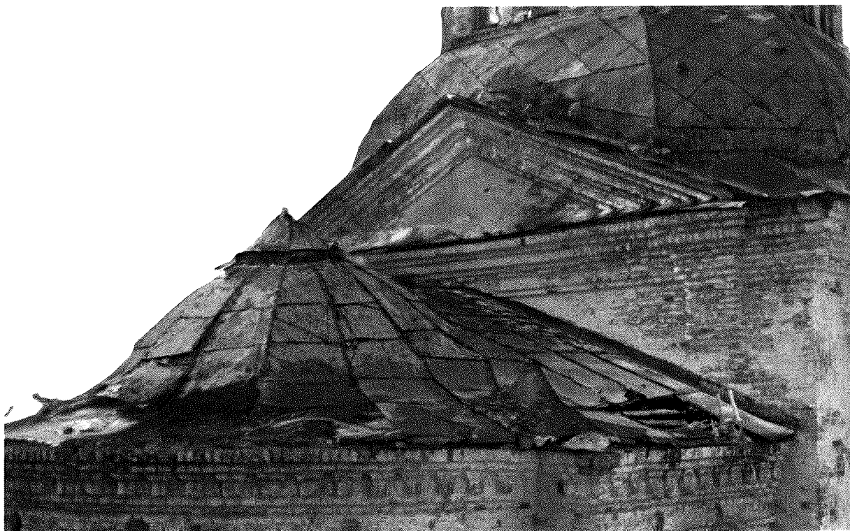
Фото 58 – Четверик. Восточный фасад. Фронтон
