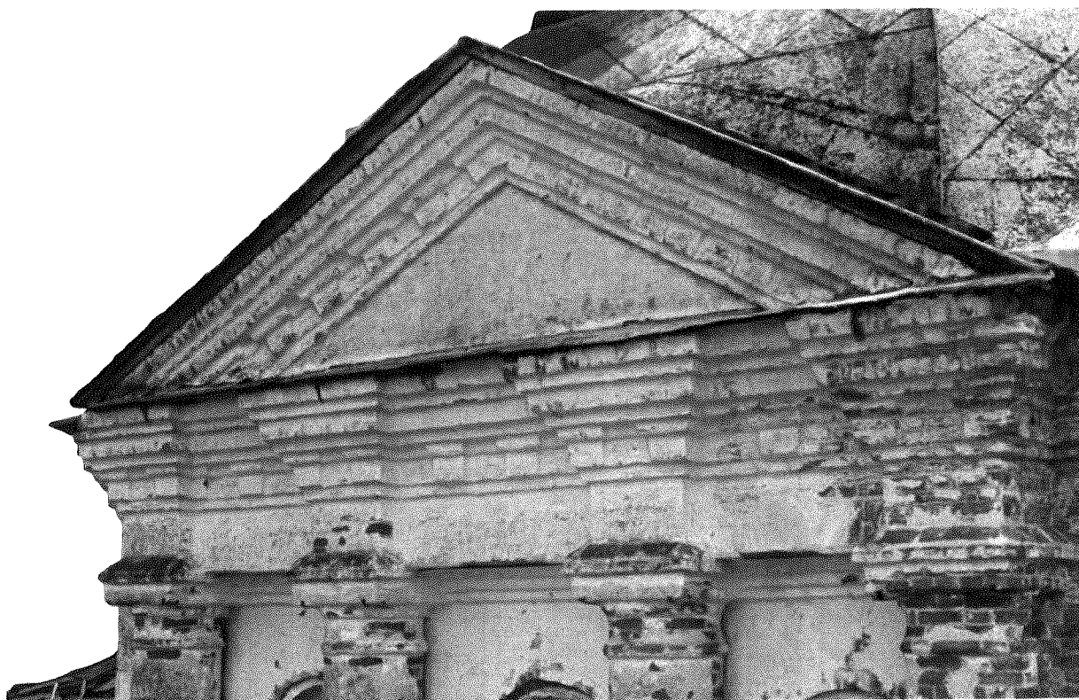
Фото 56 – Четверик. Северный фасад. Колонный портик. Кладочный декор
