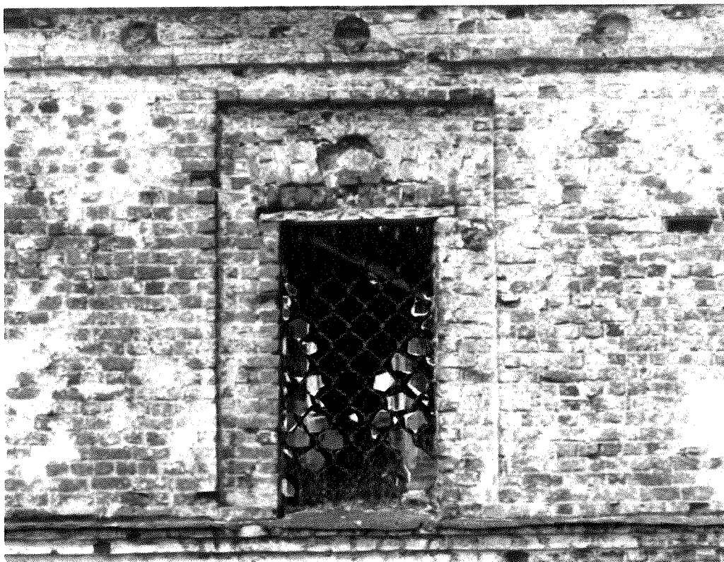
Фото 44 – Трапезная. Типовой оконный проём. Фасад
