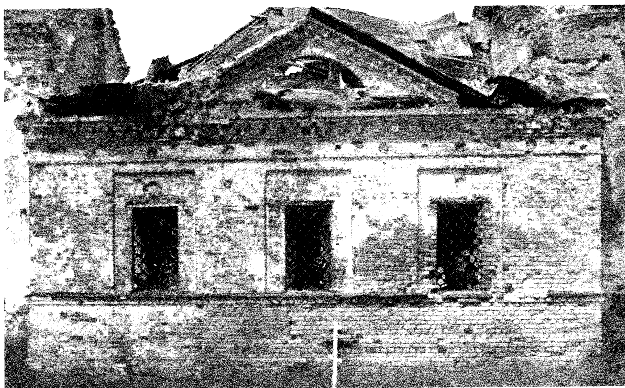
Фото 43 – Трапезная. Южный фасад. Оси проёмов
