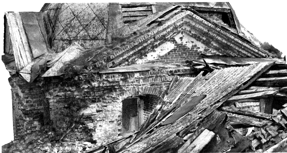
Фото 59 – Четверик. Западный фасад. Фронтон
