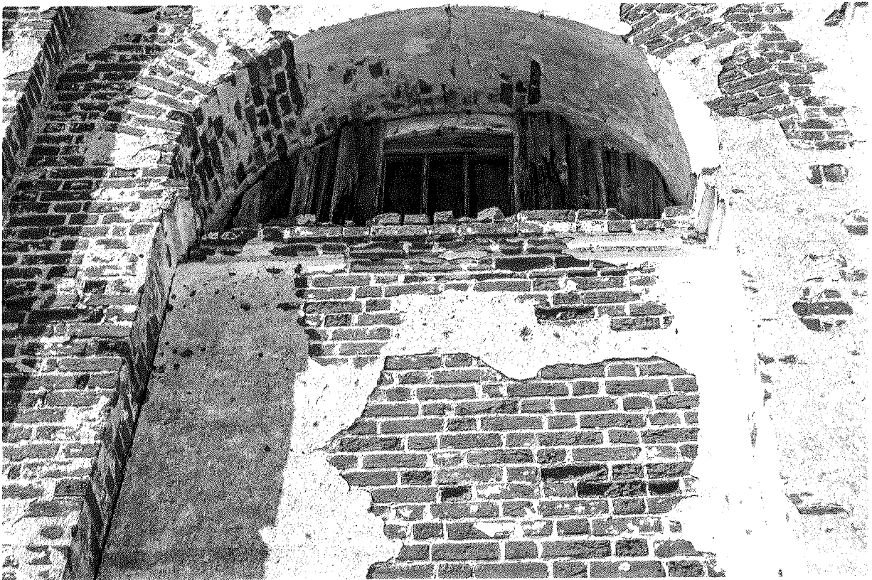
Фото 8 – Верстовая кладка в южной стене колокольни
