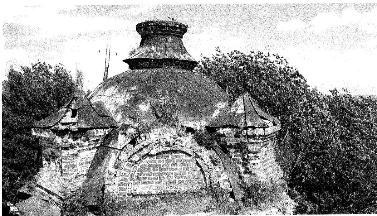
Фото 66 – Восьмерик. Полуглавия, угловые тумбы, барабан центральной главки
