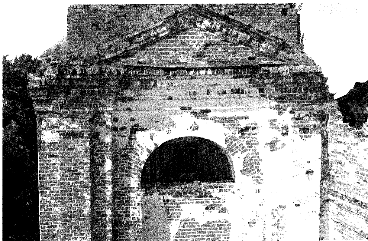
Фото 15 – Колокольня. Южный фасад. Южный фасад. Фронтон
