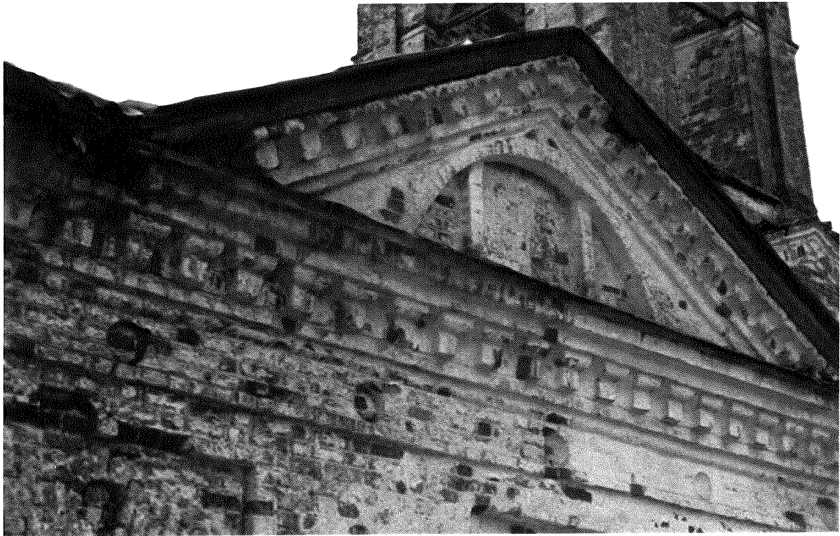
Фото 38 – Трапезная. Северный фасад. Кладочный декор карнизной части стены и фронтона
