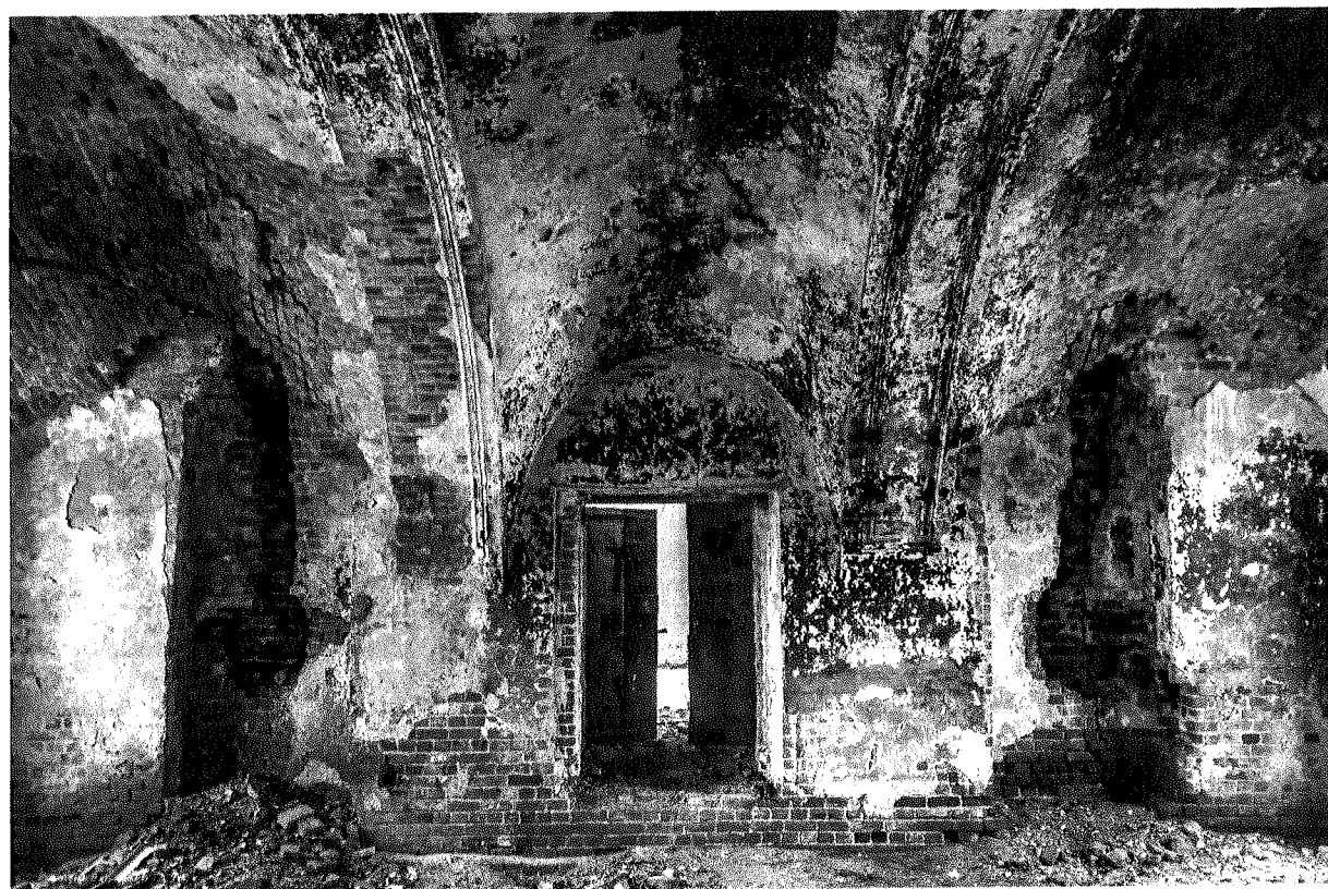
Фото 51. Трапезная. Интерьер. Подпружные арки, своды
