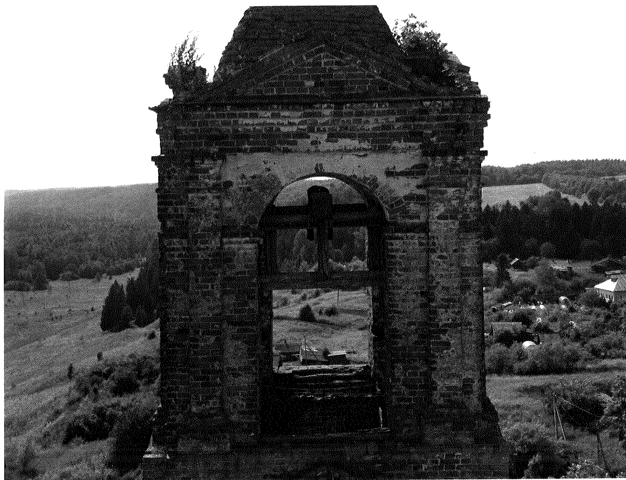
Фото 26 – Колокольня. Третий ярус. Восточный фасад
