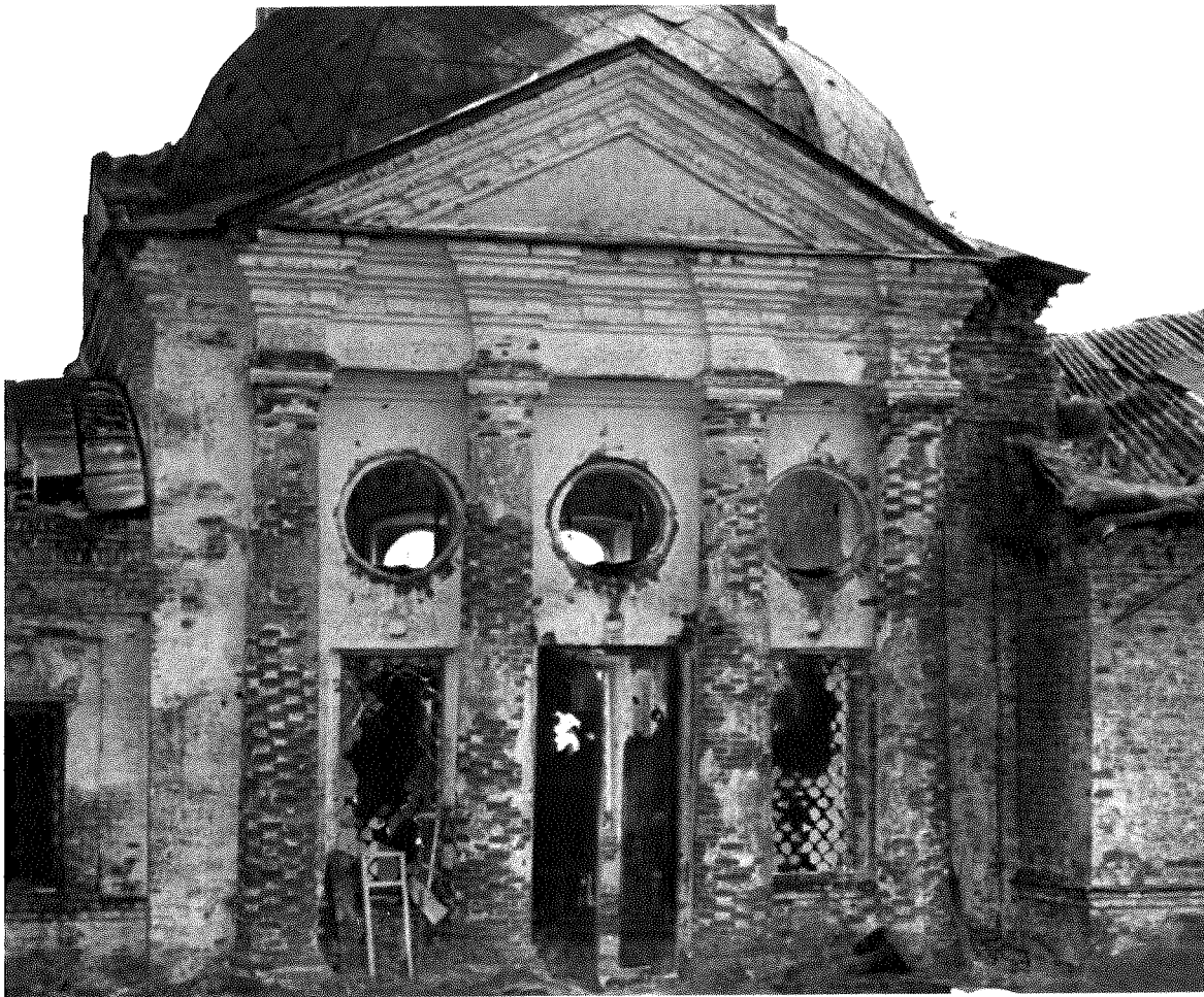
Фото 54 – Четверик. Северный фасад. Колонный портик. Оси проёмов
