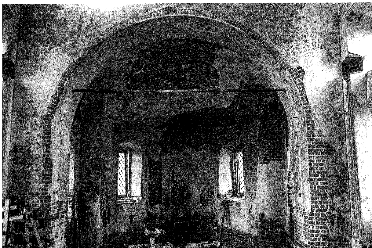
Фото 67-1 – Четверик. Проём в алтарную часть. Воздушная металлическая связь
