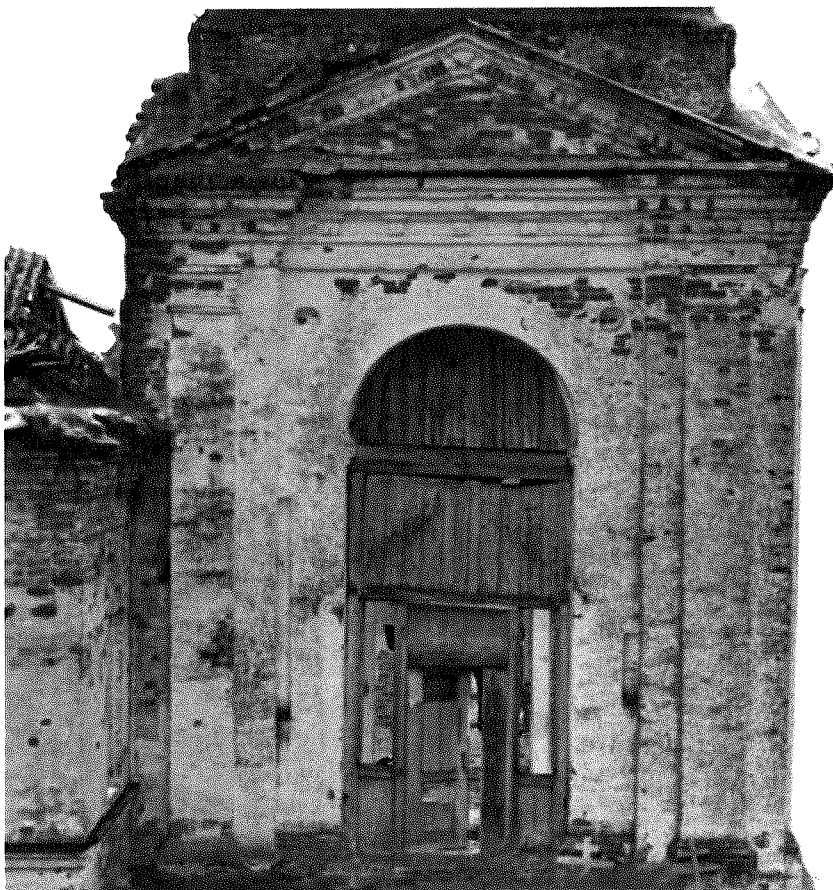
Фото 10 – Колокольня. Первый ярус. Северный фасад
