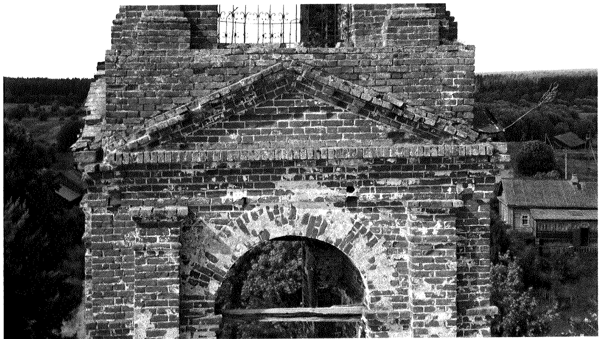
Фото 21 – Колокольня. Второй ярус. Южный фасад. Фронтон
