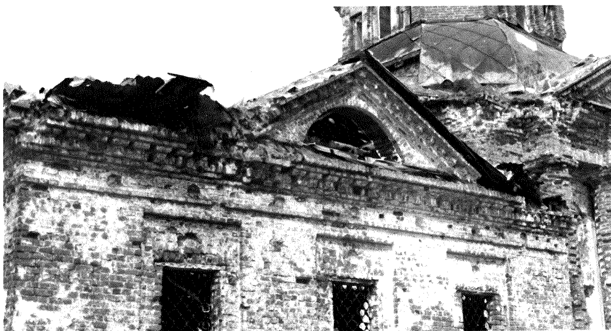
Фото 37 – Трапезная. Южный фасад. Фронтон со слуховым окном
