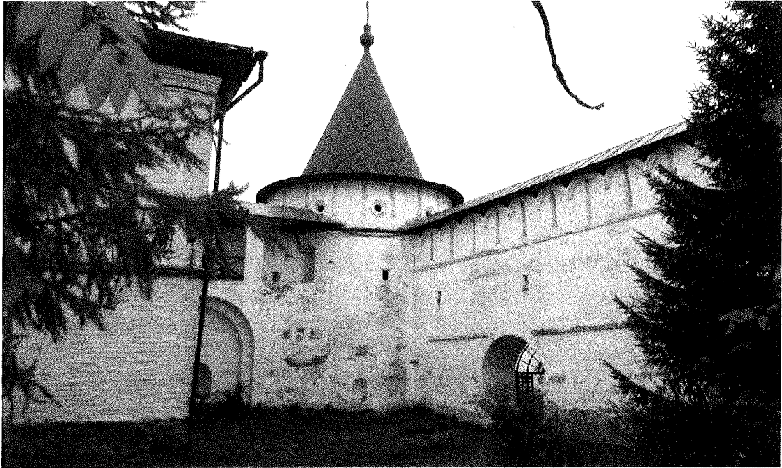
Участок стены между корпусом Богдельни и Кузнечной башней. Дворовый фасад с территории Нового города Стены обруба
