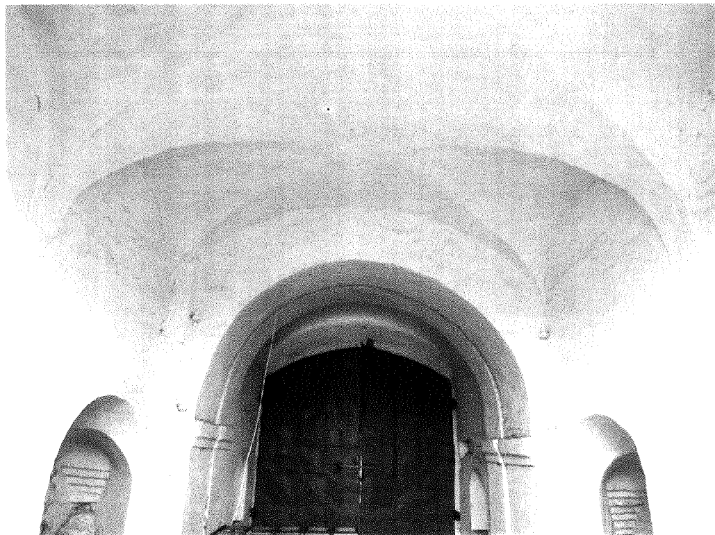
Свод в перекрытии первого яруса
