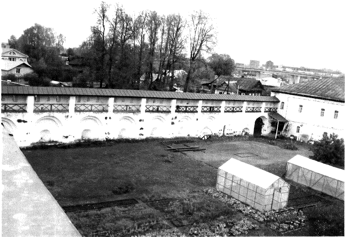
Участок стены между Северо-западной башней и корпусом Богдельни. Дворовый фасад с территории Нового города
