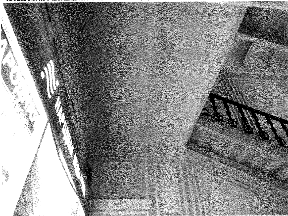
- своды Монье перекрытия главной лестницы
