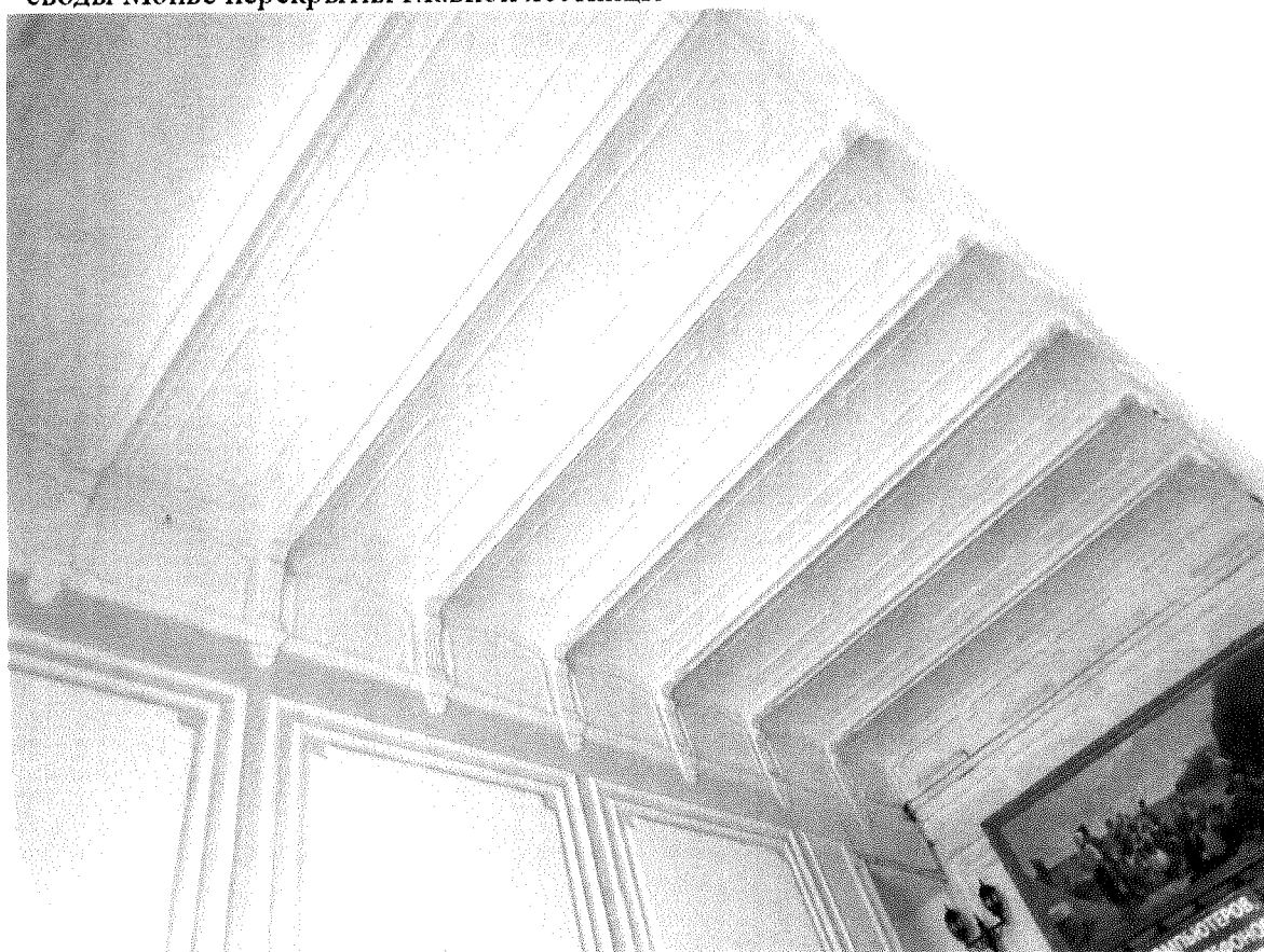
- своды Монье перекрытия главной лестницы
