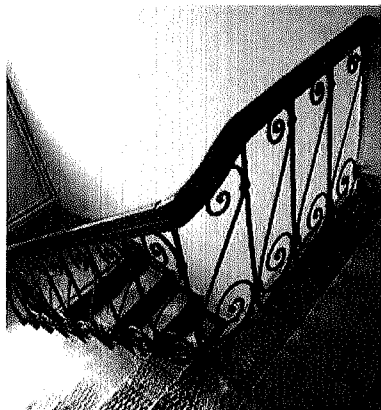
Парадная, местоположение, конфигурация, материал исполнения- ступени металлические, с железными решетками и деревянными поручнями
