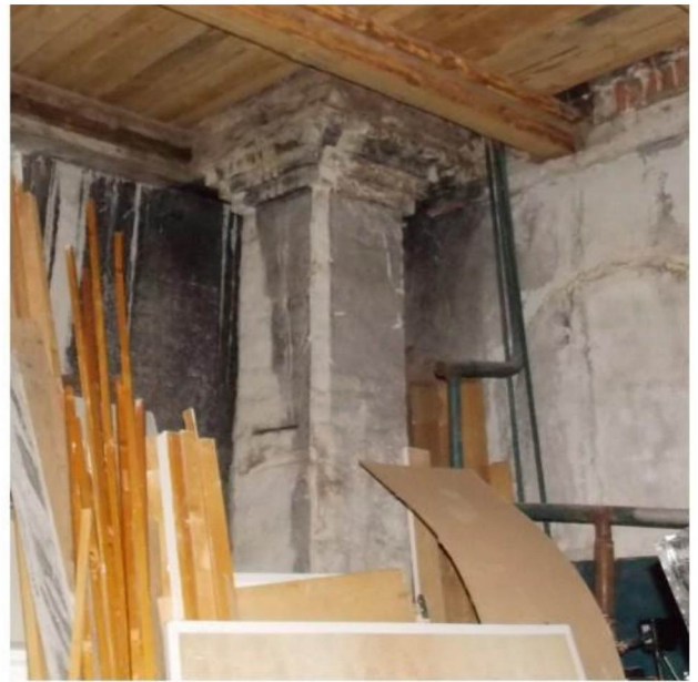
Фото №2. Печь № 2 в уровне 1-го этажа.
