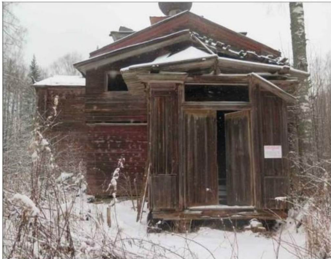
Стойечно-балочная конструкция крыльца и паперти
