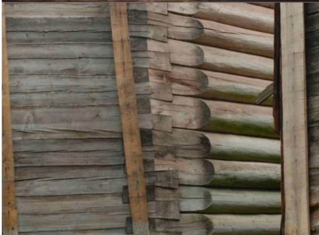
Лафет и брёвна тесаные снаружи (в алтарных прирубках)
