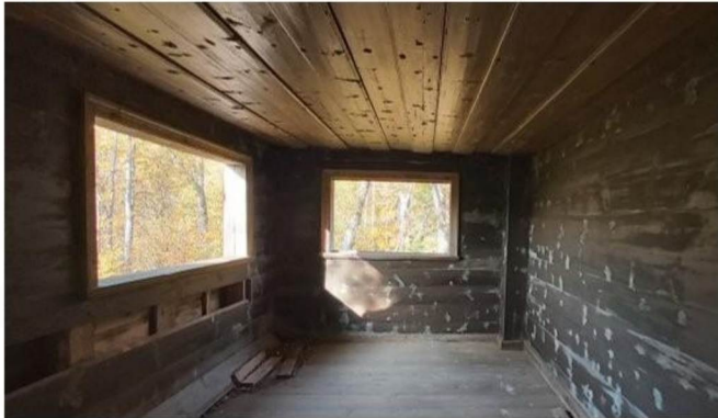
брусяная обвязка оконных проемов
