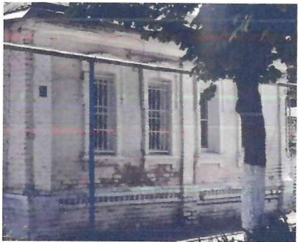
профилированный карниз небольшого выноса; развитый промежуточный цокольный карниз с рядом «поребрика»;
