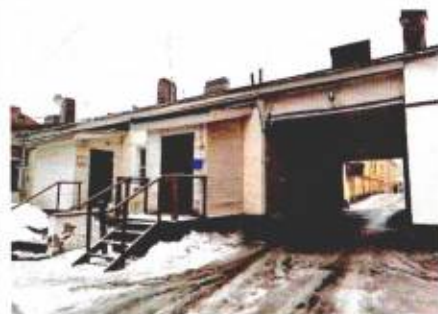
Левая часть дворового Ю-В фасада
