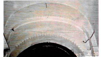
Декор углов арки первого внутреннего проема парадного входа. 1-ый этаж. Фото 2012 г.
