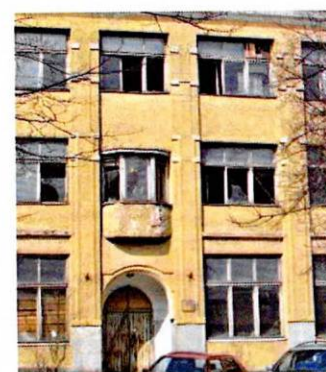
Лопатки. Лицевой Ю-В фасад. Фото 2009 г.
