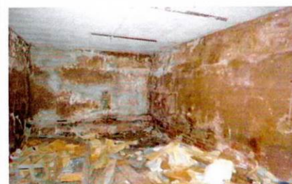
Подвал, помещение в Ю-З крыле. Фото 2016 г.
