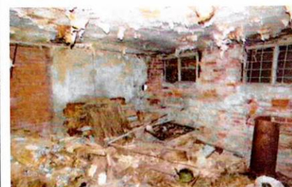
Подвал, помещение в Ю-В крыле. Фото 2016 г.
