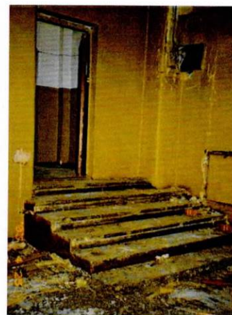
Помещение 1-го этажа Ю-3 крыла. Сохранившаяся лестница парадного входа. Фото 2003 г.
