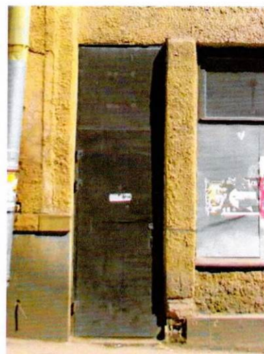
Сохранившаяся гранитная ступень входа. Левая сторона Ю-З фасада
