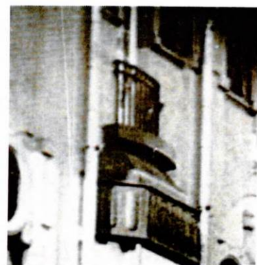
Балкон над эркером. Ю-В фасад. Фото 1910-х гг. (копия)
