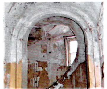
Декор углов двойной арки проема между парадным входом и центральной ЛК. 1-ый этаж
