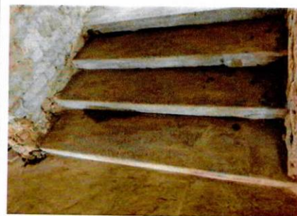
Лестница в помещения 3-го этажа с центральной лестницы
