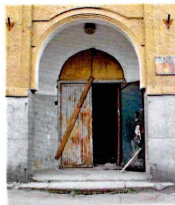
Парадный вход. Ю-В фасад
