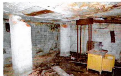
Подвал. Помещение под внутренним двором. Фото 2016 г.
