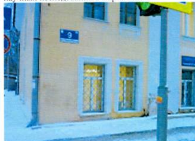
Фрагмент юго-западного фасада. Фото 2023г.
