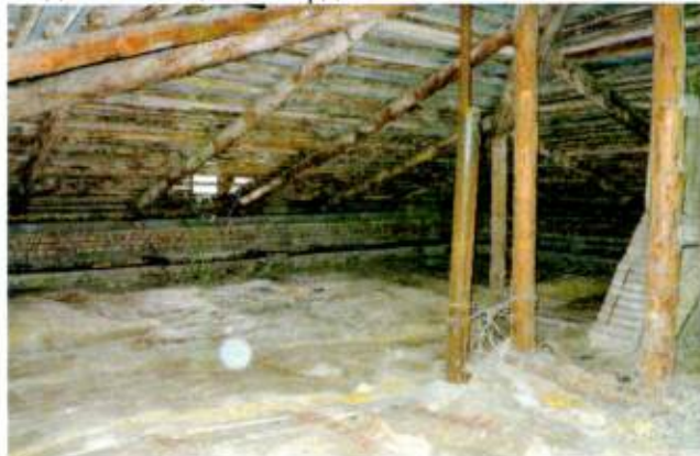
Вид из помещения чердака
