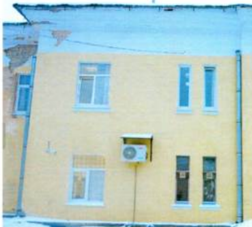
Оконные проемы с-в фасада 5-8 световым осям
