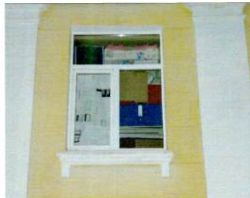
Оконный проем 2-го этажа. Ю-з фасад
