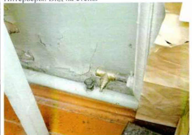
Вид на покрытие пола пом.15
