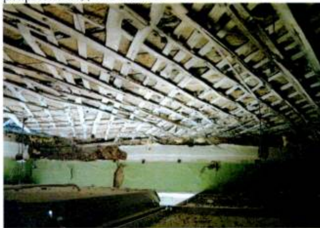
Перекрытие над 2-м этажем
