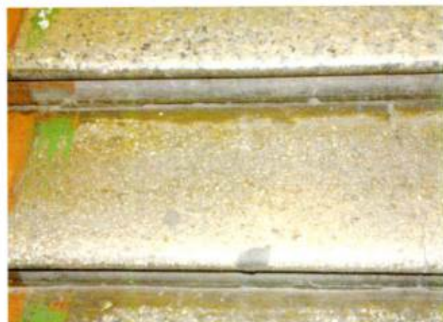
Лестница ЛК 1. Вид на ступени
