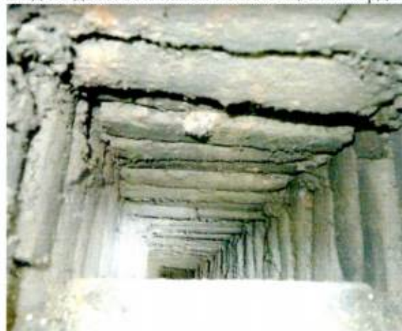
Вид на дымовой канал из помещения чердака
