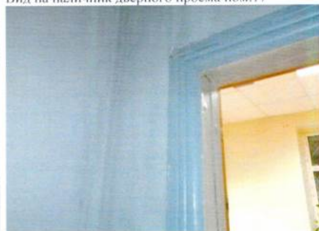
Вид на наличник дверного проема пом.17
