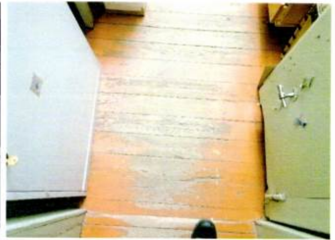
Вид на покрытие пола пом. 15
