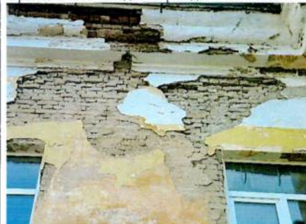
Фрагмент северо-восточного фасада. Фото 2023г.
