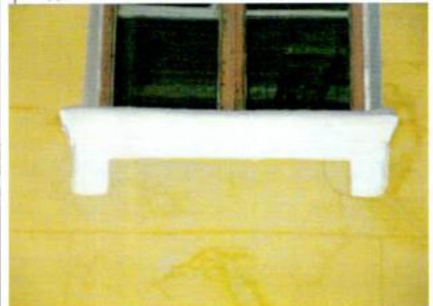
Подоконные тяги с кронштейнами с-з фасада
