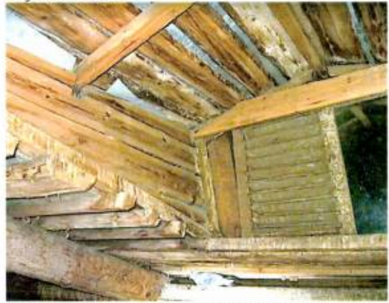
Вид из помещения чердака. Конструкции слухового окна
