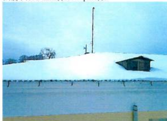
Вид с северо-восточного фасада
