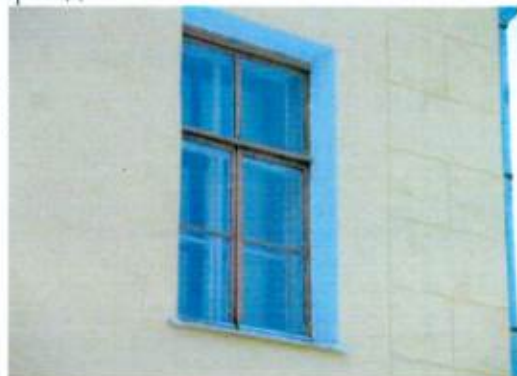
Оконный проем с-в фасада по 13 световой оси
