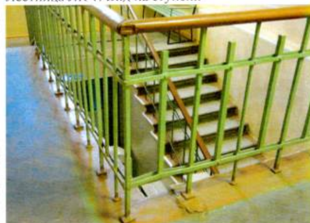
Лестница ЛК 1. Вид на мателлическое ограждение
