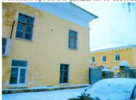
Оконные проемы с-в фасада по 11-13 световым осям
