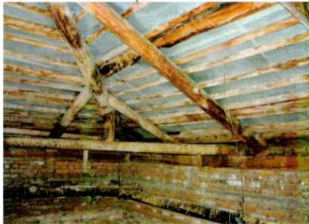
Вид из помещения чердака
