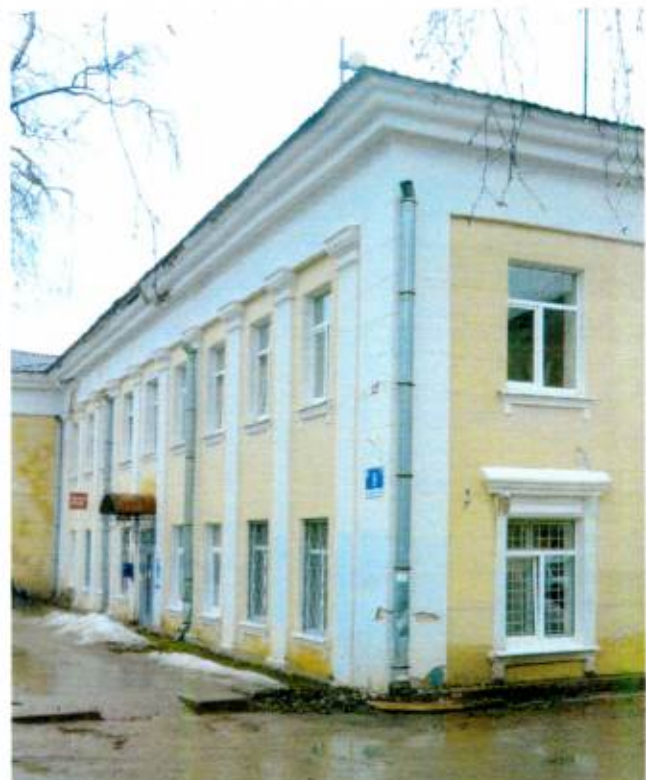
Пилястры в правой части фасада, рустованная лопатка в угловой правой части ю-з фасада
