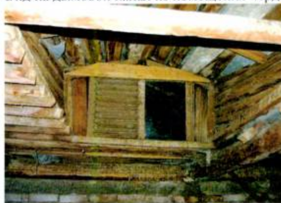
Конструкции слухового окна из помещения чердака
