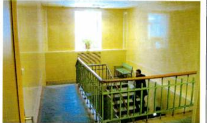
Лестница ЛК 1. Вид на лестницу со 2-го этажа
