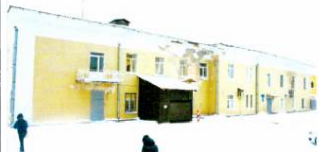
Северо-восточный (дворовый) фасад
