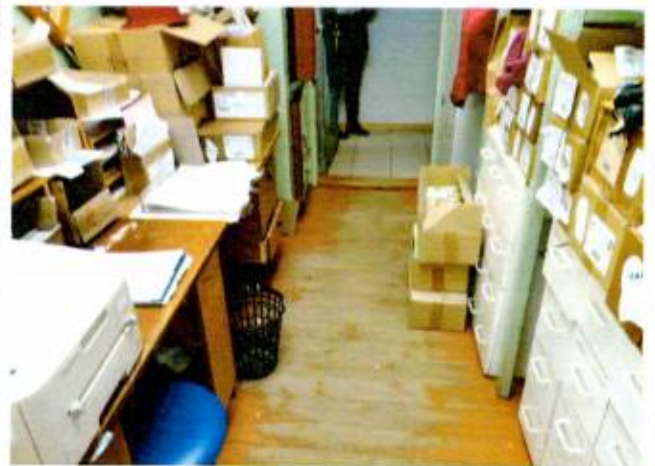
Вид на покрытие пола пом. 15
