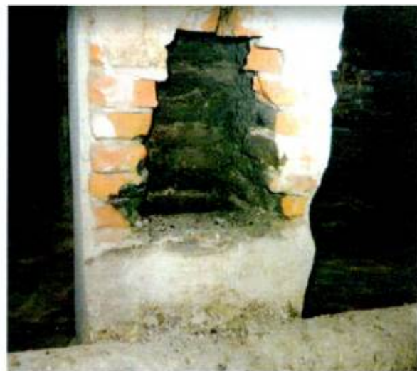
Вид на дымовой канал из помещения чердака
