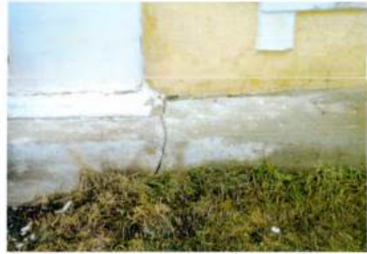
Фрагмент юго-западного фасада. Вид на цоколь. Фото 2023г.
