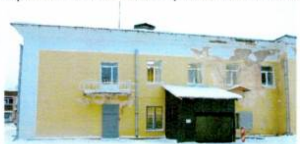
Северо-восточный фасад. Фото 2023г.
