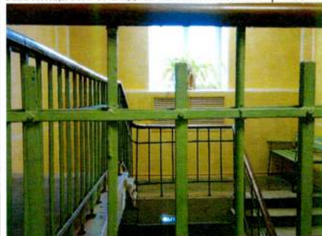
Лестница ЛК 1. Вид на ограждение
