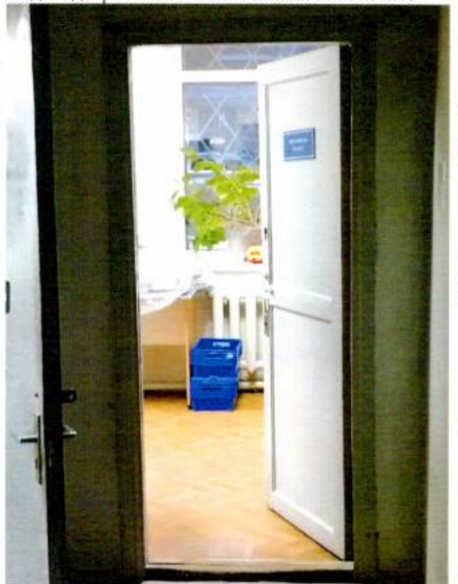
Вид на дверное заполнение и наличник дверного проема пом.17
