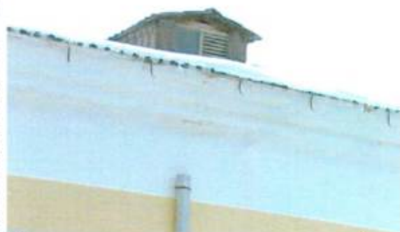
Вид со стороны юго северо-восточного фасада
