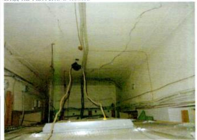
Вид на галтель в пом.6
