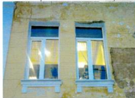
Оконные проемы 2-го этажа по 6,7 световой оси. Ю-з фасад
