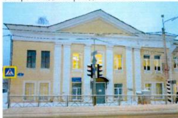
Фрагмент юго-западного фасада. Фото 2023г.
