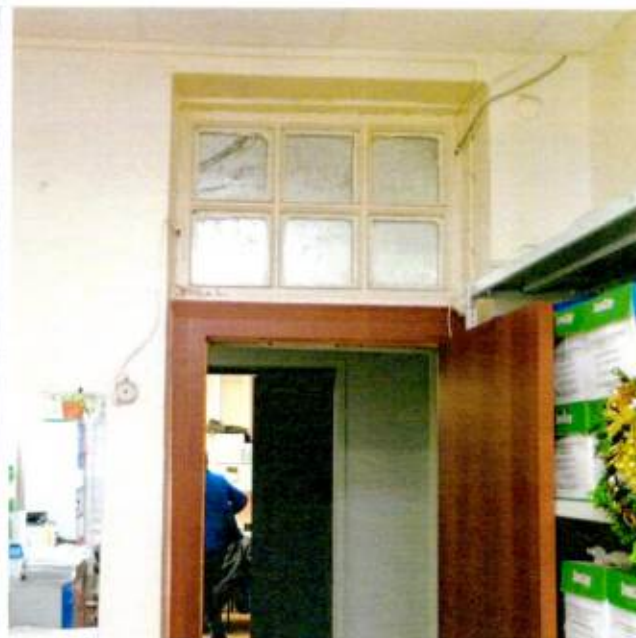
Вид на проем пом.19
