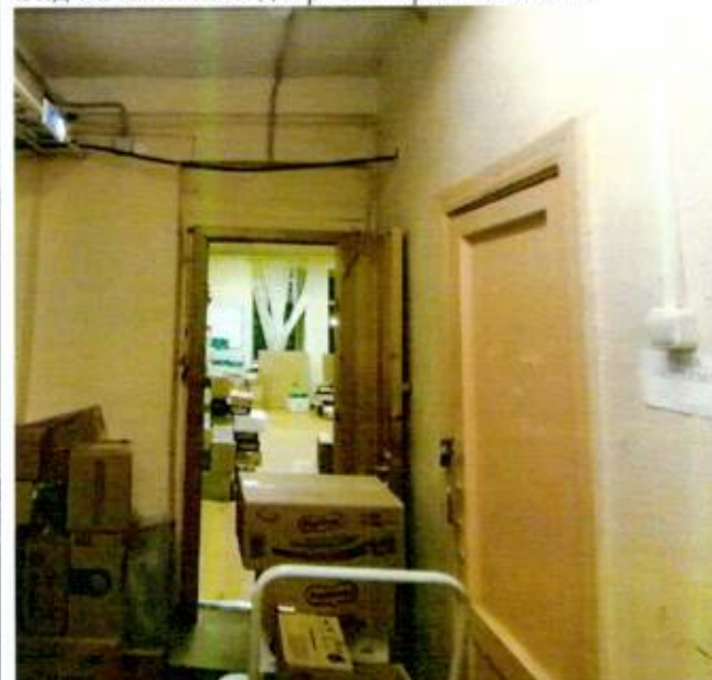
Вид на наличник дверного проема пом.35
