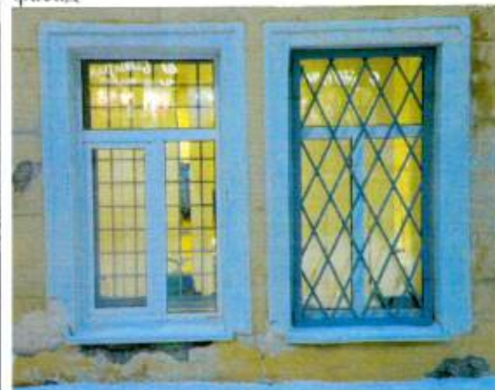
Оконные проемы 1-го этажа по 6,7 световым осям. Ю-в фасад
