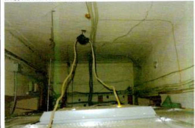
Вид на галтель в пом.2
