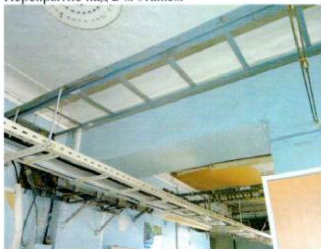
Перекрытие над 2-м этажем
