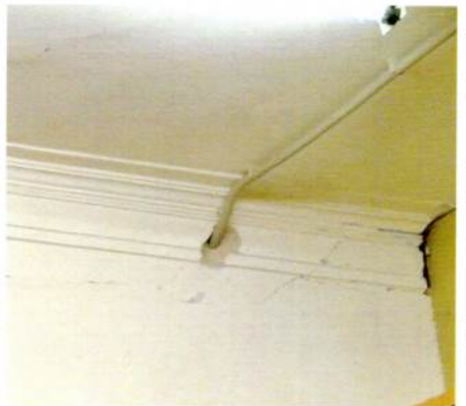
Вид на галтель в пом. 20
