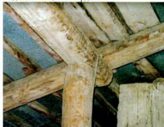
Вид из помещения чердака
