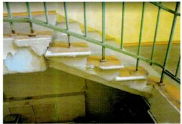
Вид на бетонные ступени лестницы, уложенные по металлическим косоурам
