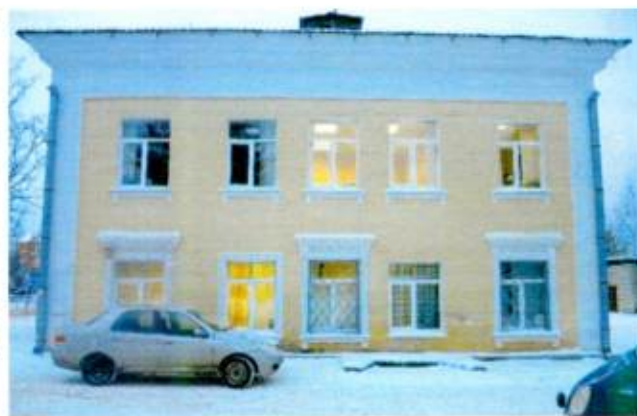
Юго-восточный фасад. Фото 2023г.
