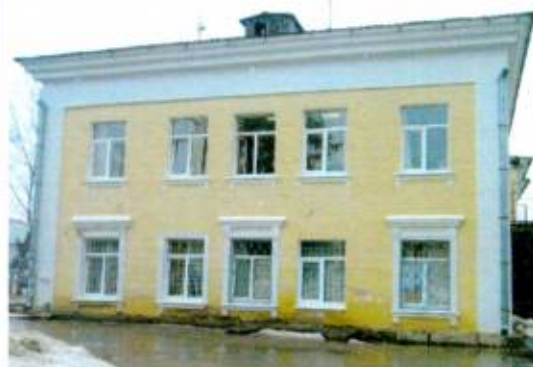
Оконные проемы 1, 2 этажа по 1-5 осям. Ю-в фасад
