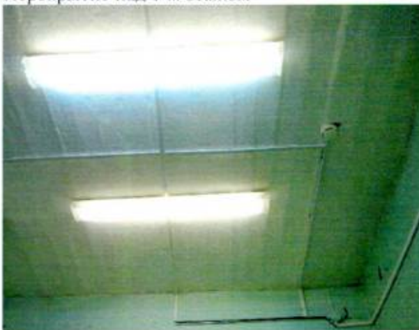
Перекрытие над 1-м этажом
