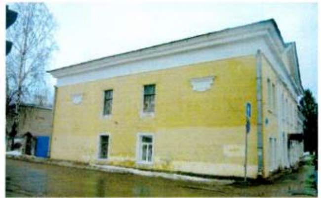
Общий вид здания с северо-запада
