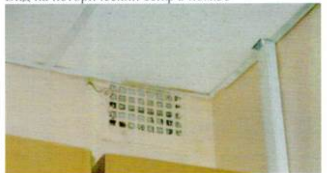
Расположение вентиляционного канала и металлическая решетка. Вид из пом. 11
