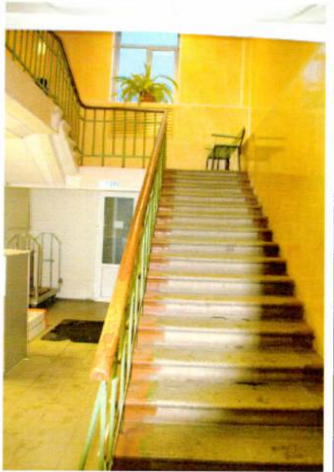
Лестница ЛК 1. Вид на лестницу с 1-го этажа
