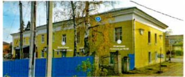
Общий вид здания с северо-востока
