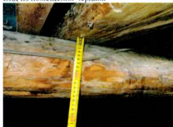
Вид из помещения чердака
