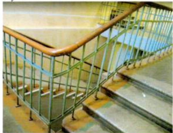
Вид на лестницу Л1
