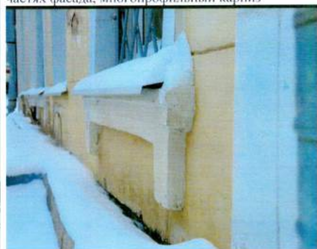
Подоконные тяги с кронштейнами ю-в фасада
