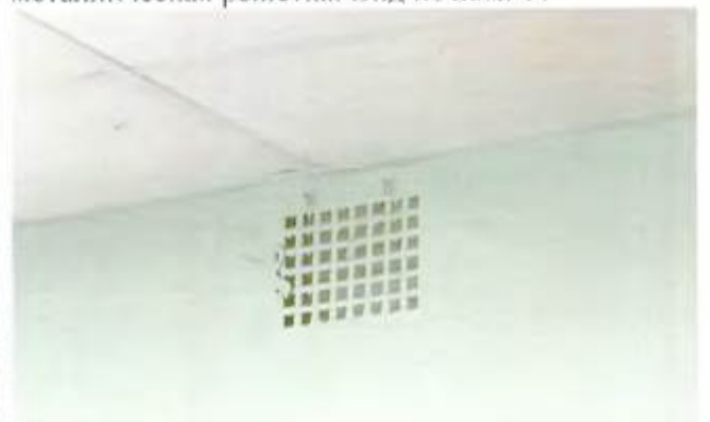
Расположение вентиляционного канала и металлическая решетка. Вид из пом. 7
