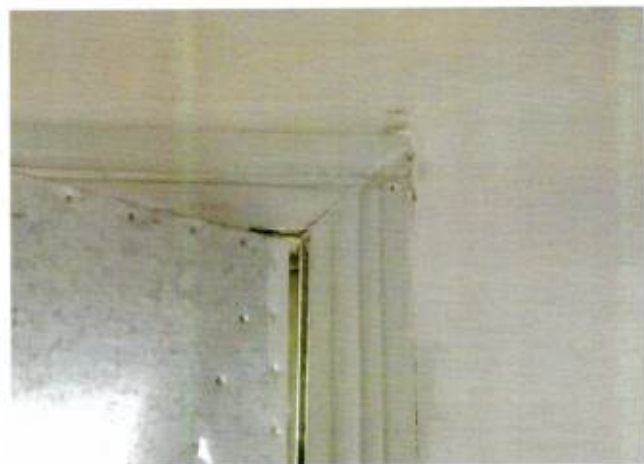
Вид на наличник дверного проема пом.17
