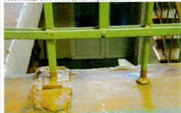
Лестница ЛК 1. Вид на ограждение
