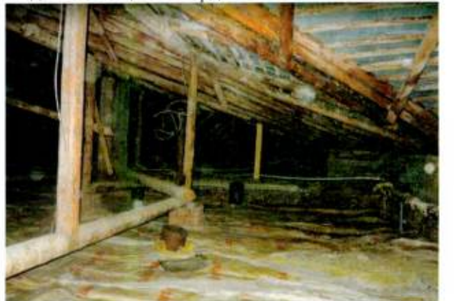
Вид из помещения чердака
