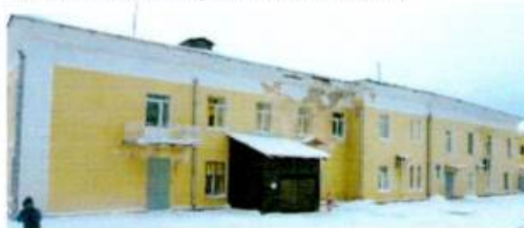
Северо-восточный фасад. Фото 2023г.
