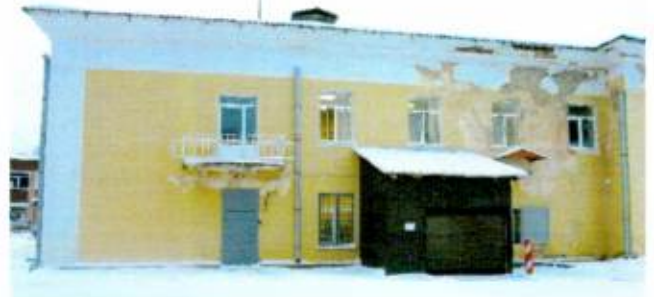
Вид на северо-восточный фасад
