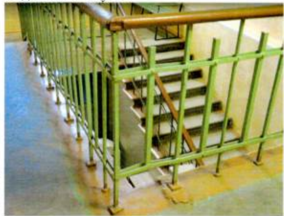
Вид на лестницу Л1 со 2-го этажа
