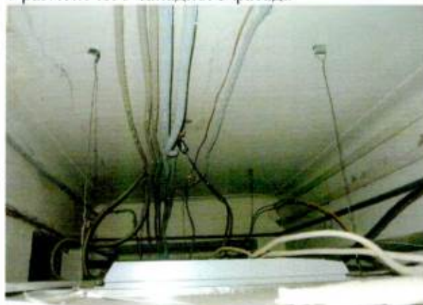
Перекрытие над 1-м этажом
