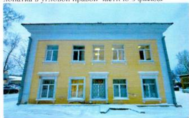
Ю-в фасад. Рустованные лопатки в угловых частях фасада, многопрофильный карниз
