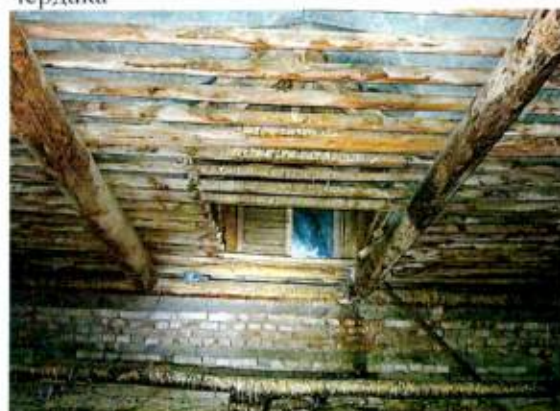
Вид из помещения чердака на конструкции
