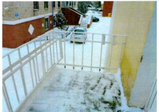
Балкон с-в фасада
