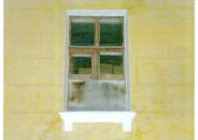
Оконный проем по 2 световой оси с-з фасада
