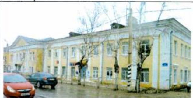
Общий вид здания с юго-востока
