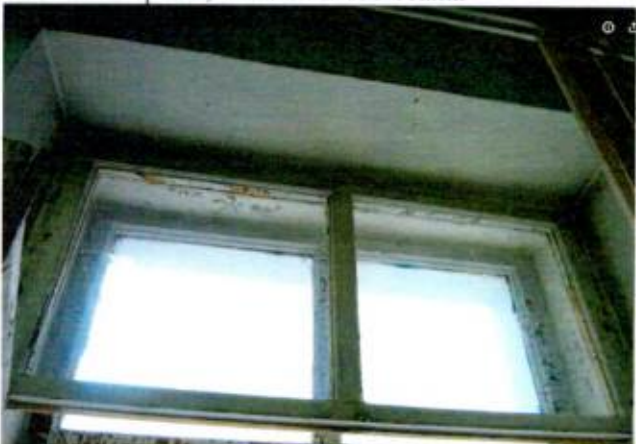
Оконный проем, пом. 30 2-ого этажа
