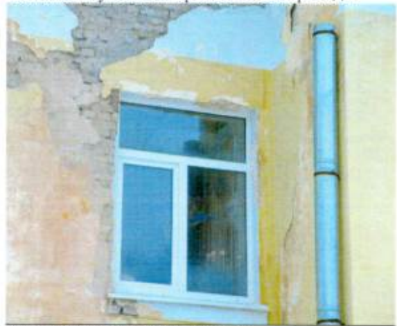
Подоконная тяга с-в фасада
