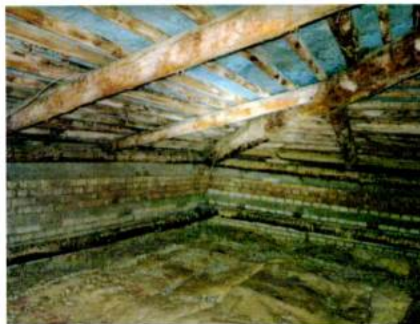
Вид из помещения чердака
