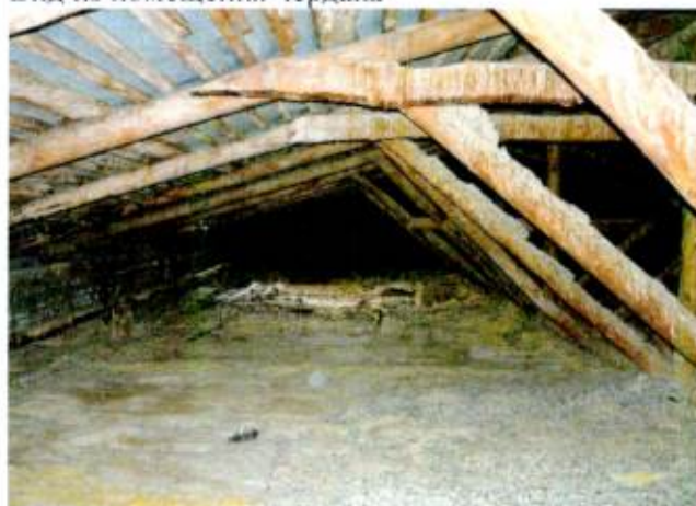
Вид из помещения чердака
