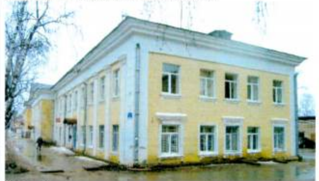
Общий вид здания с юго-востока
