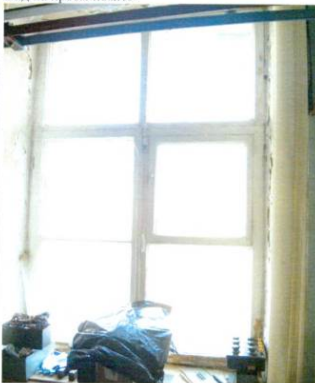
Оконный проем, пом. 29 2-ого этажа
