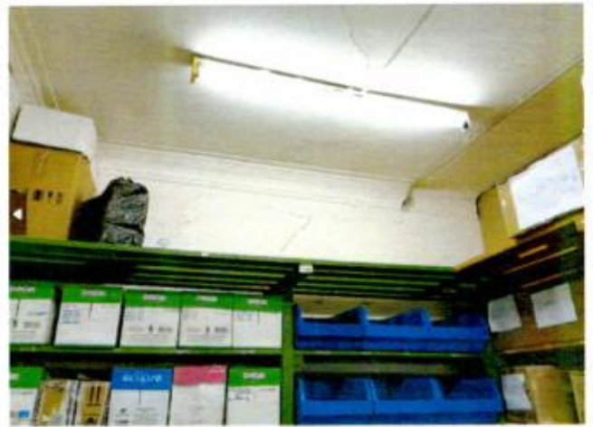
Вид на галтель в пом.20
