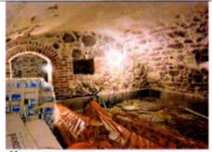
Помещение нижнего яруса дворового крыла. Каменный свод и стены из гранитной и кирпичной кладок
