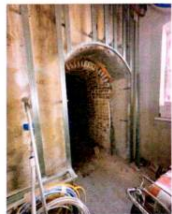
Полукруглый дверной проем. Помещение нижнего яруса в С-В уличной пристройке
