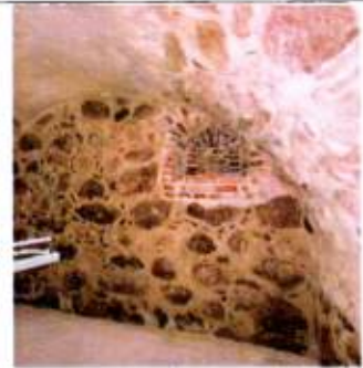
Полуциркульный оконный проем в торце помещения нижнего яруса (уличная часть основного объема)
