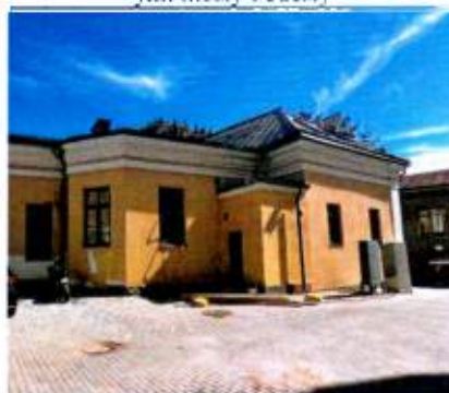
Фасады южной пристройки к уличному объему
