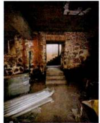
Помещение нижнего яруса дворового крыла. Стены из гранитной и кирпичной кладок
