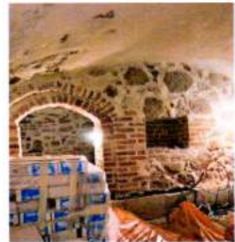
Полукруглый дверной и прямоугольный оконный проемы нижнего яруса (помещение в С-З части дворового крыла)
