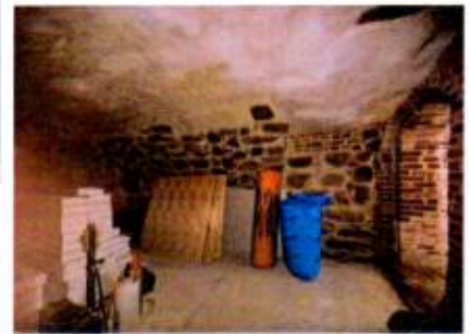
Помещение нижнего яруса уличного объема. Каменный свод, стены из гранитной и кирпичной кладки
