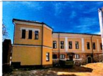
С-В фасады уличной пристройки и восстановленного нижнего яруса дворового крыла
