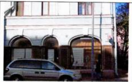
Лицевой Ю-В фасад. Проемы 1-го яруса
