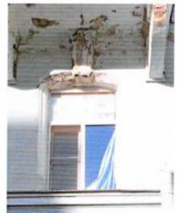
Лицевой Ю-В фасад. Центральный проем 2-го яруса
