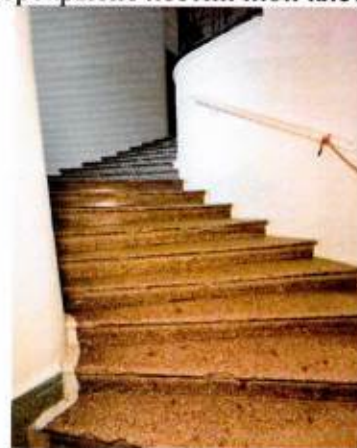
Подъезд № 1. Бетонные ступени нижнего марша
