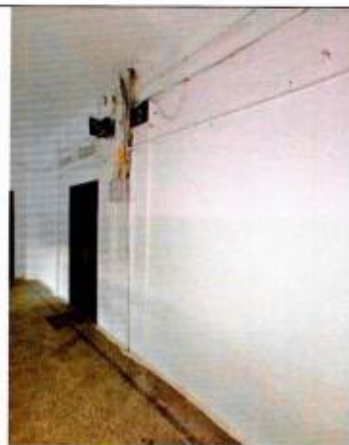
Подъезд № 1. Кирпичные стены
