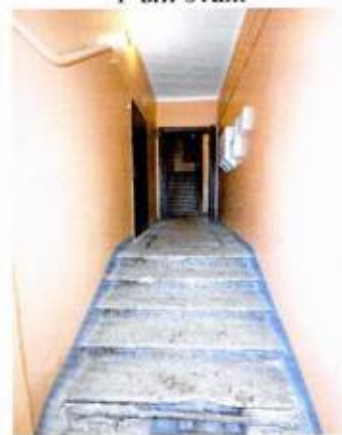
Подъезд № 3. Кирпичные стены, входной нижний марш
