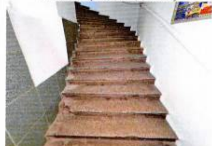
Нижний марш лестничной клетки. Подъезд № 1
