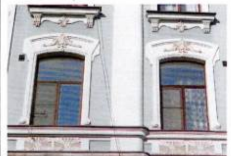
Лицевой Ю-В фасад. Проемы 3-го яруса
