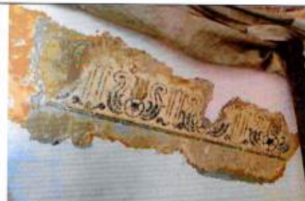
Настенный декор лестничной клетки (подъезд № 1)
