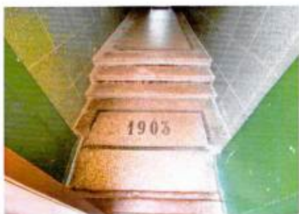
Покрытие пола входной зоны. Подъезд № 1
