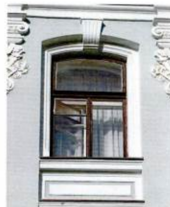
Лицевой Ю-В фасад. Центральный проем 4-го яруса
