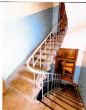
Лестничная клетка. Подъезд № 2
