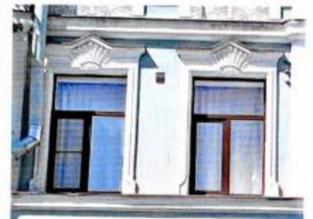
Лицевой Ю-В фасад. Проемы 2-го яруса
