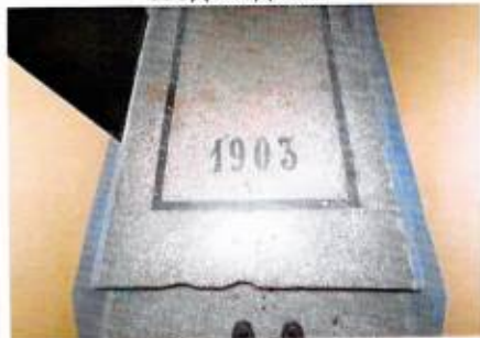
Покрытие пола входной зоны. Подъезд № 3
