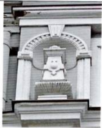
Лицевой Ю-В фасад. Декор в нише простенка центральной части 5-го яруса
