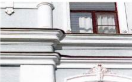
Лицевой Ю-В фасад. Фриз между 4-ым и 5-ым ярусами
