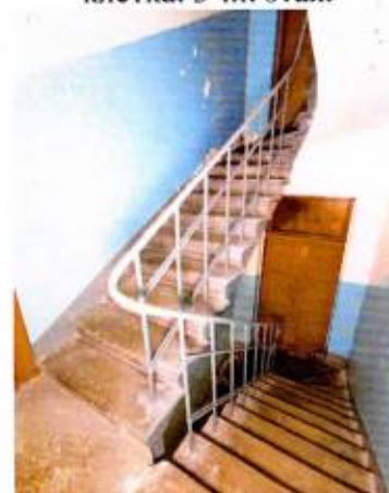
Подъезд № 2. Лестничная клетка
