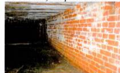
Подвал (Ю-З часть дворового крыла). Кирпичные стены
