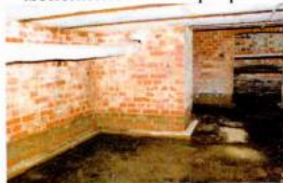
Подвал (С-З часть дворового крыла). Кирпичные стены и монолитное ж/б перекрытие
