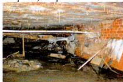
Подвал (западная часть дворового крыла). Кирпичные стены и монолитное ж/б перекрытие
