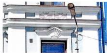
Лицевой Ю-В фасад. Фриз между 2-ым и 3-им ярусами
