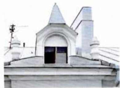
Лицевой Ю-В фасад. Центральный аттик
