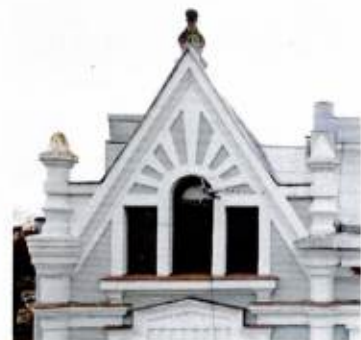
Лицевой Ю-В фасад. Щипец
