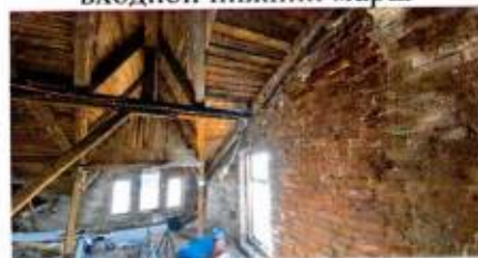
Чердак. Кирпичные стены.
