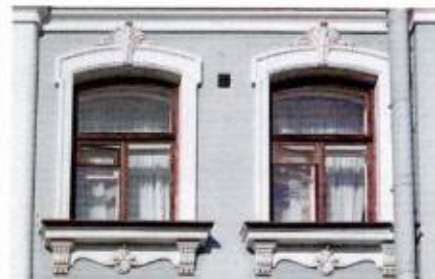
Лицевой Ю-В фасад. Проемы 4-го яруса
