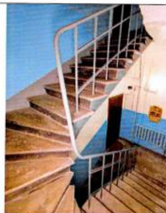
Подъезд № 2. Лестничная клетка
