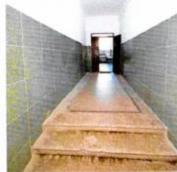
Подъезд № 1. Кирпичные стены. Входные ступени
