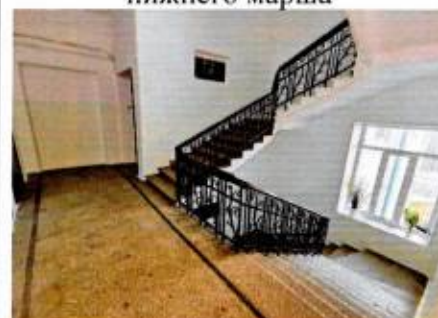
Подъезд № 1. Лестничная клетка. 3-ий этаж
