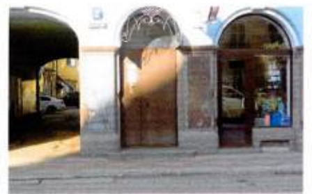
Лицевой Ю-В фасад. Входные ступени проемов по 2-ой и 3-ей осям
