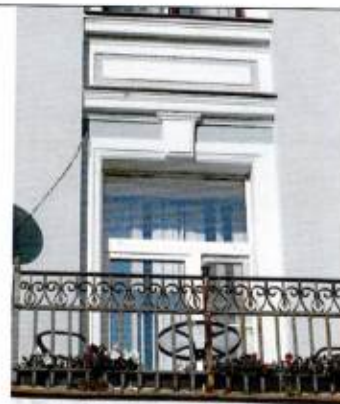
Лицевой Ю-В фасад. Центральный проем 3-го яруса
