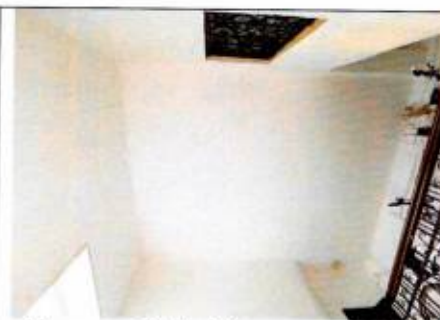
Подъезд № 1. Монолитное ж/б перекрытие лестничной клетки
