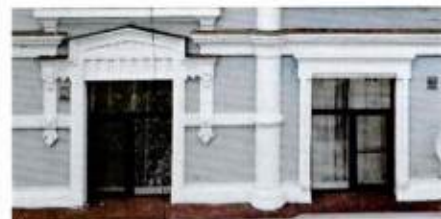
Лицевой Ю-В фасад. Проемы 5-го яруса
