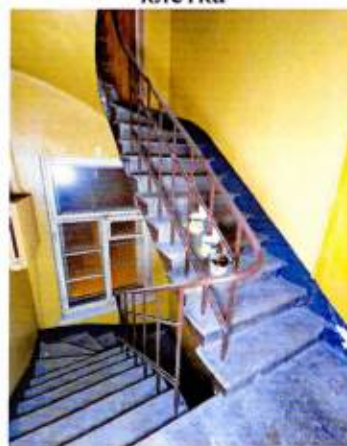
Подъезд № 4. Лестничная клетка
