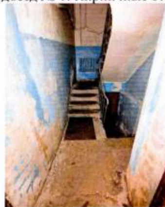
Подъезд № 2. Кирпичные стены. 1-ый этаж
