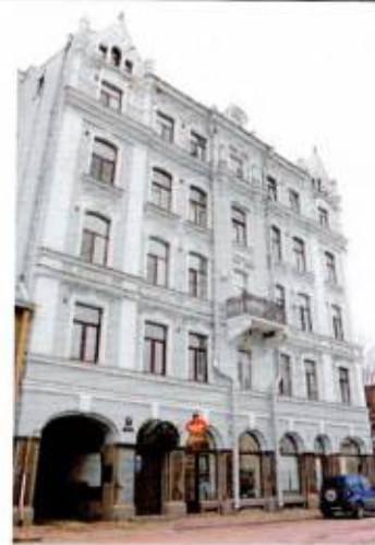
Лицевой Ю-В фасад
