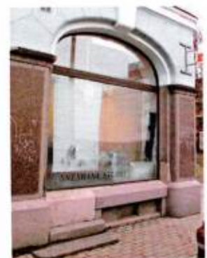
Лицевой Ю-В фасад. Входные ступени проема по 7-ой оси
