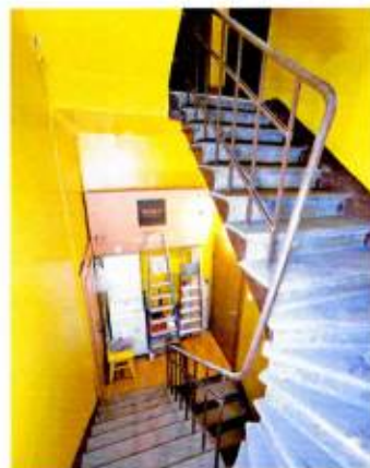
Лестничная клетка. Забежные ступени. Подъезд № 4
