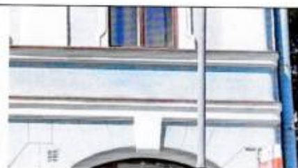
Лицевой Ю-В фасад. Фриз между 1-ым и 2-ым ярусами
