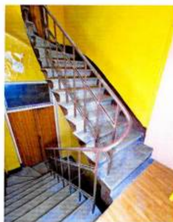
Лестничная клетка. Подъезд № 4
