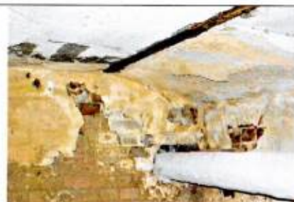
Подвал. Перекрытие монолитное ж/б в восточной части уличного объема
