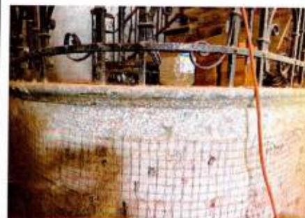
Декоративная облицовка торцевой поверхности лестничной площадки. Подъезд № 1
