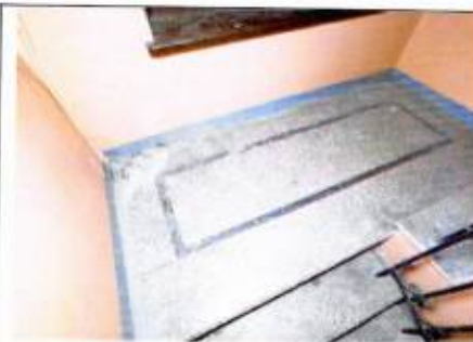
Покрытие лестничной площадки. Подъезд № 3
