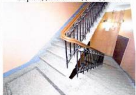
Лестничная клетка. Подъезд № 3
