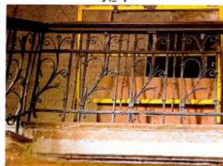
Декоративная облицовка торца лестничной площадки. Ограждение. Подъезд № 1
