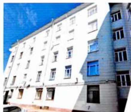
Ю-3 фасад дворового крыла
