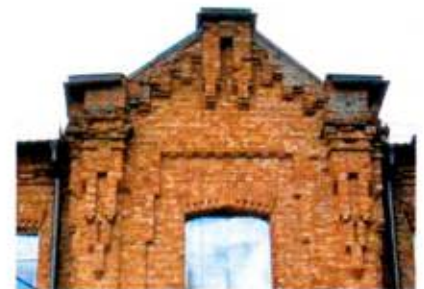
Щипец (ризалит, восточный фасад)
