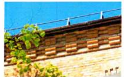
Венчающий карниз (восточный и западный фасады)
