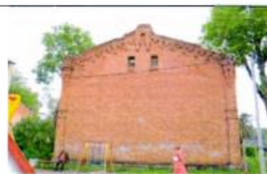
Северный торцевой фасад
