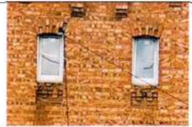
Оформление проемов (торцевые фасады)
