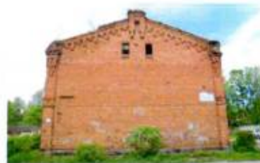
Южный торцевой фасад
