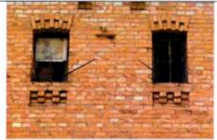
Оформление проемов (торцевые фасады)
