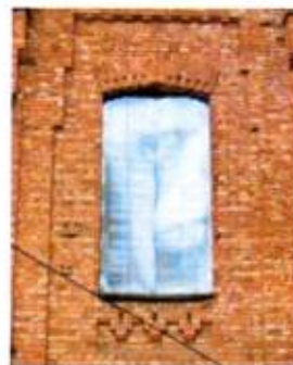
Оформление оконного проема ризалита между 2-ым и 3-им этажами (ризалиты, восточный фасад; ризалиты, верхний проем, западный фасад)
