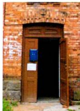
Оформление дверного проема
