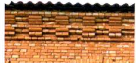
Венчающий карниз (восточный и западный фасады)
