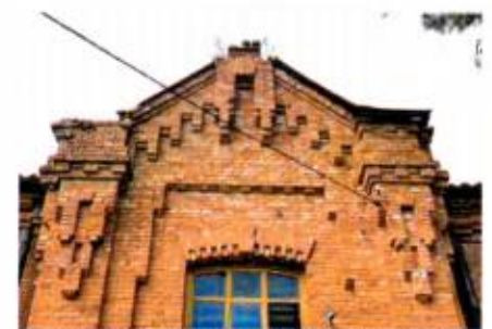
Щипец (ризалит, восточный фасад)
