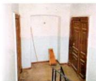
Арочный проем. ЛК-3. 3-ий этаж
