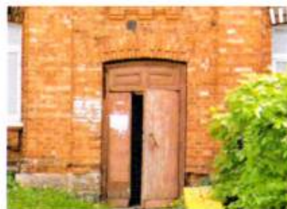
Оформление дверного проема
