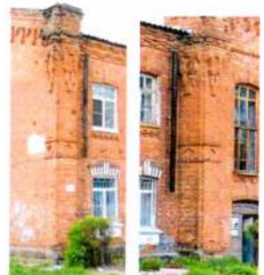
Лопатки, углы фасадов и ризалиты
