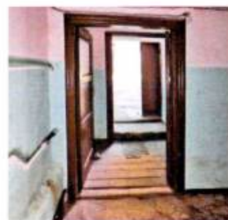
Дверной проем. ЛК-1
