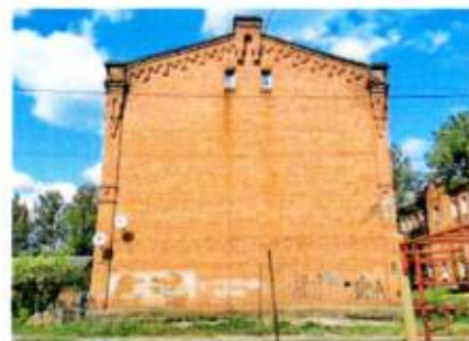
Южный торцевой фасад
