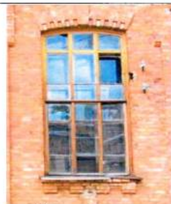
Оформление проема (ризалит, восточный фасад)
