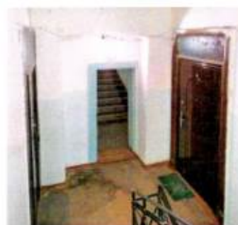
Арочный проем. ЛК-3. 2-ой этаж
