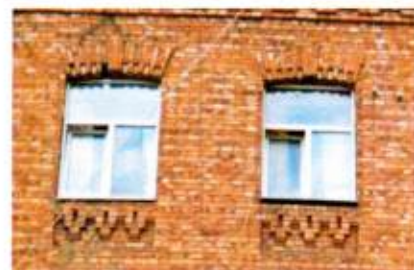
Оформление оконных проемов. 3-ий этаж (квартиры)
