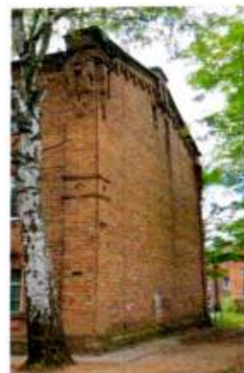
Северный торцевой фасад
