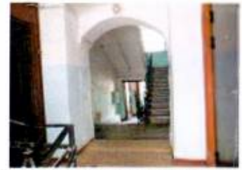
Арочный первоначальный лучковый проем. ЛК-4. 1-ый этаж
