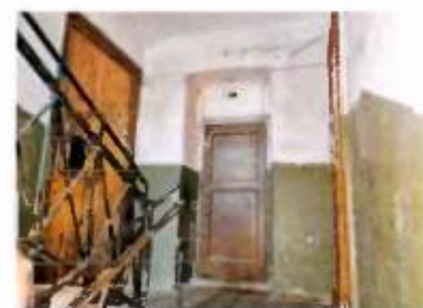
Арочный первоначальный проем. ЛК-2. 2-ой этаж
