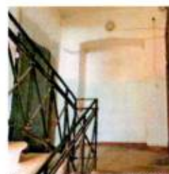
Арочный проем. ЛК-3. 1-ый этаж
