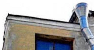
Венчающий карниз (двухэтажный объем пристройки к дворовому западному ризалиту главного дома)
