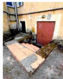
Спуск в подвал. С-В фасад западного дворового крыла
