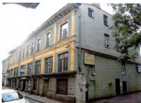
Лицевой Ю-В фасад
