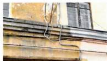
Межэтажный карниз (Ю-В фасад дворового С-3 крыла)
