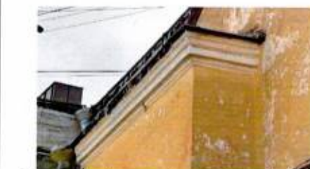
Венчающий карниз (одноэтажный объем пристройки к дворовому западному ризалиту главного дома)
