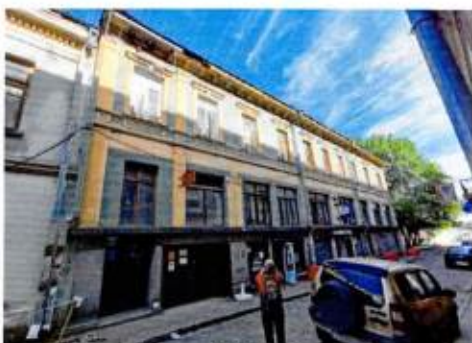
Лицевой Ю-В фасад
