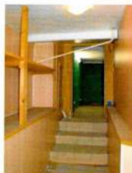
Лестница в помещении в центральной дворовой части главного дома
