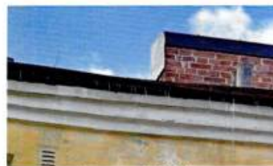
Венчающий карниз (С-В фасад дворовой западной пристройки)
