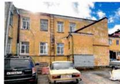
Дворовый С-В фасад Ю-3 крыла главного дома
