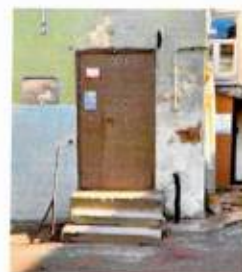
Гранитное крыльцо входа. С-3 фасад северного дворового ризалита главного дома
