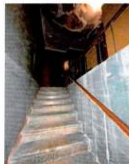
Лестница на жилой этаж в южной части главного дома
