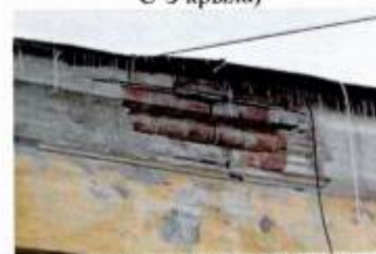
Венчающий карниз (дворовый С-3 фасад и Ю-3 фасад северного дворового ризалита главного дома)
