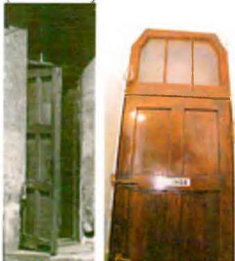
Столярное заполнение входа в одноэтажный объем на южном фасаде.
