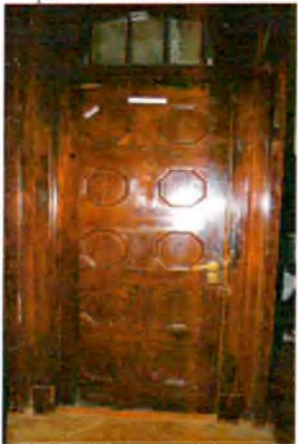
Дверь в подвал.
