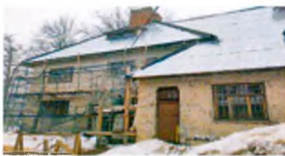
Южный (дворовый) фасад.
