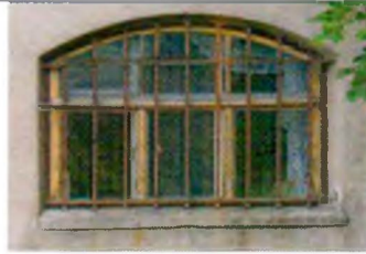
Подоконники из блоков известняка.
