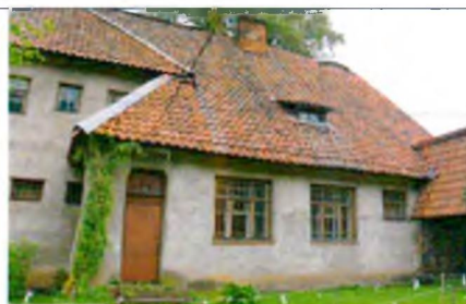
Южный (дворовый) фасад, правая часть.
