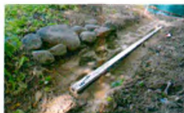
Булыжная отмостка с внутренней стороны ограды.
