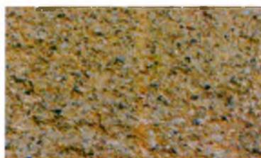
Образец исторической штукатурки на дворовом фасаде дворницкой.
