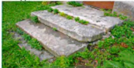
Ступени входа одноэтажной части на двореом фасаде.
