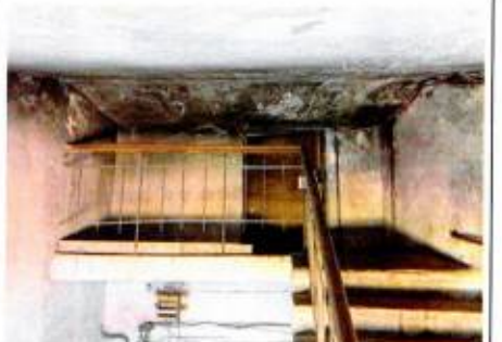
Существующее плоское перекрытие парадной лестницы
