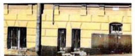
Проемы цокольного яруса и подвала. Лицевой Ю-З фасад
