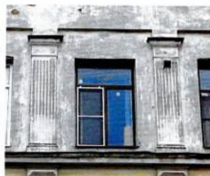
Простенки оконных проемов 3-го яруса. Лицевой Ю-3 фасад
