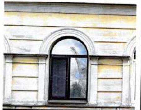
Рустовка 1-го яруса. Лицевой Ю-З фасад
