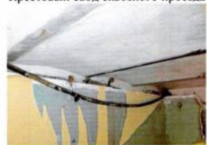
Своды «монье». Подвал
