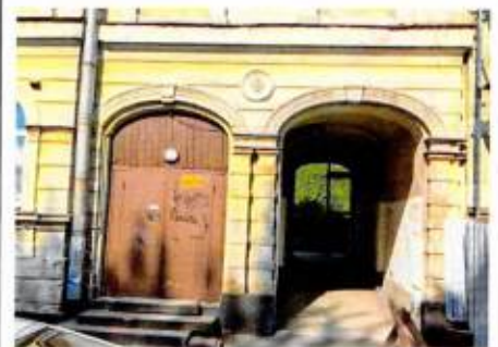
Арочные проемы парадного входа и сквозного проезда
