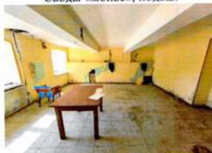
Плоское перекрытие по балкам. Подвал
