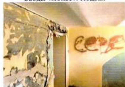
Своды «монье», подвал
