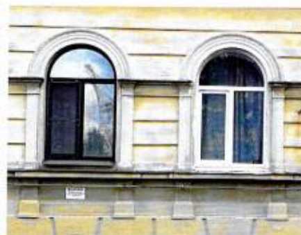
Проемы 1-го яруса. Лицевой Ю-3 фасад
