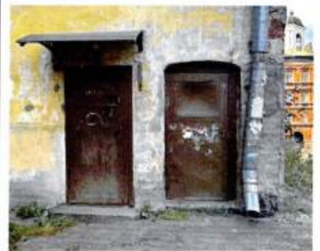
Дверные проемы. Ю-В фасад дворового крыла
