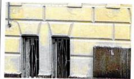
Рустовка нижнего яруса. Лицевой Ю-З фасад
