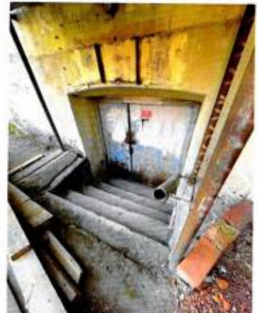
Спуск в подвал. С-В дворовый фасад
