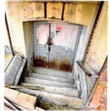
Вход в подвал. С-В дворовый фасад
