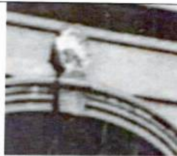
Замковый камень архивольтов арок парадного входа и сквозного проезда. Фото (копия) 1982 г.
