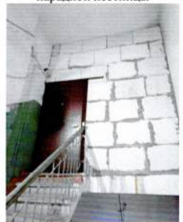
Существующее плоское перекрытие лестничной клетки дворового крыла
