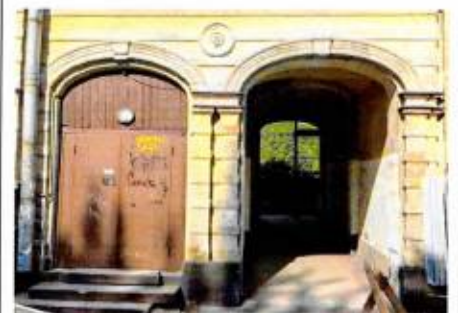
Проемы парадного входа и сквозного проезда. Лицевой Ю-З фасад
