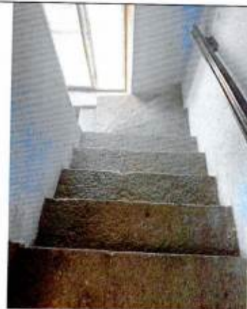
Промежуточный марш лестницы дворового крыла. Гранитные ступени
