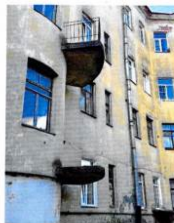
Балконы. Дворовый ризалит
