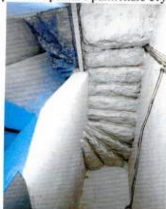
Гранитные ступени промежуточного марша лестницы дворового крыла
