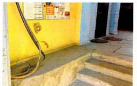
Опорные стены лестницы парадного входа
