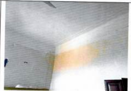
Плоское перекрытие (квартира, 3-ий этаж)
