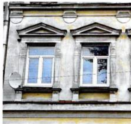
Проемы 2-го яруса центрального ризалита. Лицевой Ю-3 фасад
