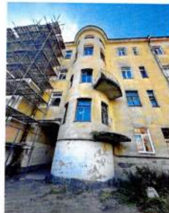
Фрагмент дворового С-В фасада. Левая часть
