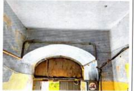
Существующее плоское перекрытие входной зоны
