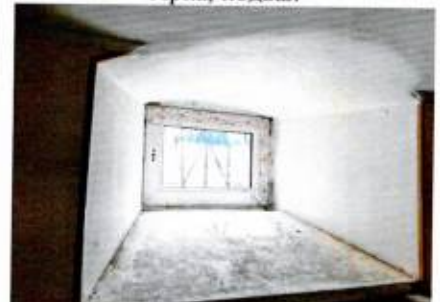
Распалубка арочного оконного проема, подвал
