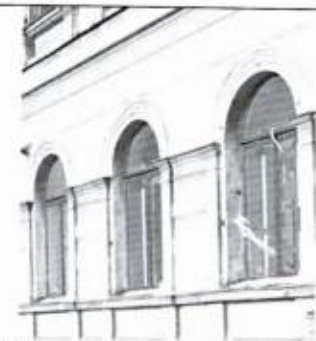
Оконные проемы 1-го яруса. Лицевой Ю-3 фасад. Фото (копия) 1940 г.
