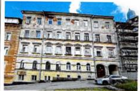
Лицевой Ю-З фасад
