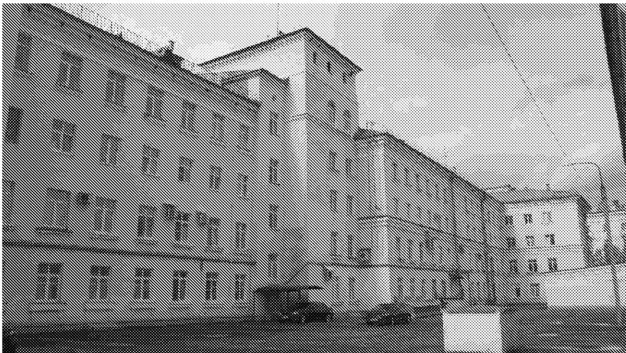
Фото 11. Восточный фасад центральной части здания и северного крыла. Вид со двора
