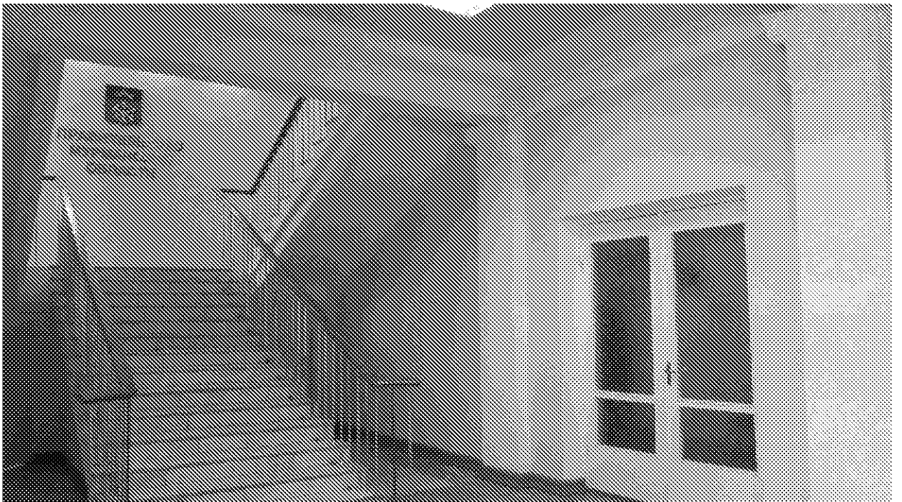
Фото 14. Трёхмаршевая лестница в центральной части здания
