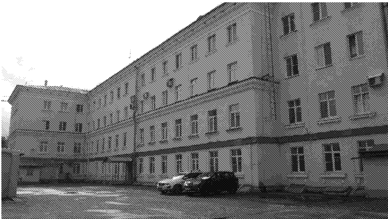
Фото 12. Восточный фасад центральной части здания и южного крыла. Вид со двора
