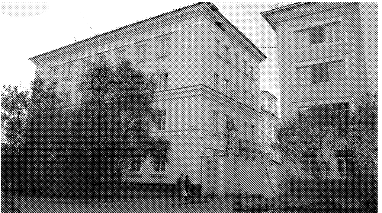
Фото 8. Боковой южный фасад южного крыла здания. Вид с юга, с улицы Профсоюзов
