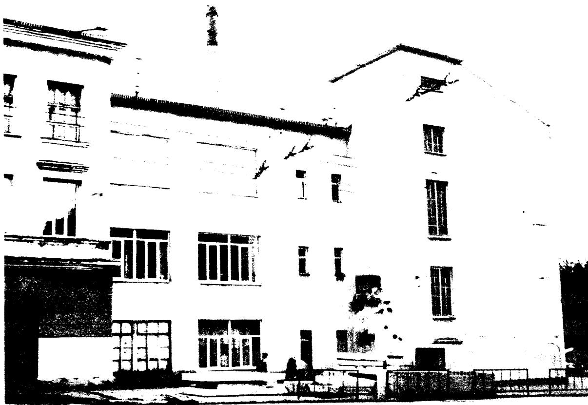
Фото 4. Северный фасад первоначальной части здания. Вид со стороны улицы Академика Кинповича
