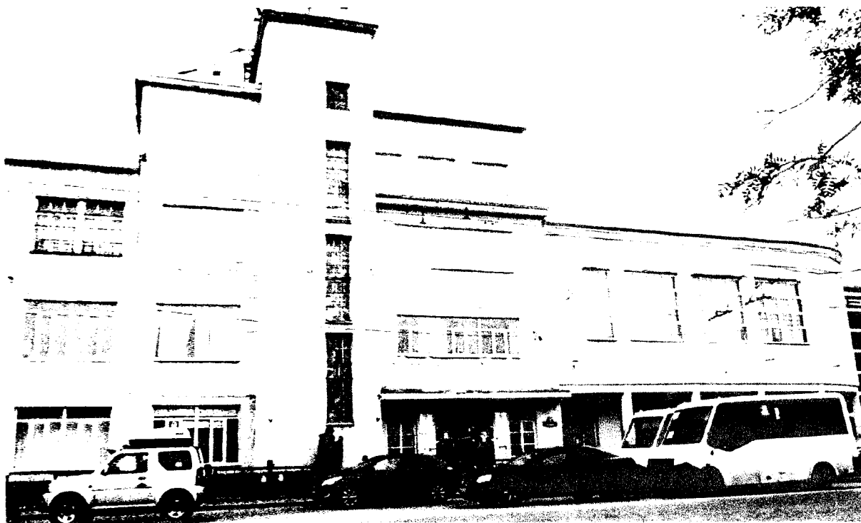
Фото 3. Южная часть западного фасада здания со стороны улицы Шмидта
