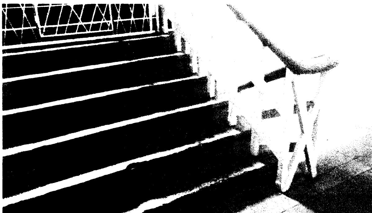
Фото 14. Лестница в центральной части здания. Первоначальные ступени лестницы и первоначальные деревянные перила
