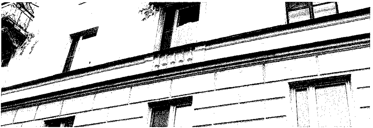
Фото 9. Две параллельные профилированные тяги, расположенные между 2-м и 3-м этажами, проходящие по всему периметру здания.
