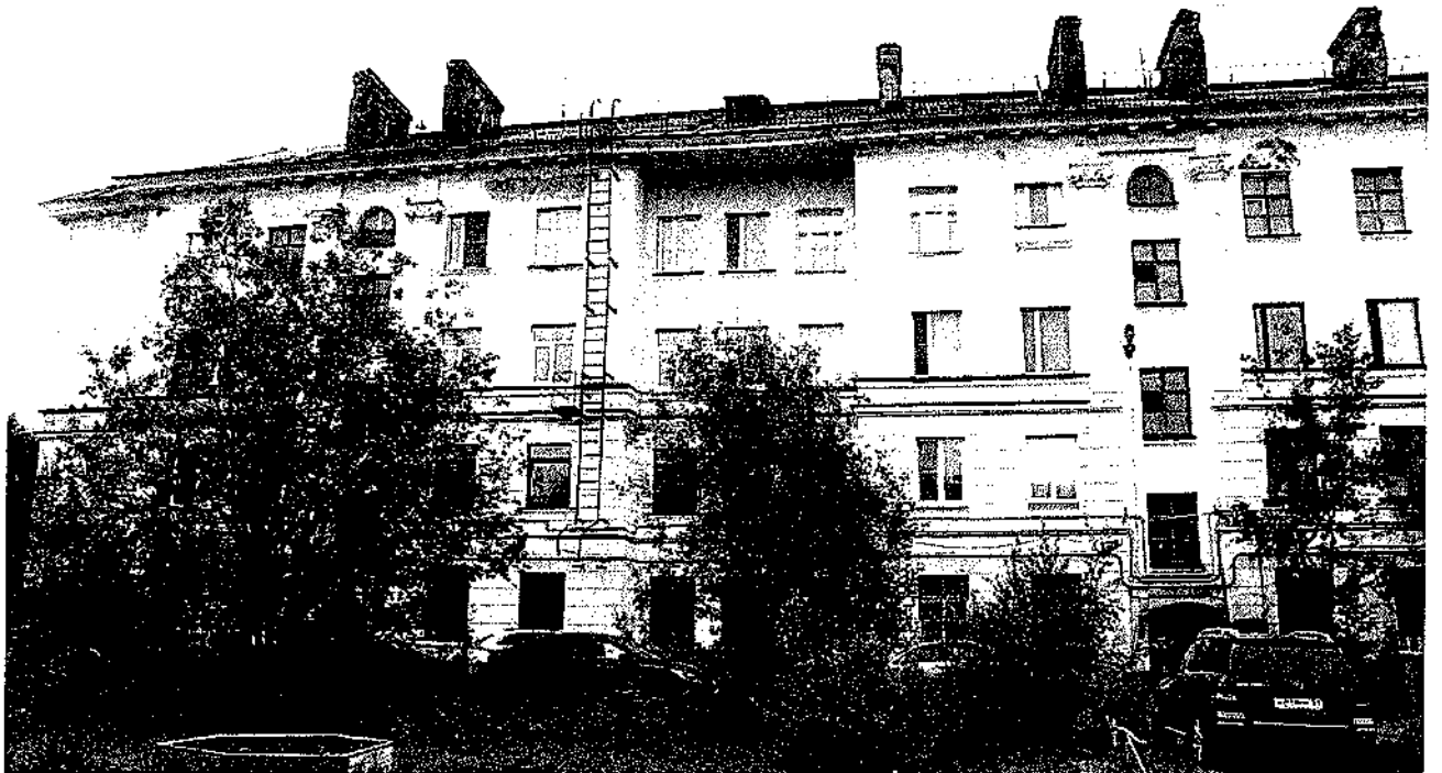
Фото 6. Северная часть северо-западного фасада.
