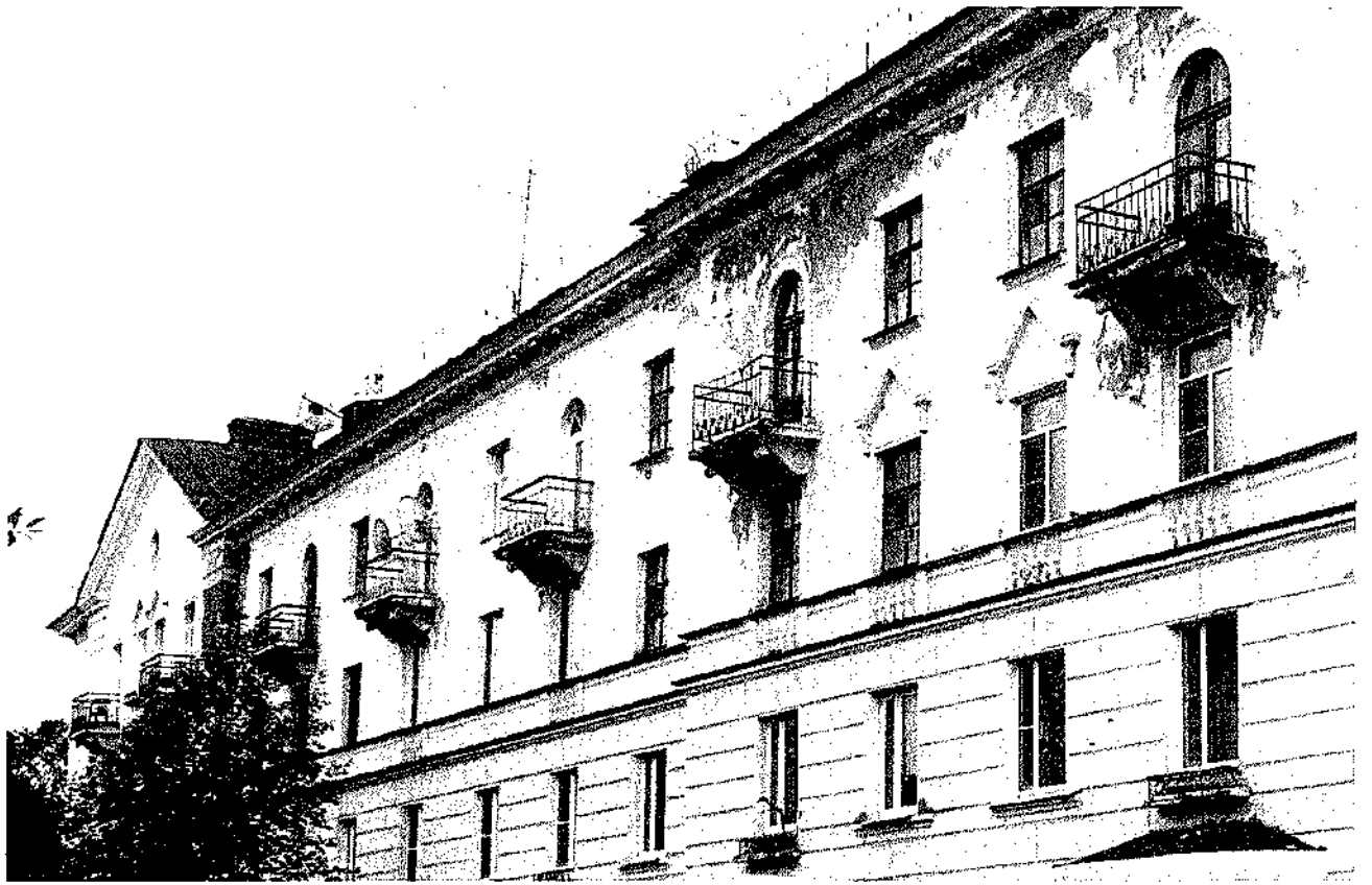
Фото 11. Балконы в уровне 4-го этажа.
