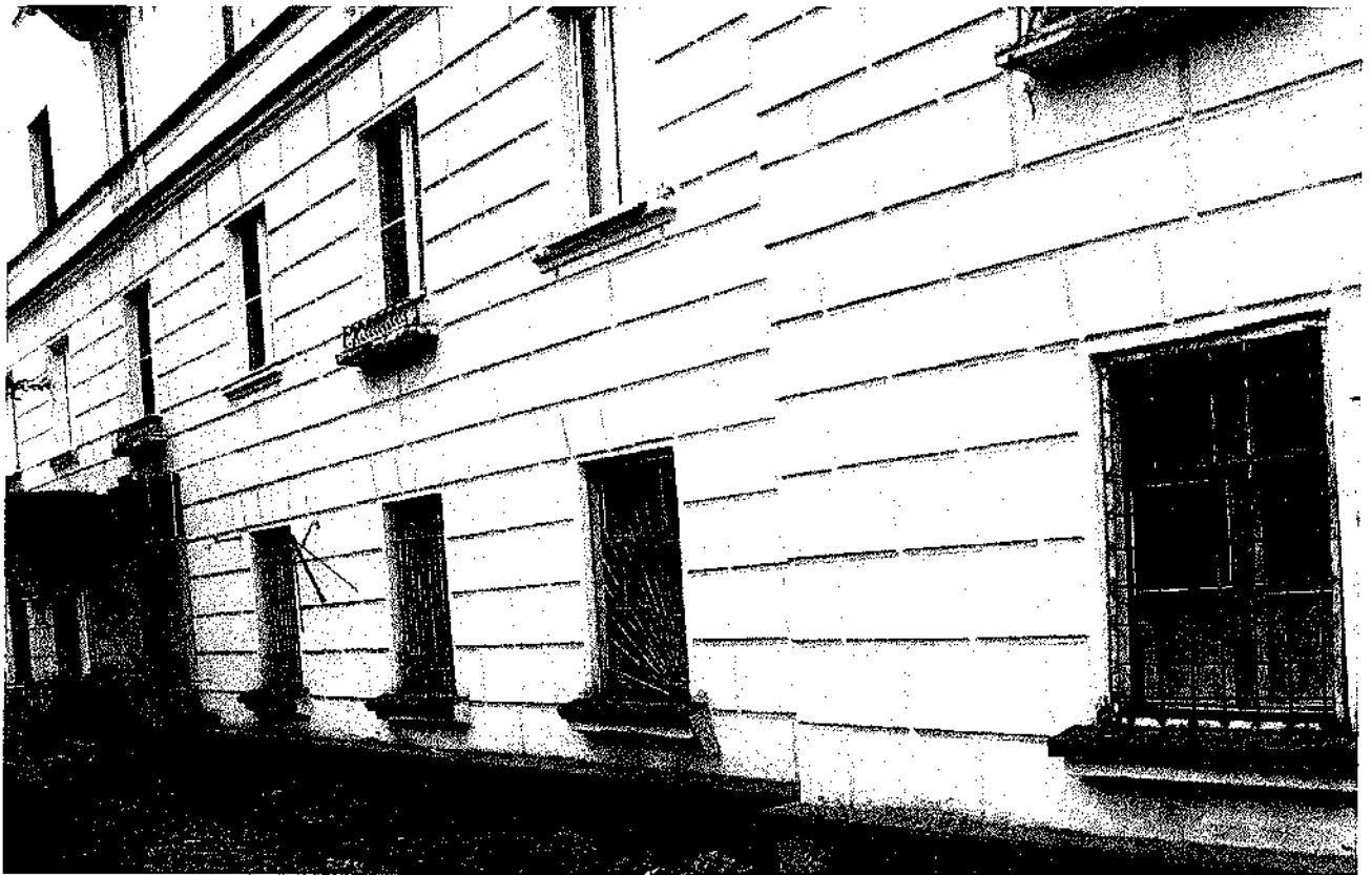
Фото 10. Отделка наружных стен рустом в уровне 1-го и 2-го этажа.
