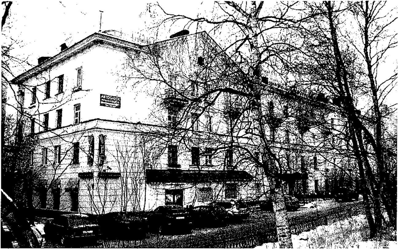
Фото 3. Юго-восточный и торцевой юго-западный фасады, вид с юго-запада.
