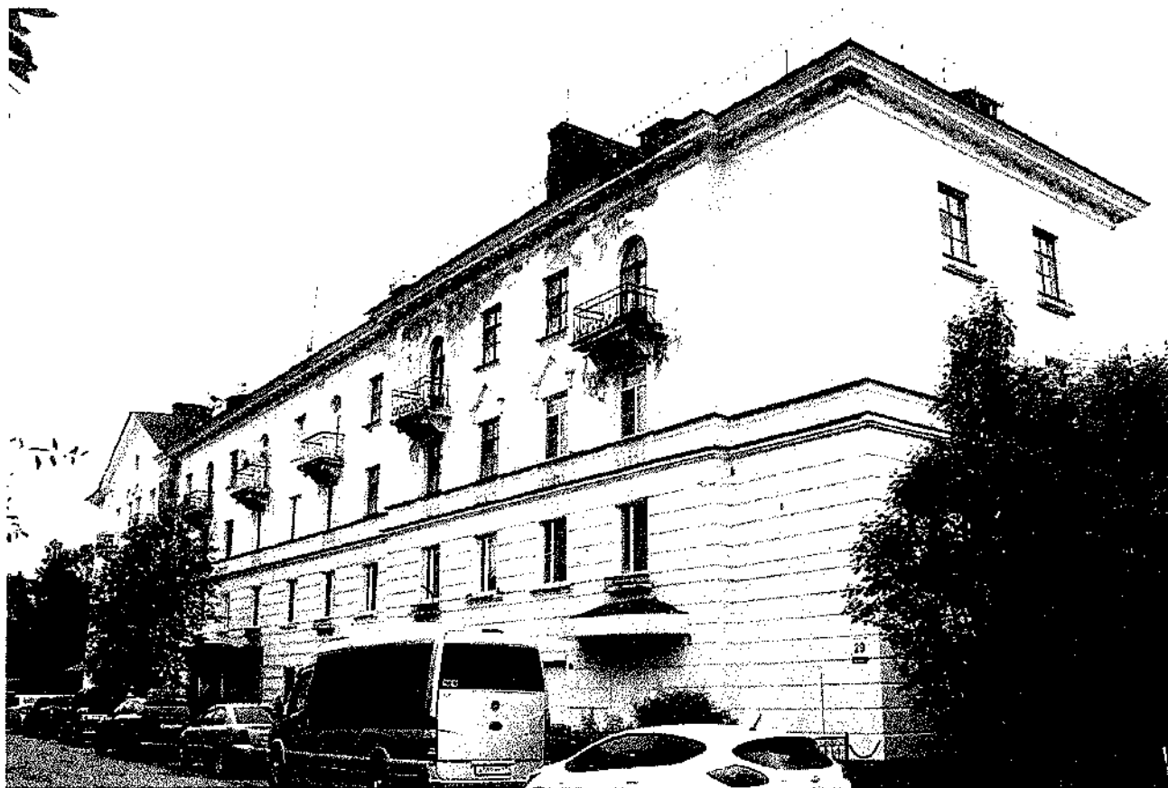
Фото 1. Юго-восточный и северо-восточный (торцевой) фасады, вид с востока.
