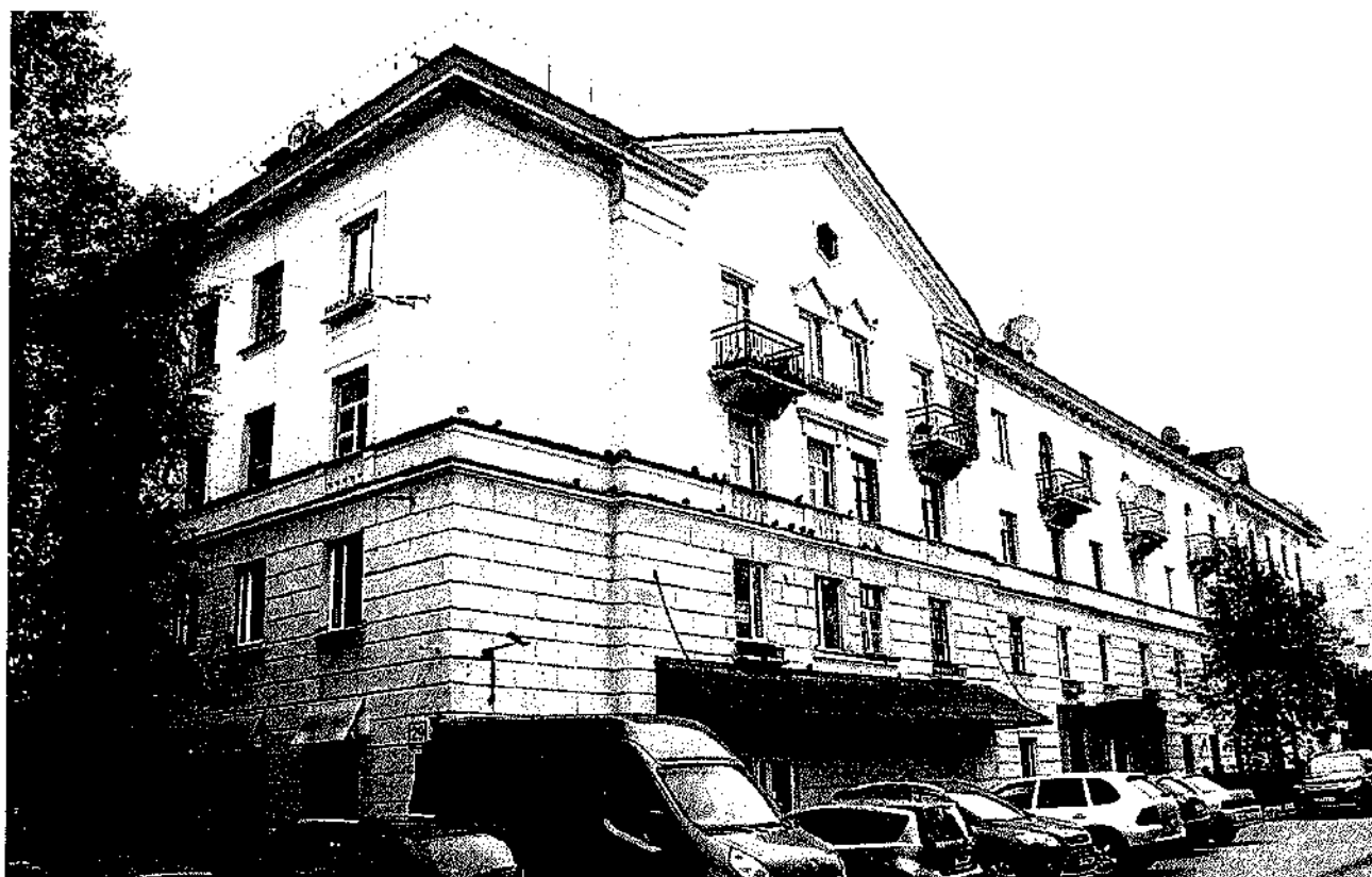
Фото 2. Юго-восточный и юго-западный (торцевой) фасады, вид с юго-запада.
