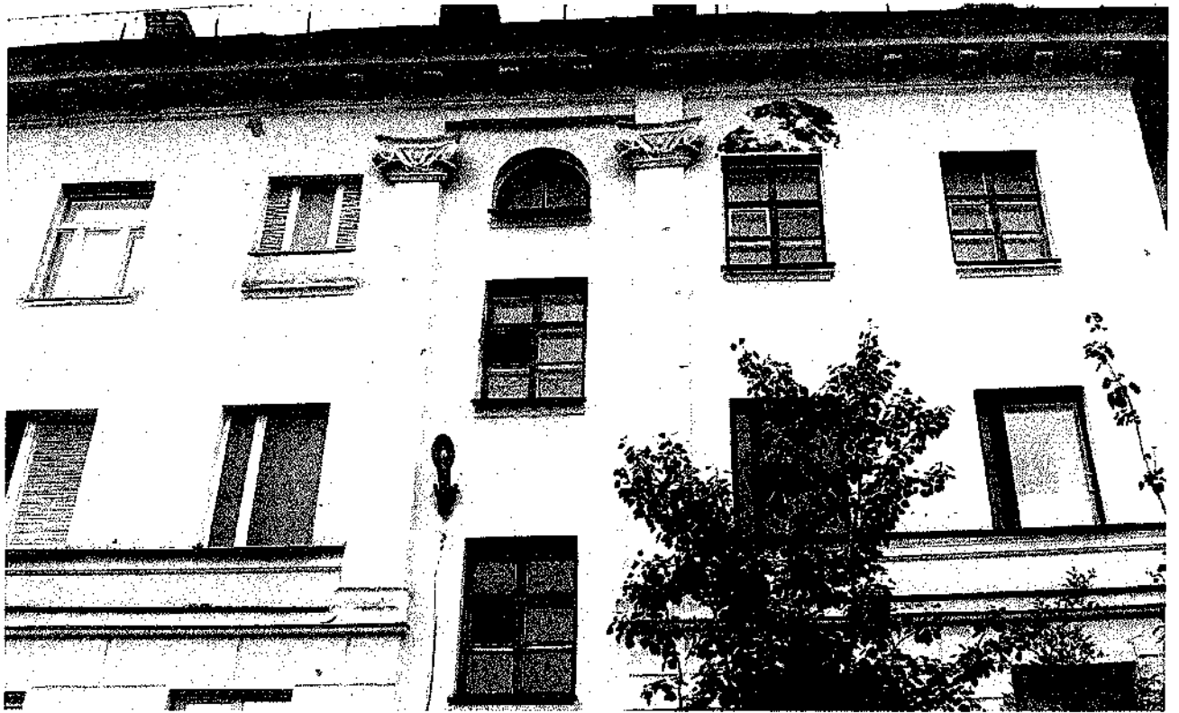
Фото 13. Пилястры с капителями композитного ордера, расположенными по бокам лестничных клеток.
