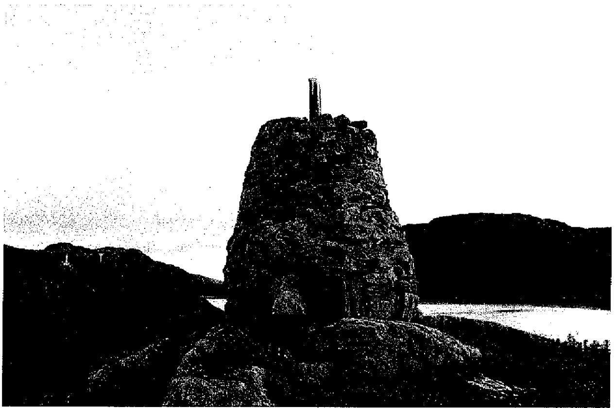
Фото 4. Общий вид. Северная сторона.
