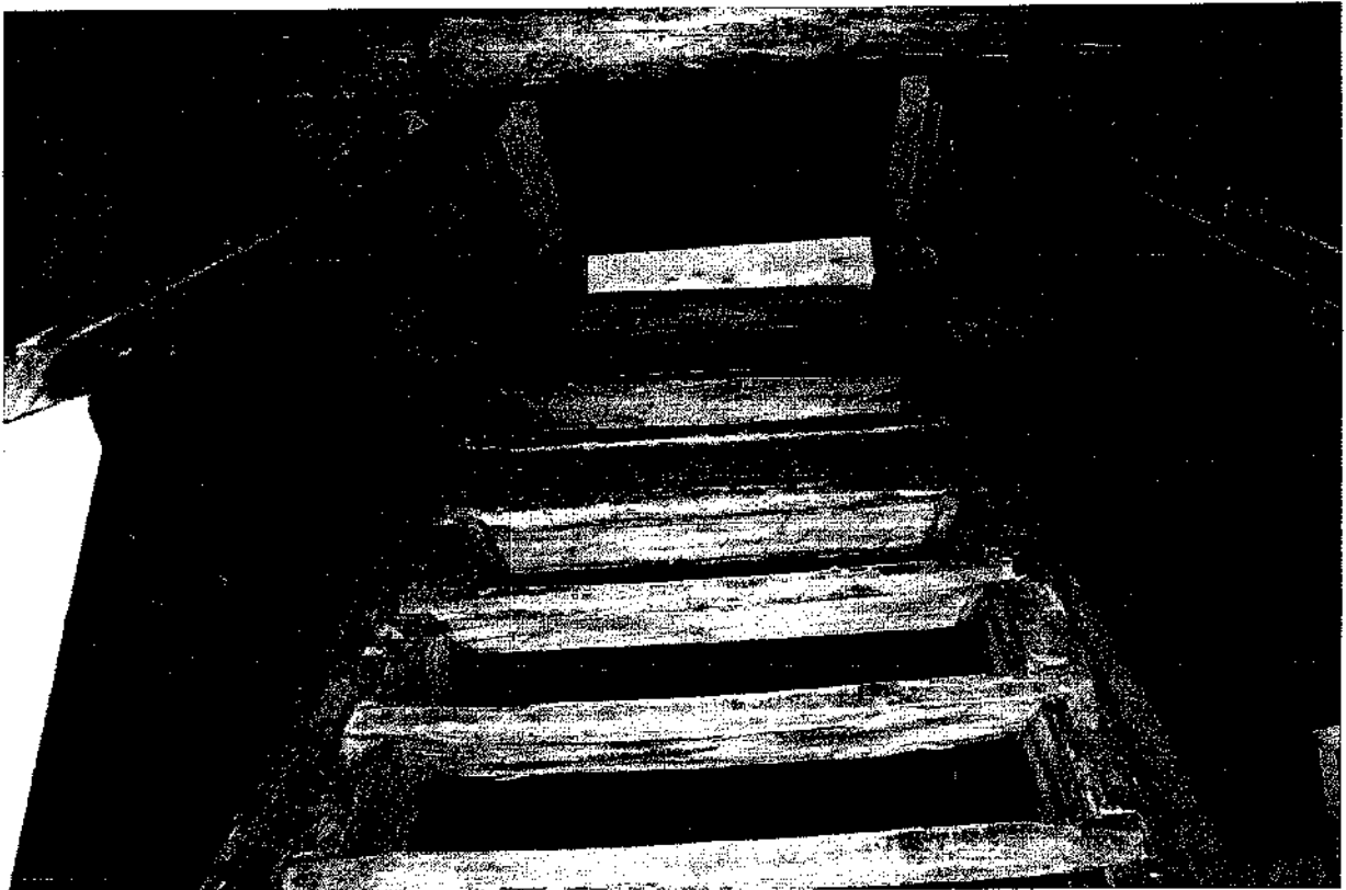
Фото 8. Внутренняя лестница на 1-м этаже колокольни.
