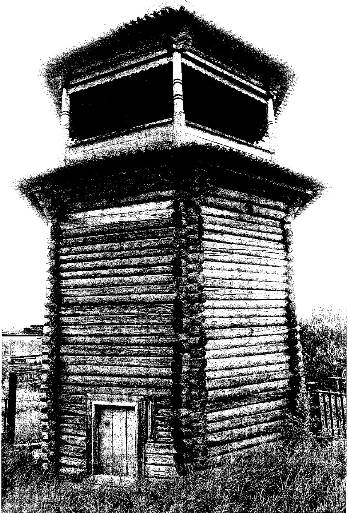
Фото 6. Вид на северо-восточный фасад колокольни.
