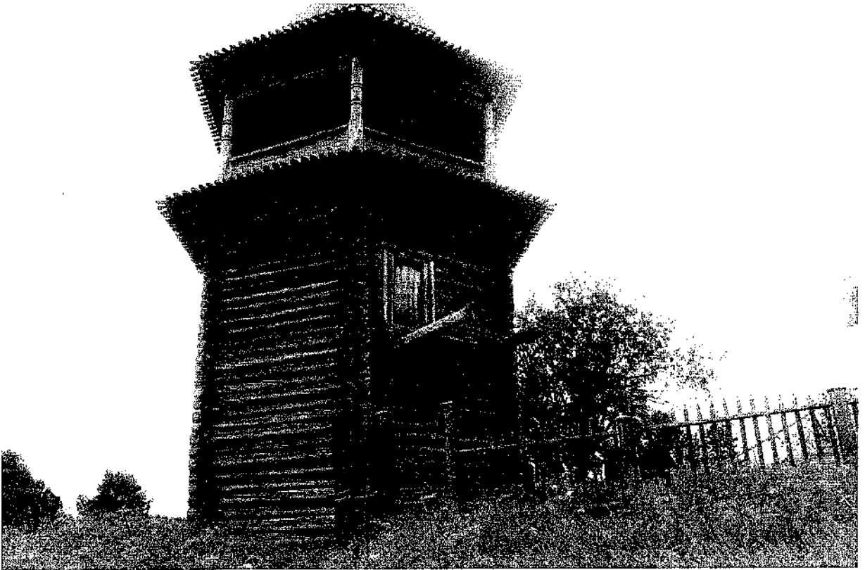
Фото 4. Вид на юго-восточный фасад колокольни.
