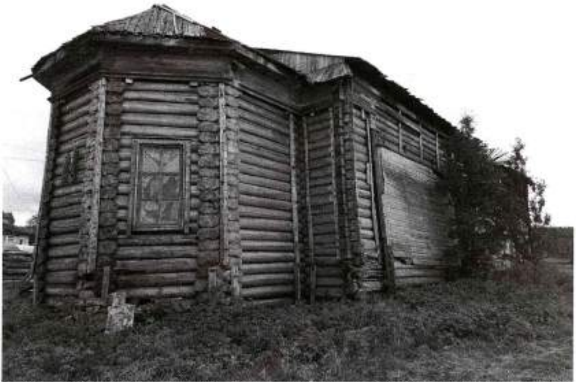
Фото 4. Общий вид с северо-востока. Восточный и северный фасады Церкви Петра и Павла
