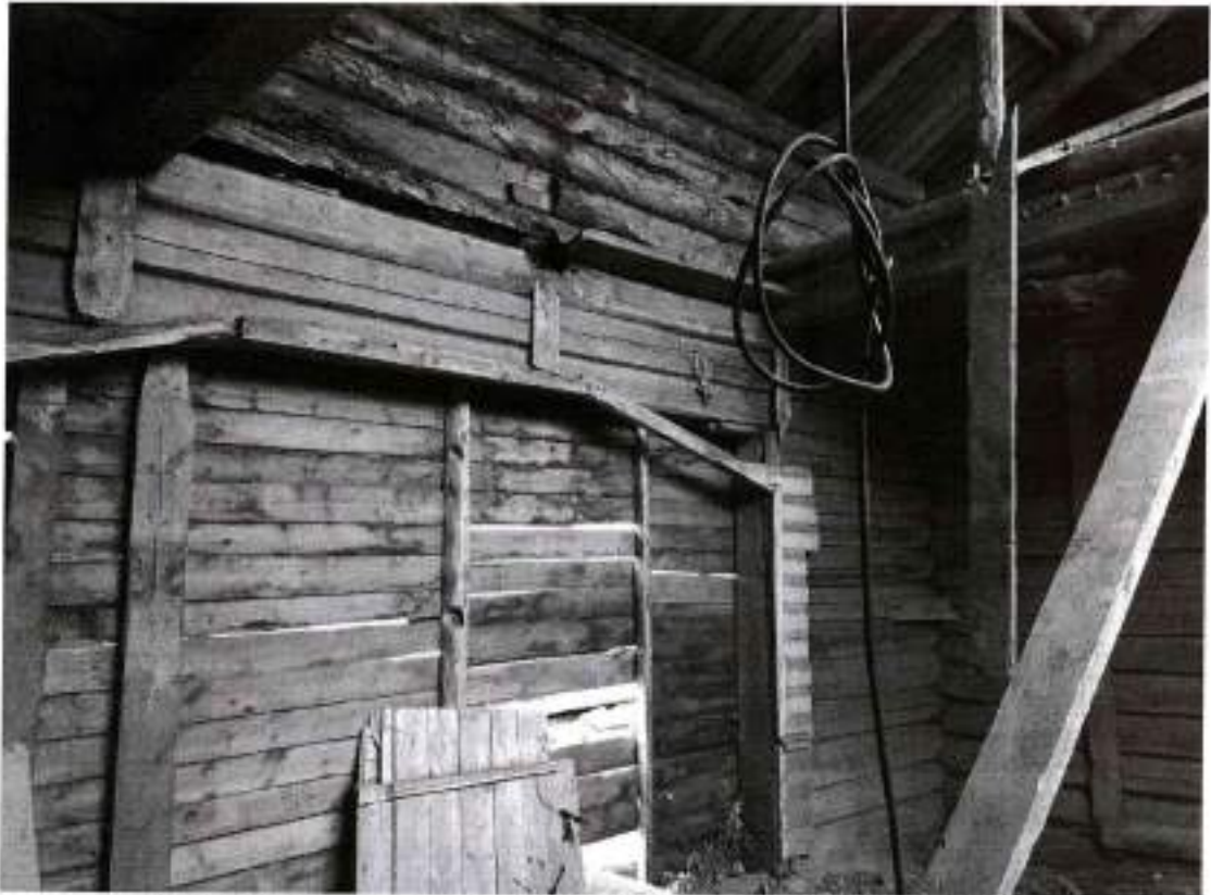
Фото 14. Внутренний проем с трапециевидной перемычкой
