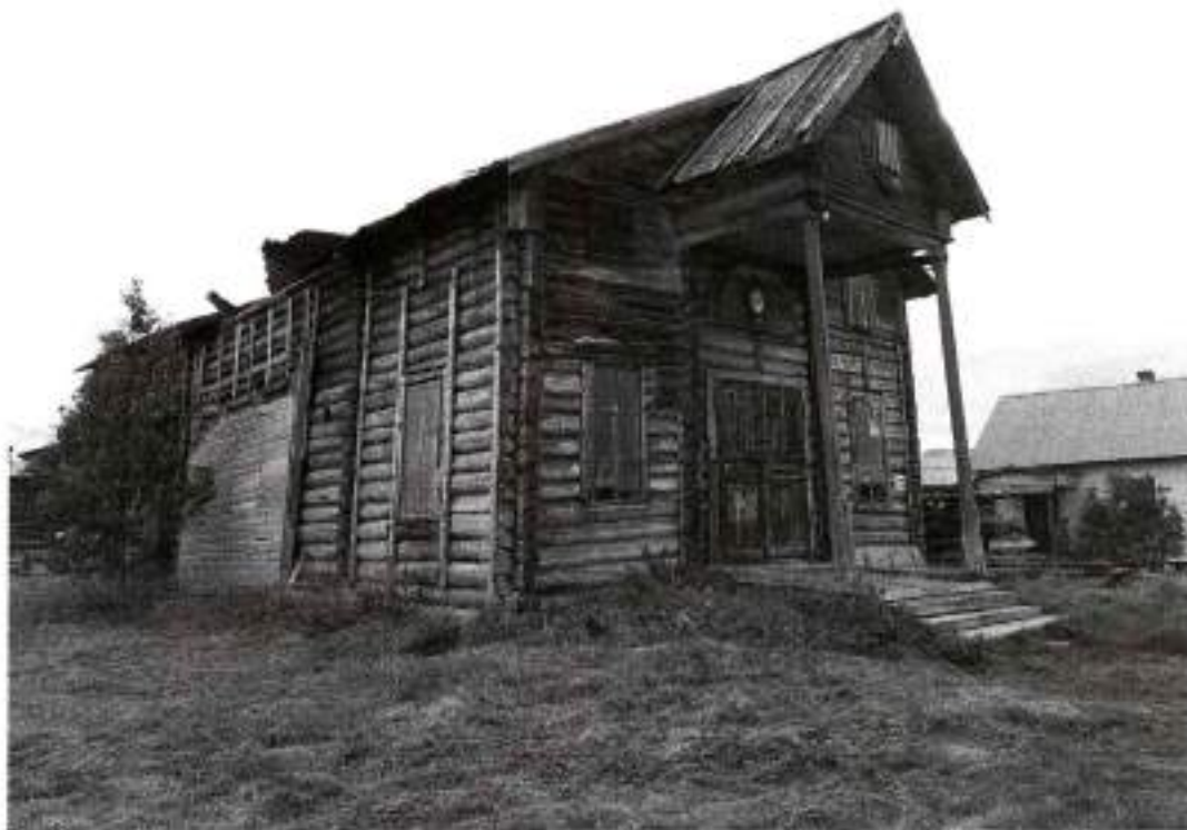
Фото 9. Общий вид с северо-запада. Северный и западный фасады Церкви Петра и Павла
