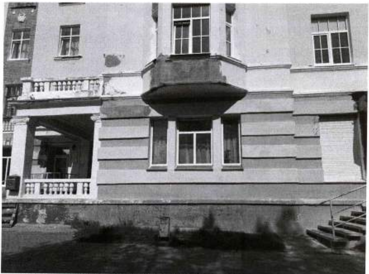
Фото 3. Фрагмент главного южного фасада. Вид с юга на крыльцо и нижнюю часть центрального ризалита
