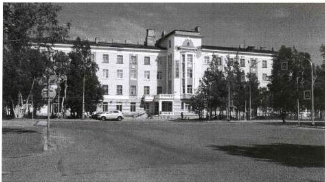
Фото 1. Главный южный фасад. Вид с юга (проспекта Metallургов)
