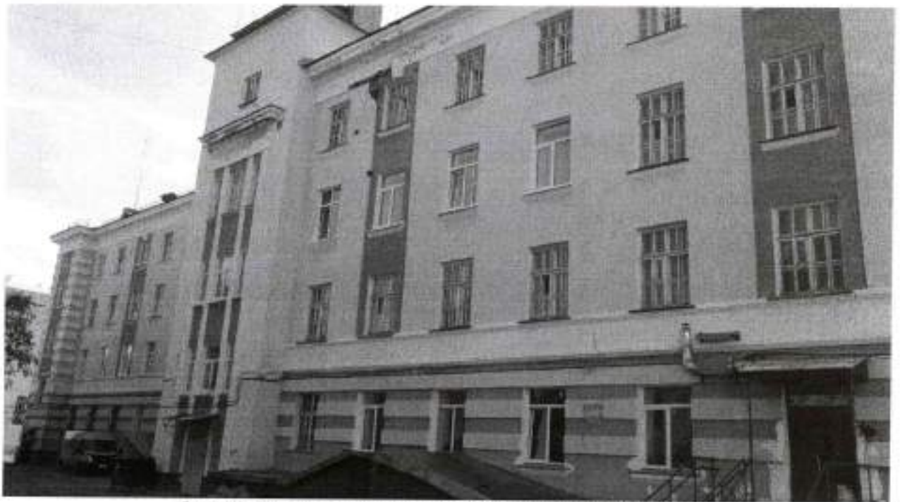
Фото 6. Дворовый северный фасад. Вид с северо-запада
