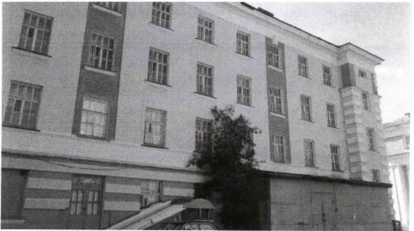
Фото 7. Дворовый северный фасад. Вид с севера
