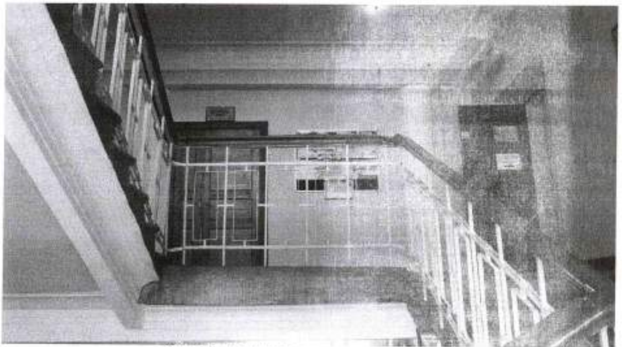
Фото 12. Лестница в центральном ризалите
