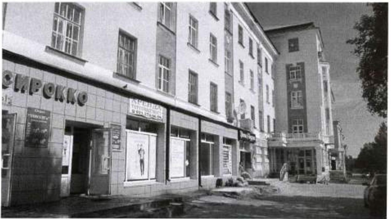
Фото 2. Фрагмент главного южного фасада. Вид с юго-запада
