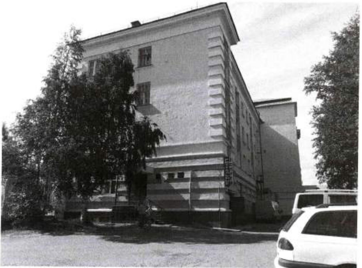
Фото 8. Боковой восточный фасад. Вид с северо-востока
