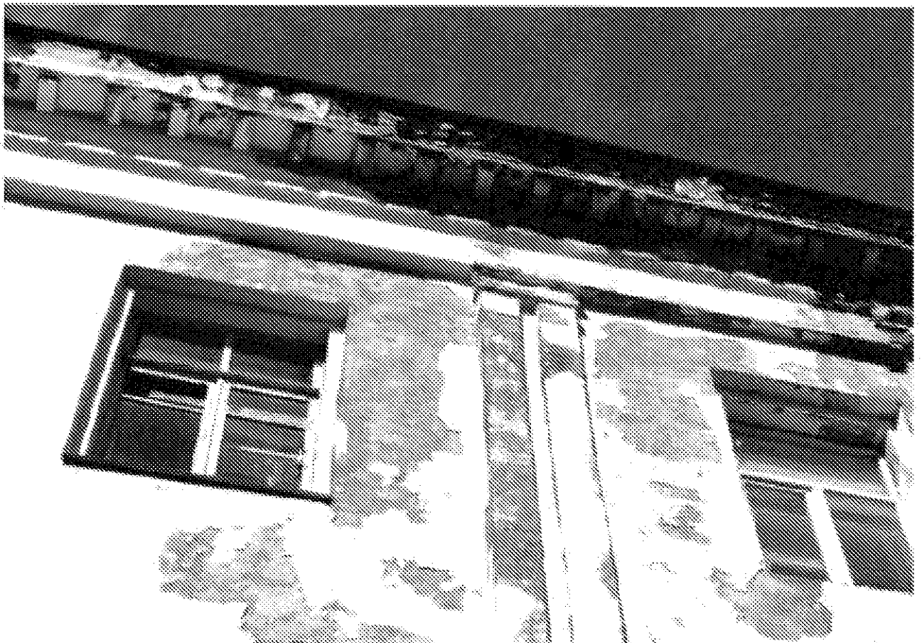
Фото 5. Венчающий карниз с модульсами
