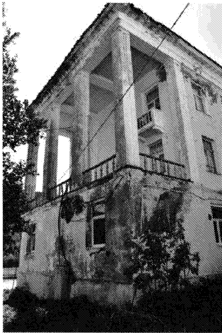
Фото 3. Северо-восточный (торцевой) фасад.
