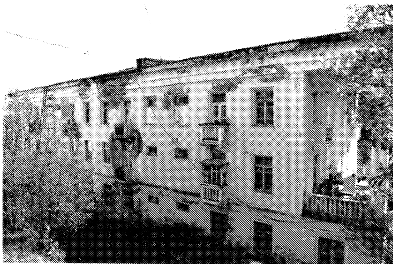
Фото 2. Северо-западный (дворовый) фасад
