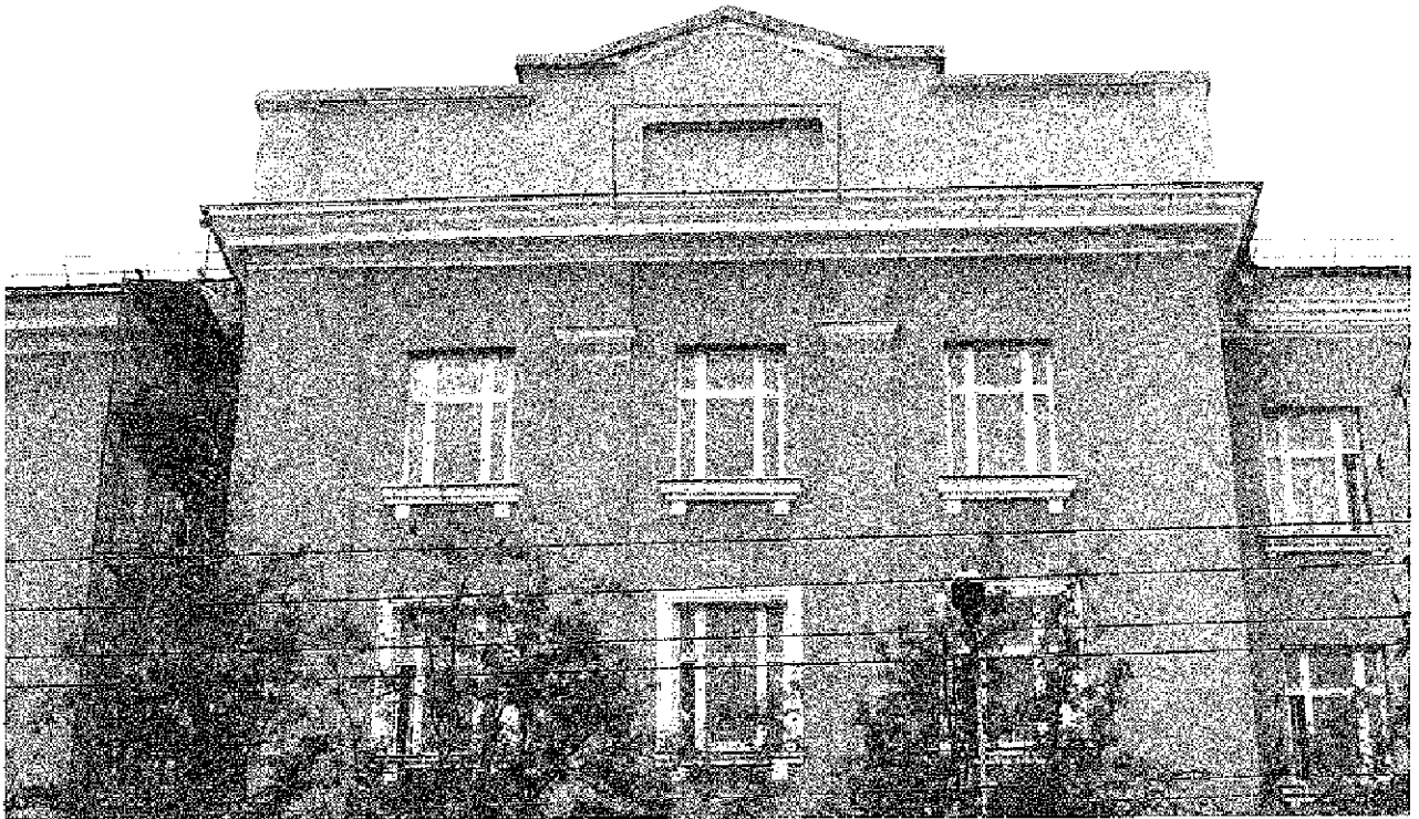
Фото 32. Ниша в центральной части аттика. Центральная часть южного фасада здания. Дата: 14.07.2021
