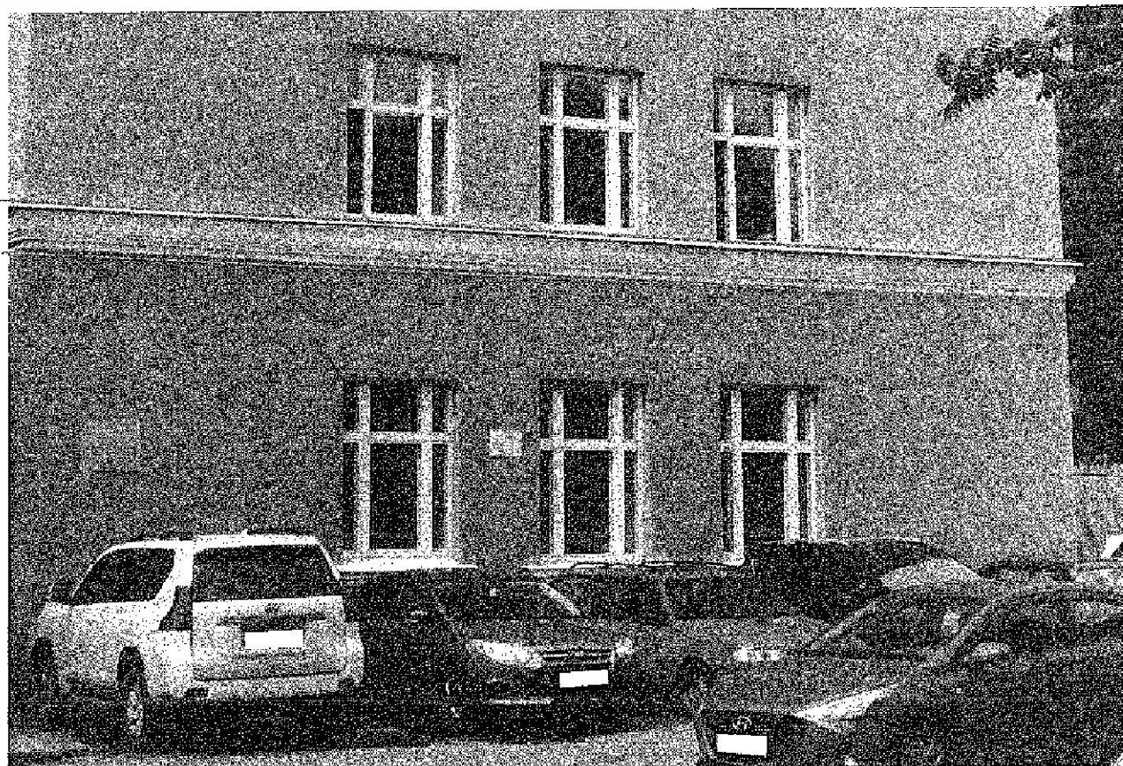
Фото 19. Профилированный межэтажный карниз между 1-м и 2-м этажом. Восточный фасад здания. Дата: 14.07.2021
