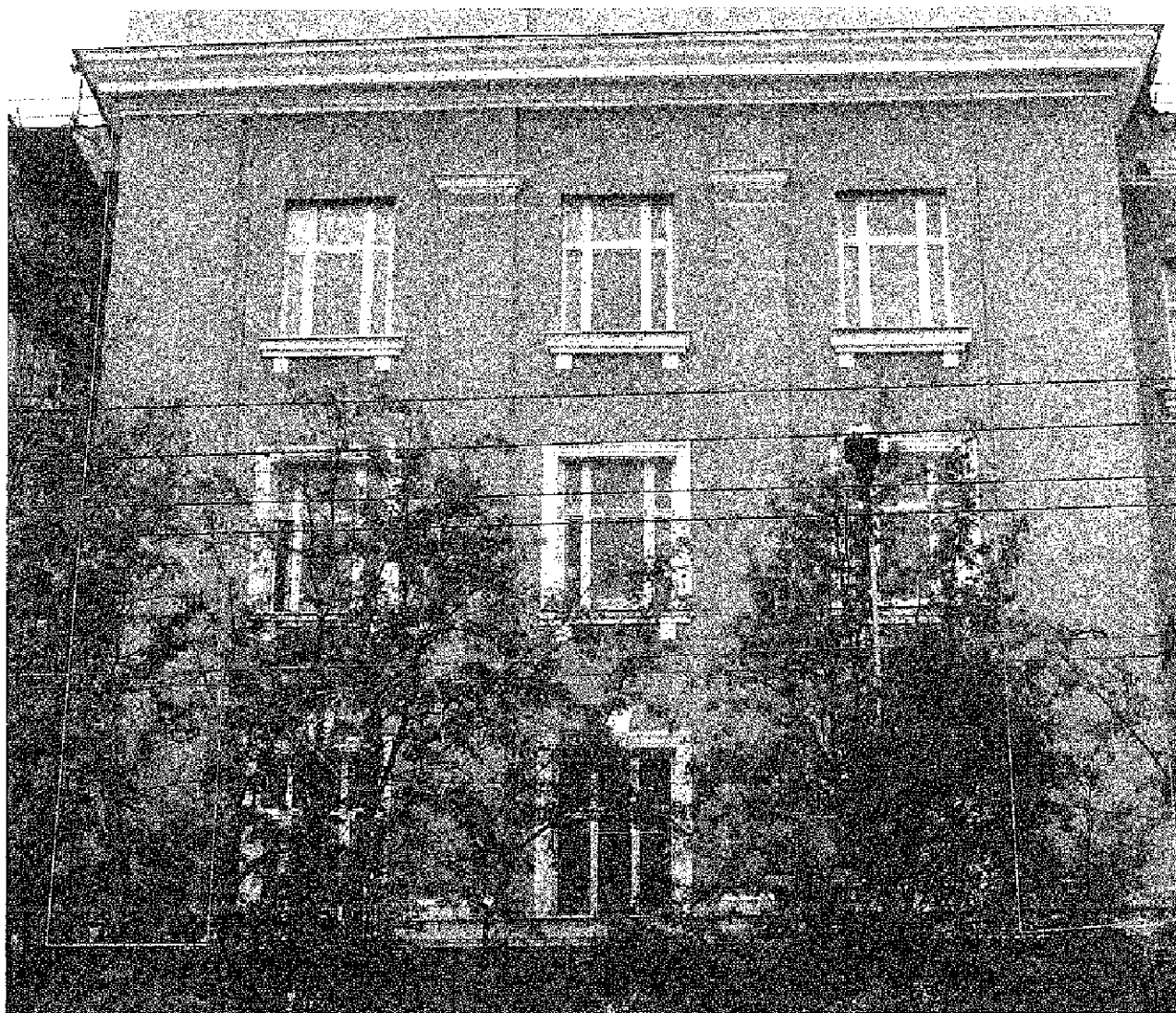
Фото 34. Лопатки по краям ризалита. Южный фасад здания. Дата: 14.07.2021
