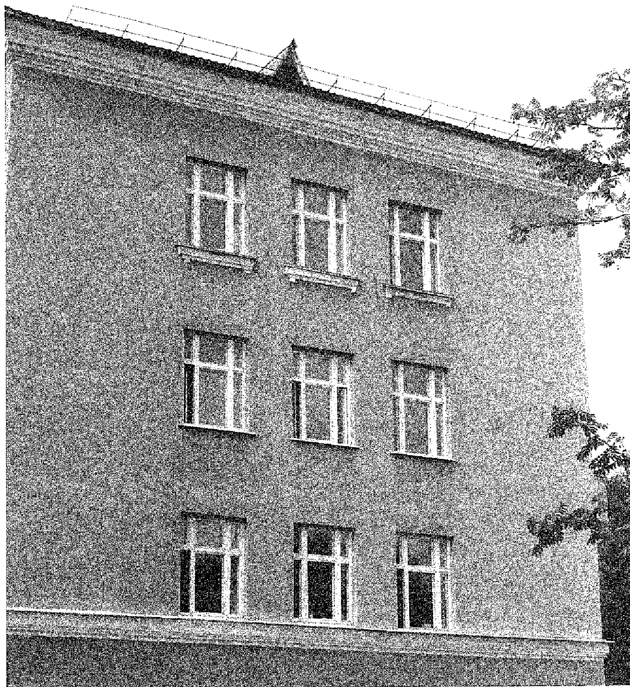
Фото 41. Профилированные подоконные карнизы с 2-мя выступами. Восточный фасад здания. Дата: 14.07.2021
