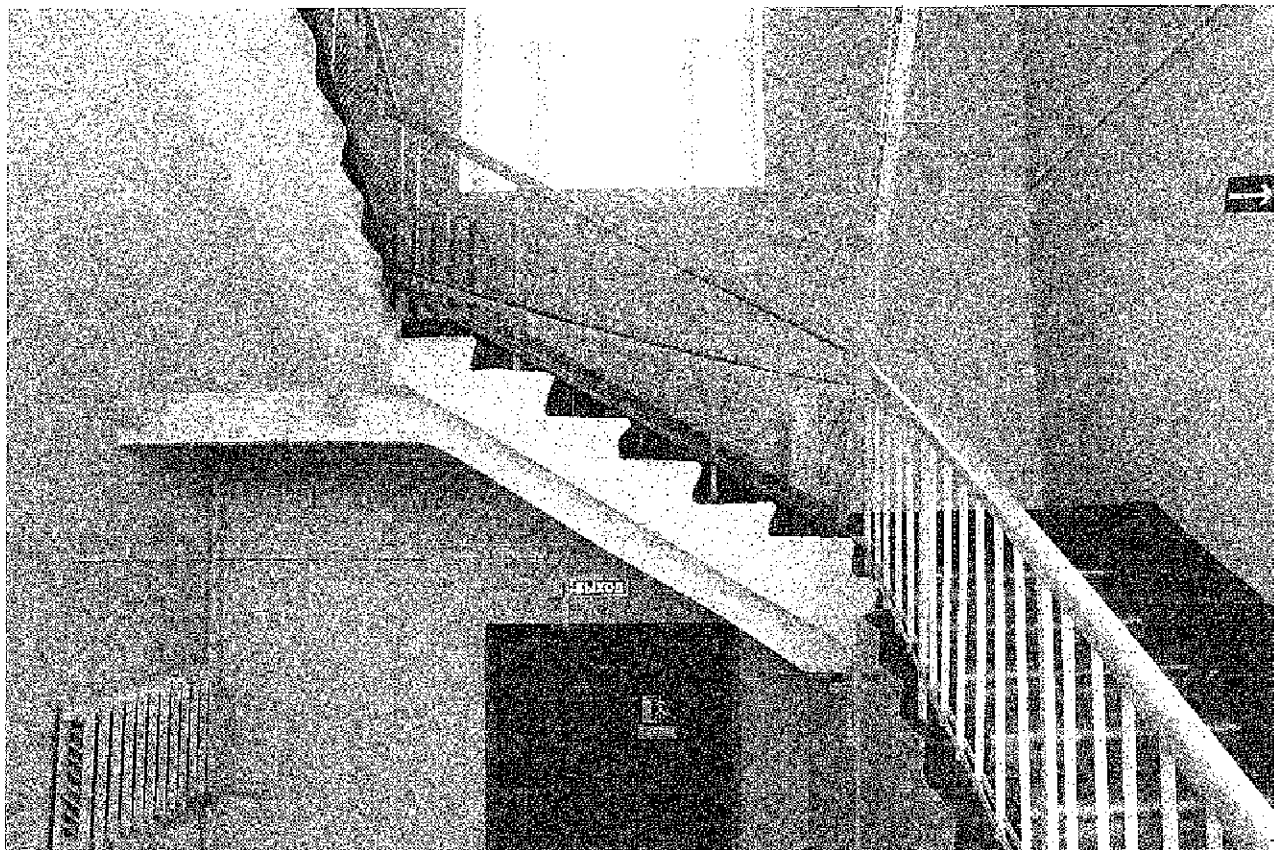
Фото 43. Лестничная клетка, расположенная в западном ризалите со стороны северного фасада здания. Дата: 14.07.2021
