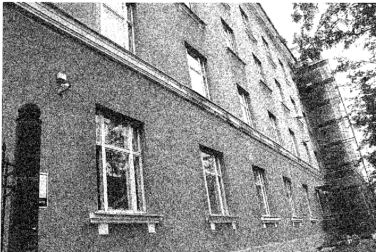
Фото 15. Профилированный межэтажный карниз между 1-м и 2-м этажом. Западная часть южного фасада здания. Дата: 14.07.2021
