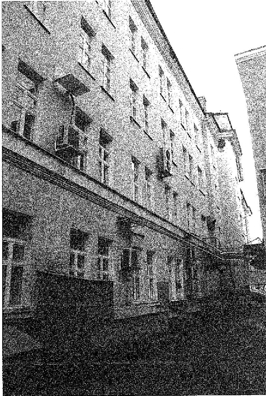
Фото 18. Профилированный межэтажный карниз между 1-м и 2-м этажом. Восточная часть северного фасада здания. Дата: 14.07.2021
