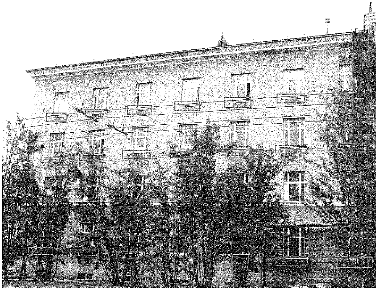
Фото 28. Профилированные подоконные карнизы с 2-мя выступами в западной части южного фасада здания. Дата: 14.07.2021
