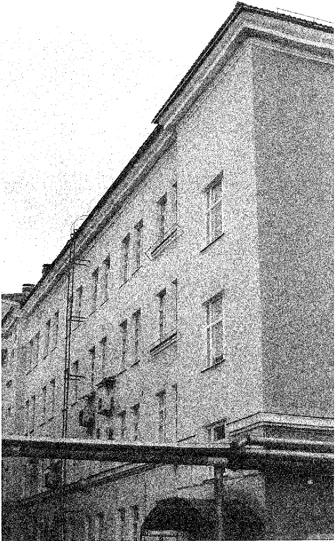
Фото 39. Профилированные подоконные карнизы, 3-й и 4-й этаж. Западная часть северного фасада здания. Дата: 14.07.2021
