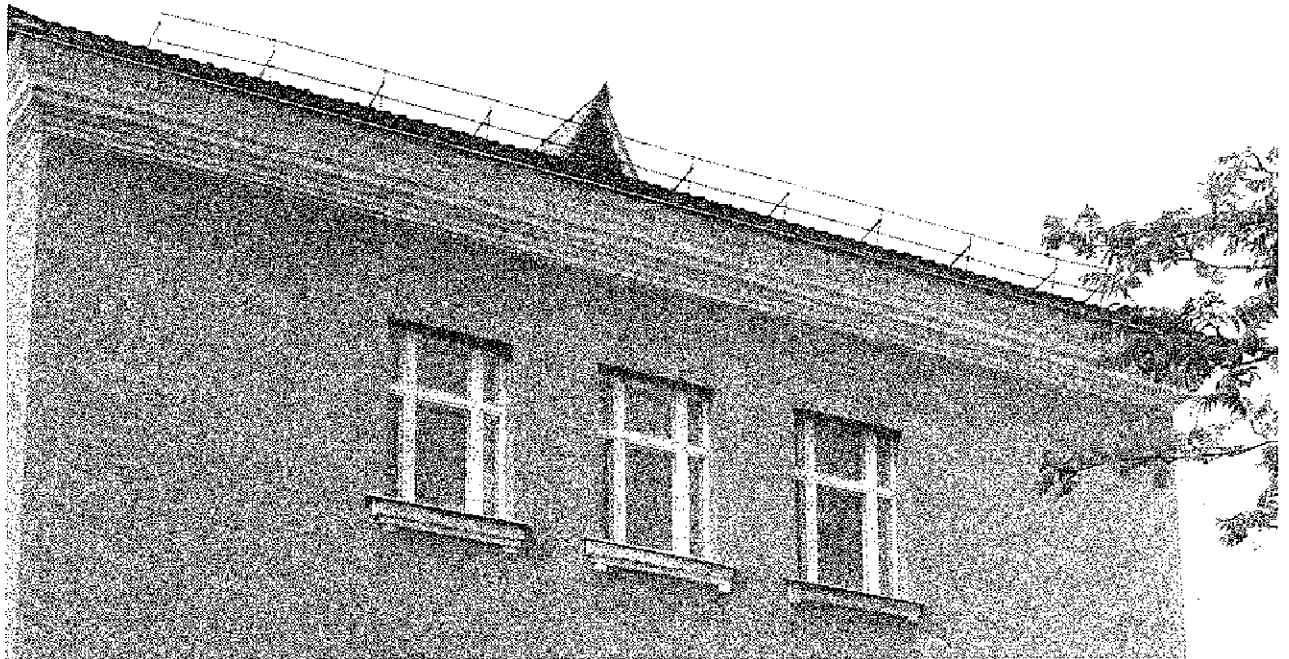
Фото 23. Профилированный венчающий карниз. Восточный фасад здания. Дата: 14.07.2021
