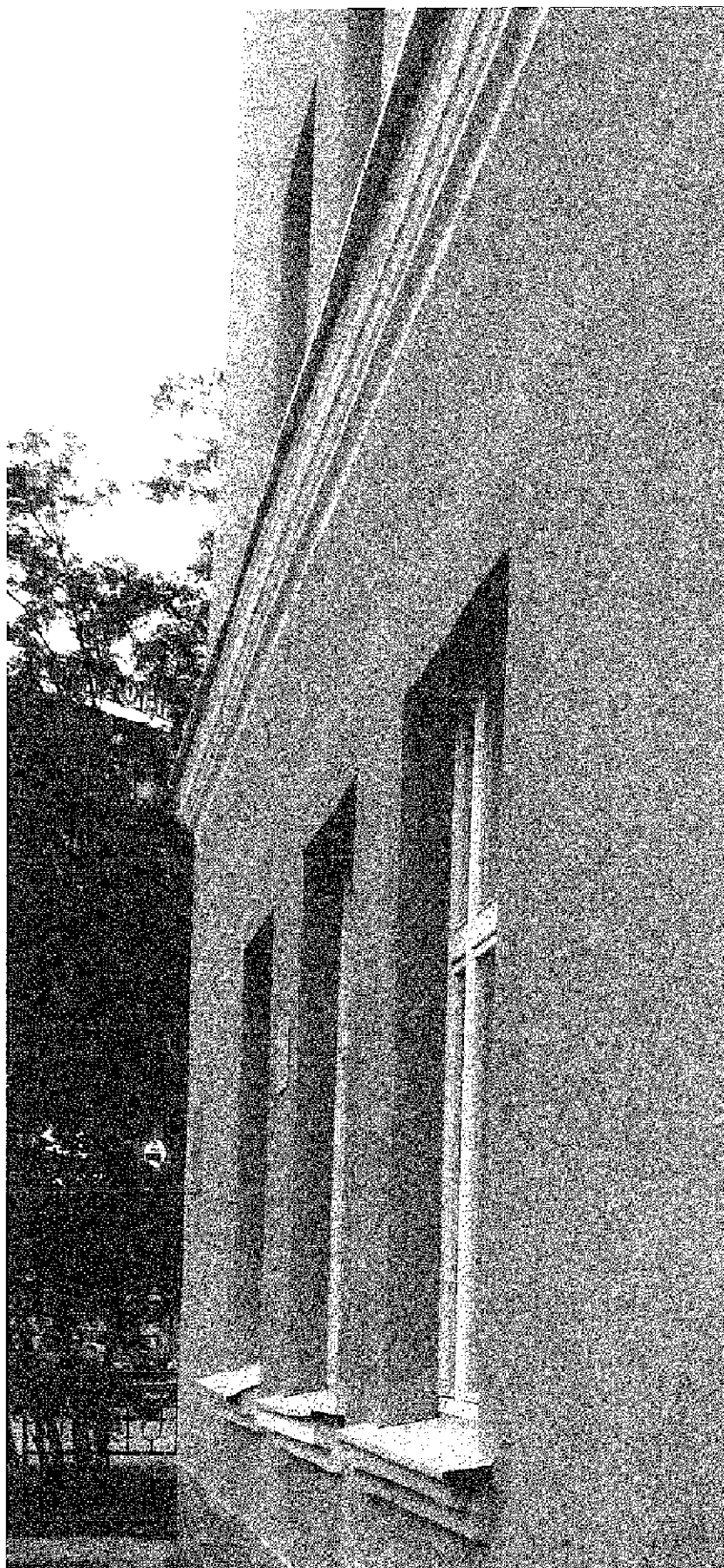
Фото 42. Профилированные подоконные карнизы. 1-й этаж восточного фасада здания. Дата: 14.07.2021
