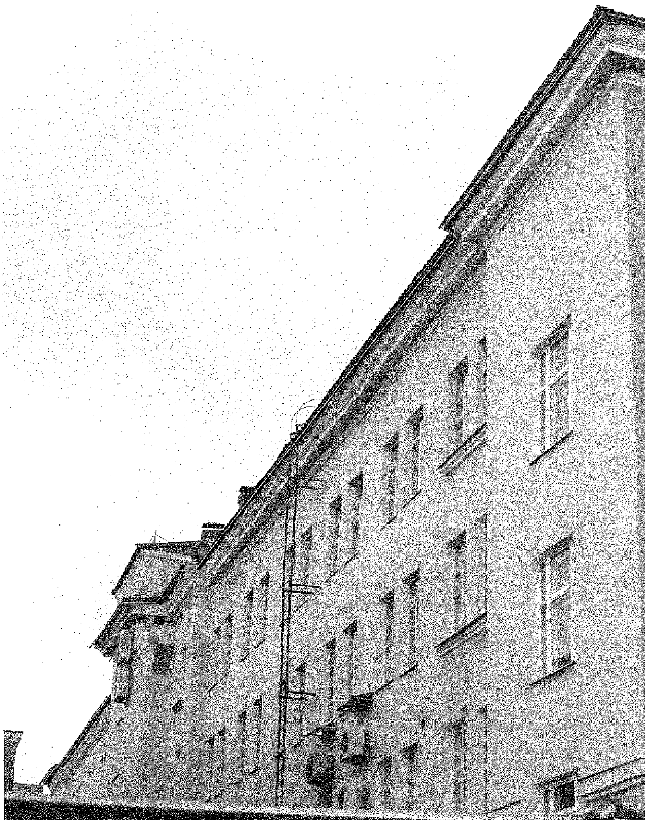
Фото 22. Профилированный венчающий карниз. Северный фасад здания. Дата: 14.07.2021
