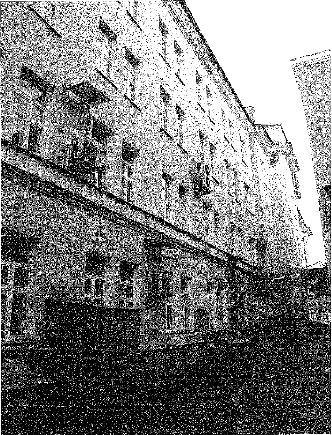
Фото 3. Северный фасад здания. Дата: 14.07.2021
