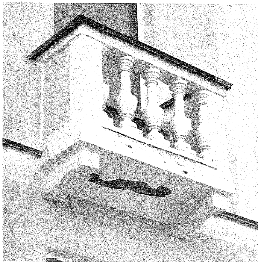
Фото 7. Оформление балюстрадой ограждения балконов, устройство под балконами двух декоративных тяг
