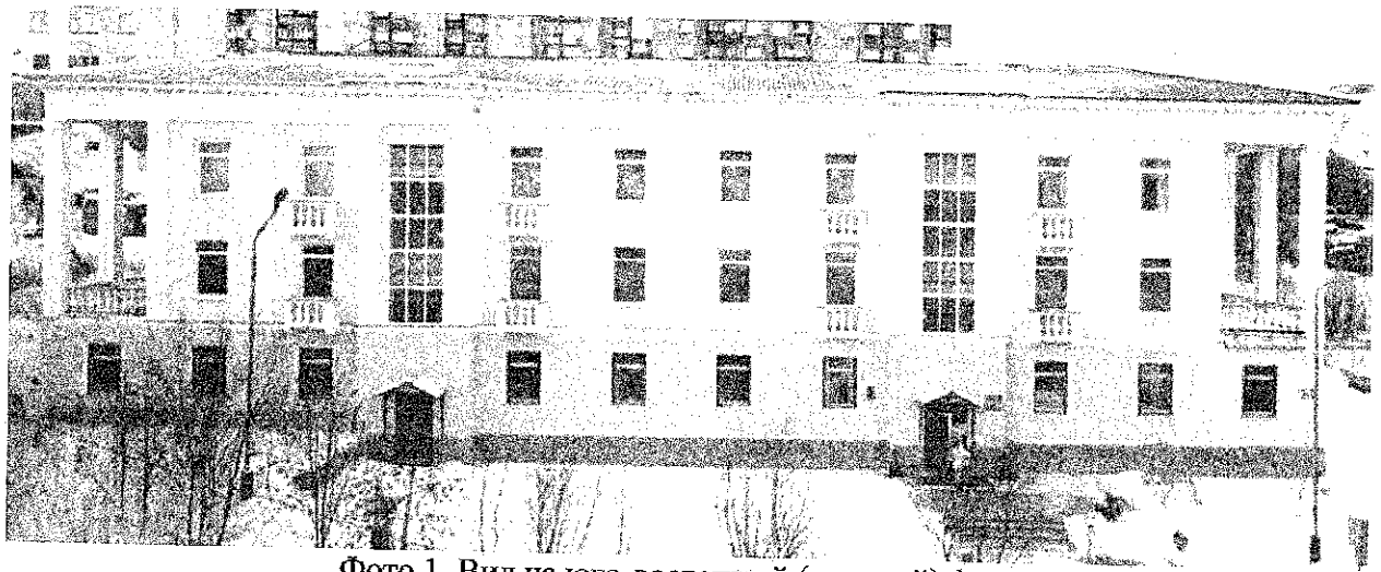
Фото 1. Вид на юго-восточный (главный) фасад
