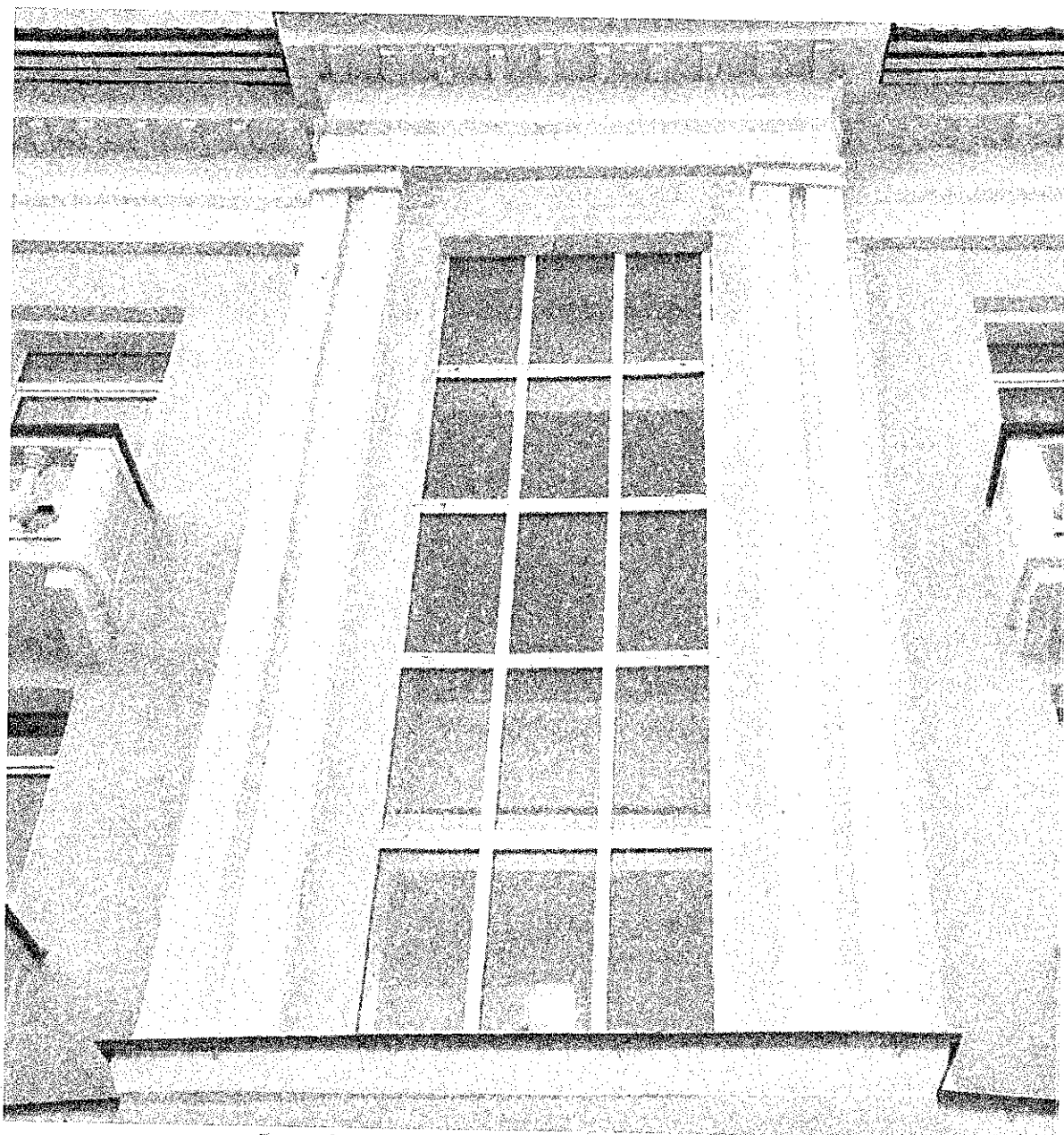
Фото 6. Ризалит. Юго-восточный (главный) фасад
