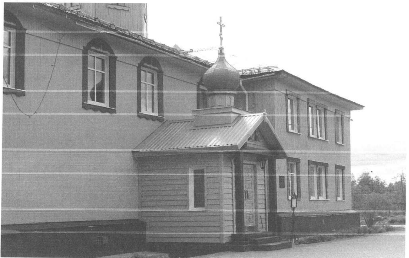
Фото 10. Пристройка в центральной части северо-западного фасада объекта культурного наследия
