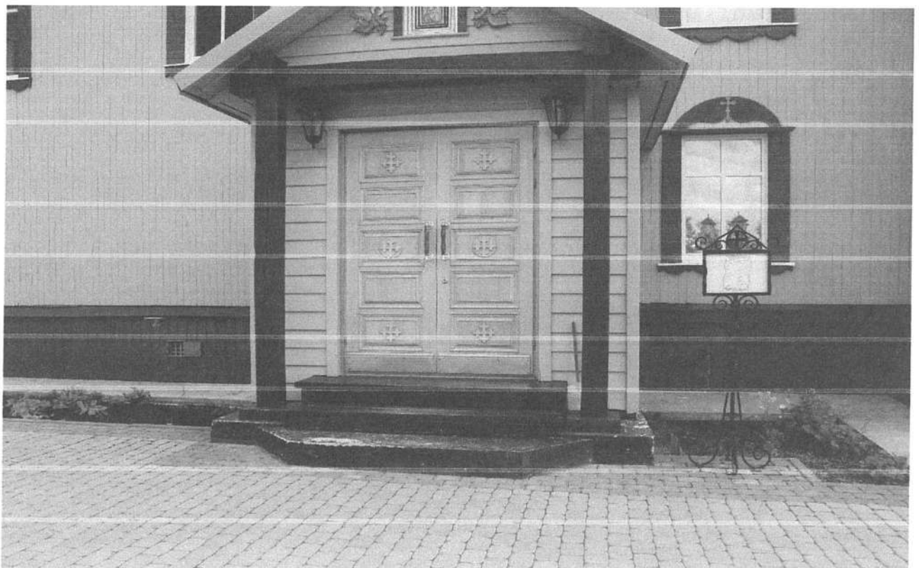
Фото 8. Дверной проем в пристройке со стороны северо-западного фасада объекта культурного наследия
