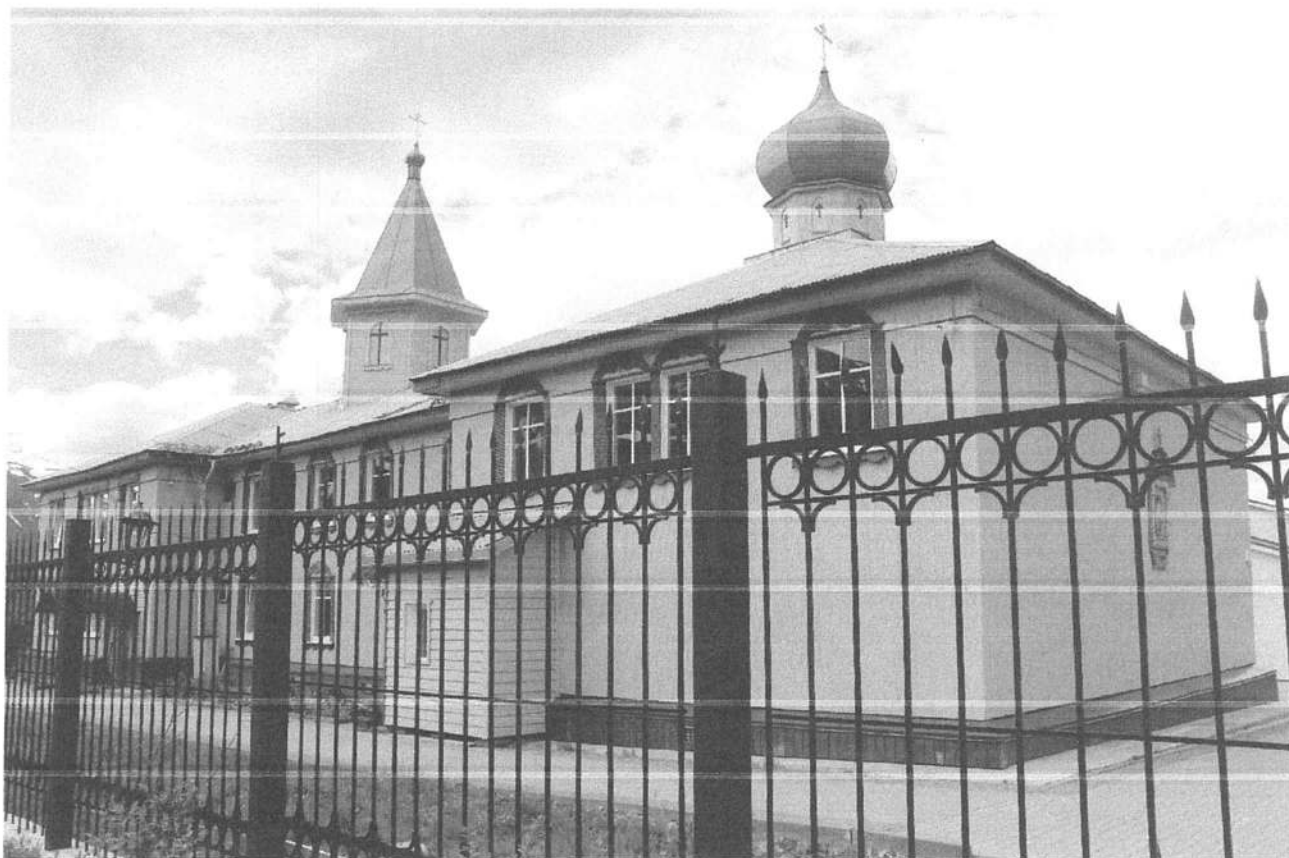
Фото 4. Юго-восточный и северо-восточный фасады объекта культурного наследия
