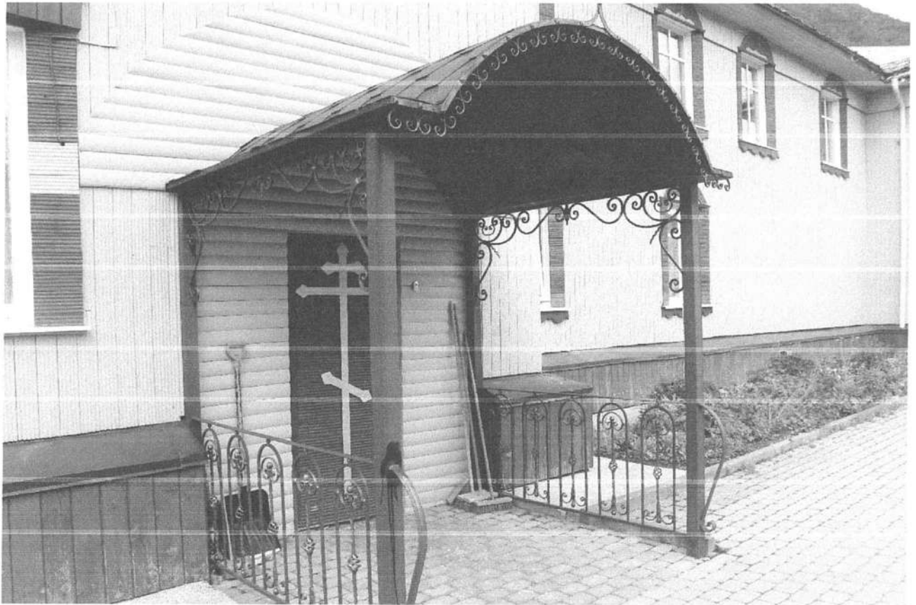
Фото 7. Дверной проем в южном ризалите. Юго-восточный фасад объекта культурного наследия
