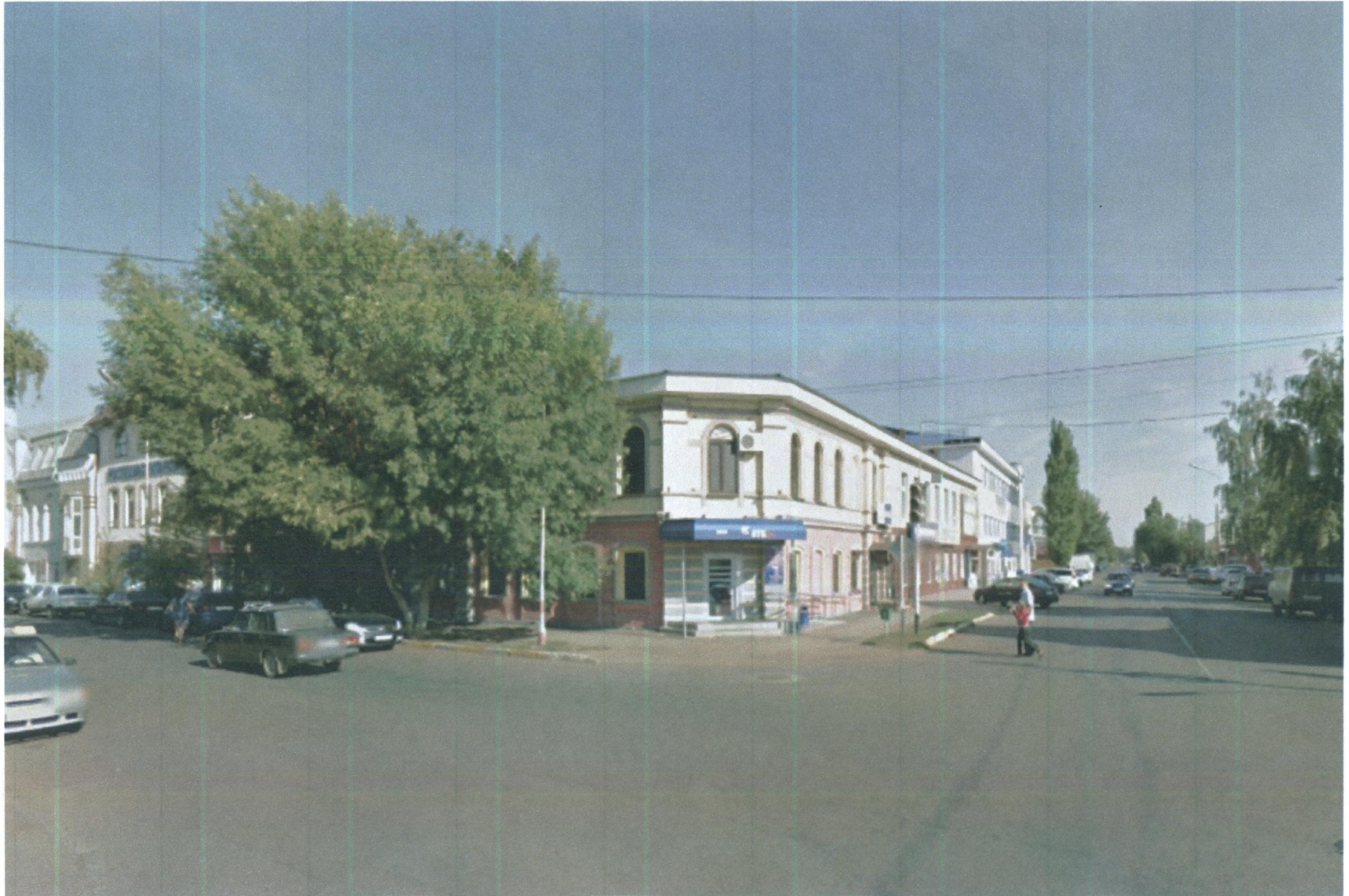
Видовая точка от пл. Ленина на историческую застройку ул. Чапаева
