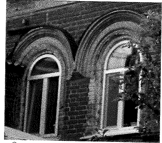
Оконные проемы северного фасада.
