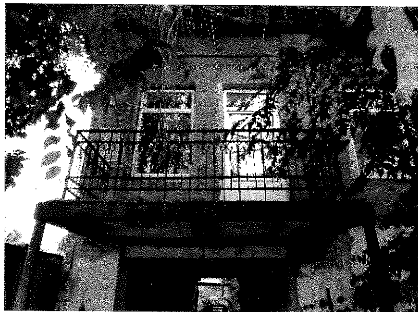
Консольный балкон над въездной аркой.
