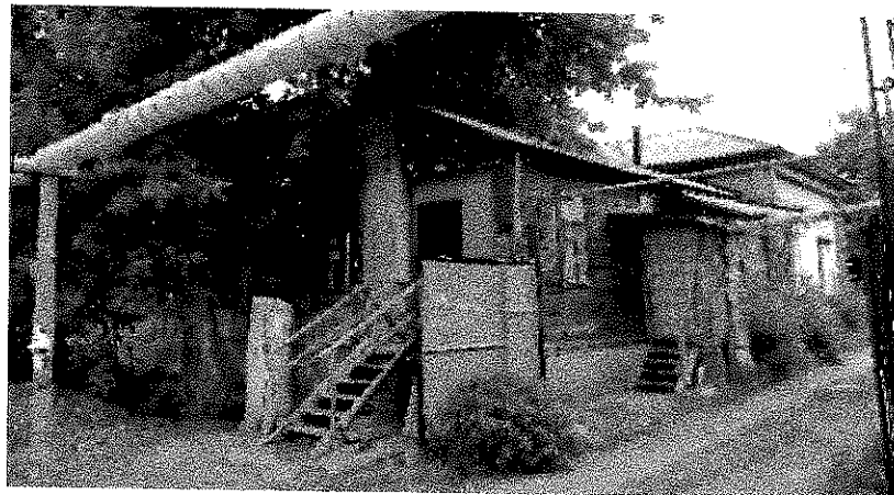
Вид с юго-запада на пристройки, не относящиеся к предмету охраны.
