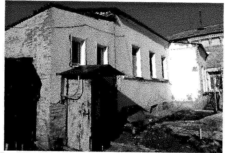
Фасад пристройки с ризалитом и поздней пристройкой.
