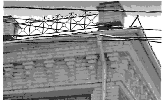
Венчающий карниз с парпетными столбиками флигеля
