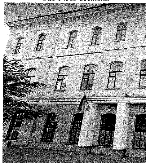
Фрагмент восточного фасада
