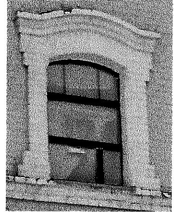
Оконный проем 2-го этажа
