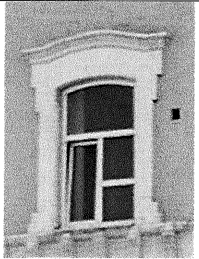
Оконный проем дворовых фасадов
