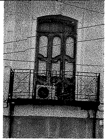
Балконный проем с заполнением
