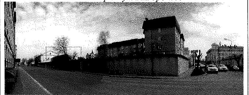
Вид с северо-запада с ул. М.Горького
