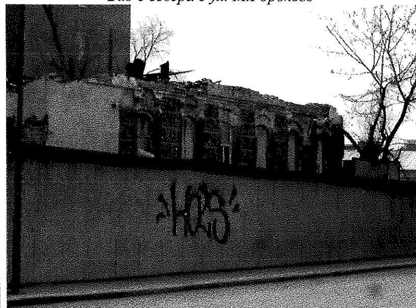
Вид с севера с ул. М.Горького
