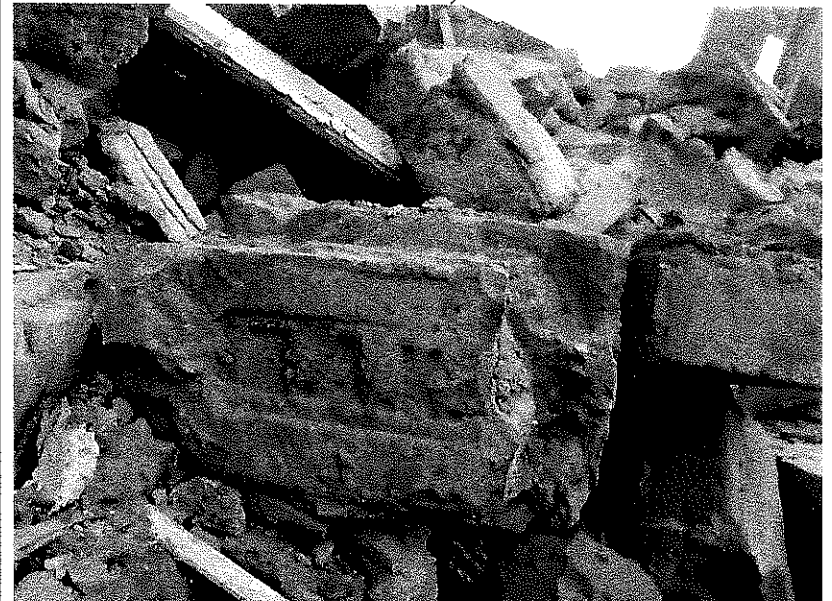
Исторические материалы Характер кирпичных клейм (местоположение – восточная и северная наружные стены)
