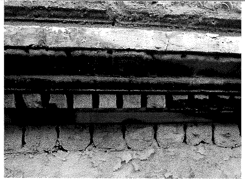
Вид с севера с ул. М.Горького. Детали главного фасада. Межэтажный карниз
