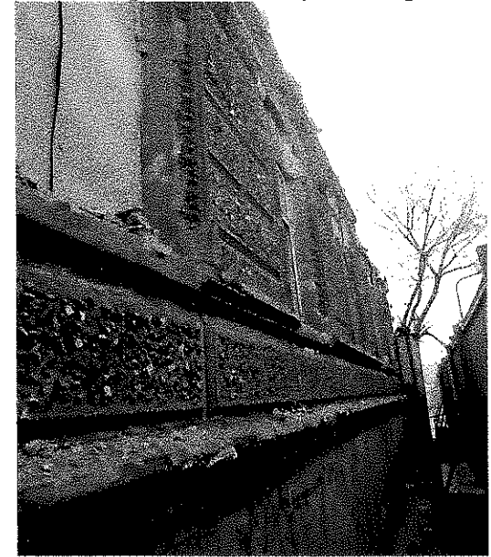
Вид с северо-запада с ул. М.Горького
