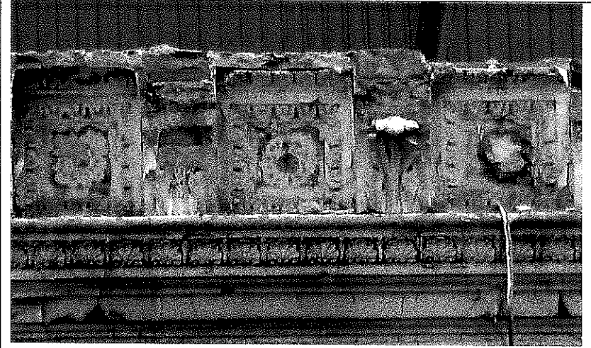
Вид с севера с ул. М.Горького. Детали главного фасада. Венчающий карниз.
