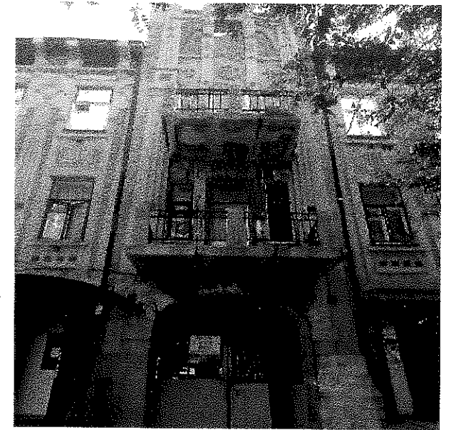
Декор центрального ризалита, балконы
