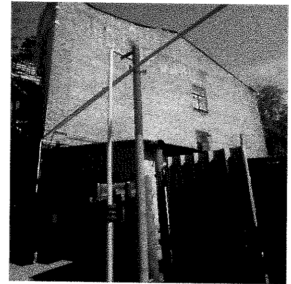
Правый торцевой фасад
