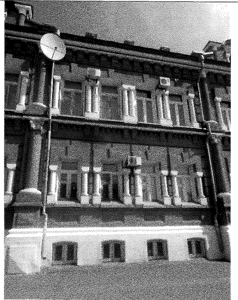
Декор центральной части фасада по ул. Чичерина
