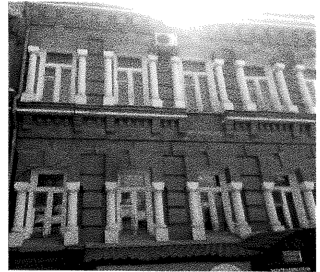
Декор оконных проемов по Ивановскому пер.
