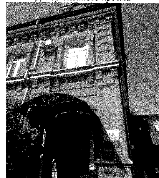
Ризалит юго-восточного фасада
