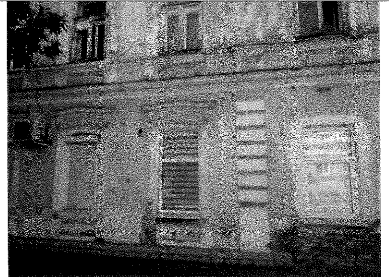
Обрамление оконных проемов 1-го этажа
