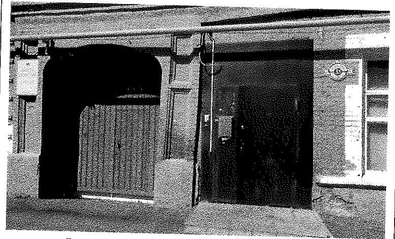
Филенчатые лопатки, проездная арка
