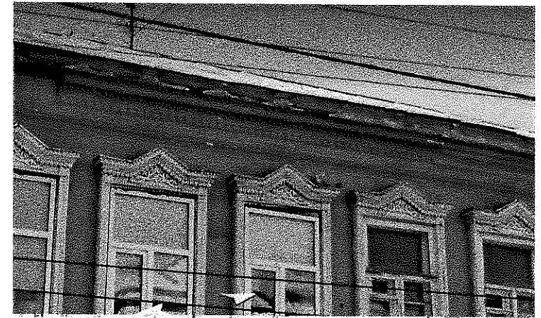
Тянутые профили антаблемента; лепной декор антаблемента; деревянное обрамление оконных проемов
