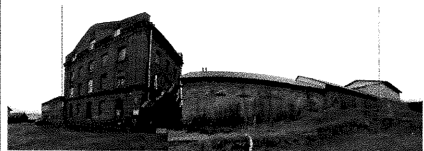
Вид с юга с ул. Мартынова
