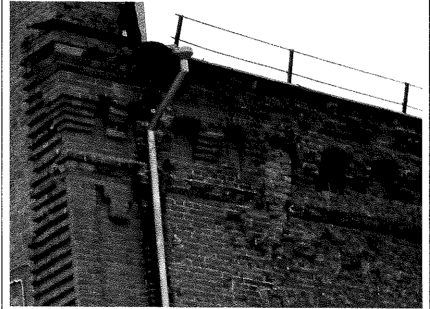
Юго-западный фасад. Детали кирпичной кладки карниза
