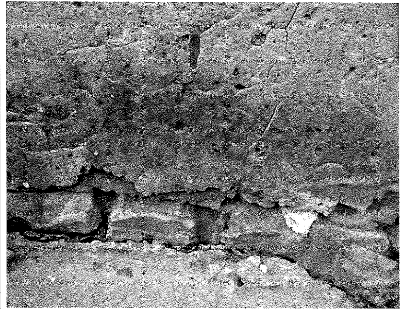
Вид севера со двора. Фрагмент и детали южного фасада
