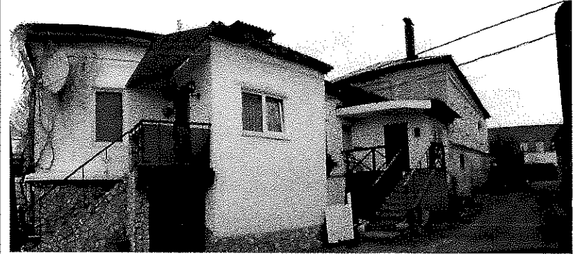
Вид с југо-запада со двора
