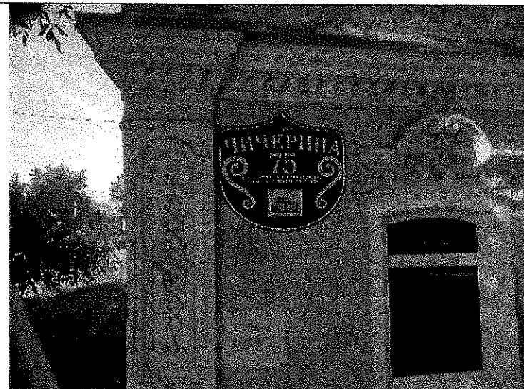
Сандрик, венчающий карниз, лопатка с декоративными элементами
