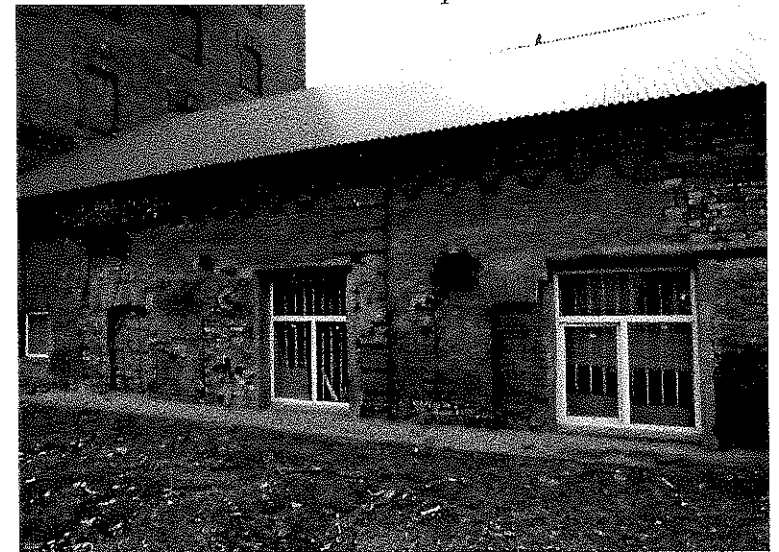
Вид с востока. Детали фасадов
