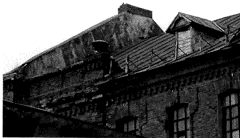
Вид с юго-запада. Детали завершения объекта
