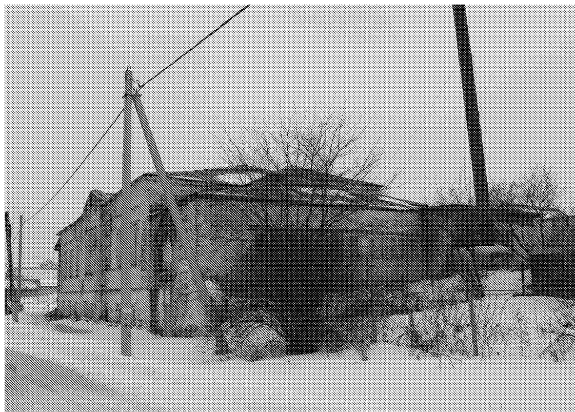
Вид на объект культурного наследия с северо-восточной стороны ул. Университетская. Боковой фасад
