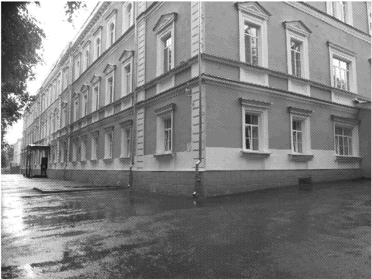
Вид на объект культурного наследия с юго-восточной стороны ул.Красная. Боковой фасад (02.07.2021)
