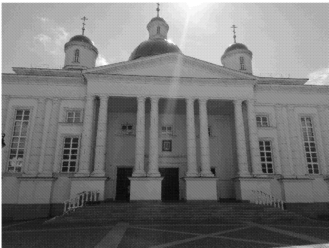
Фрагмент центрального фасада объекта культурного наследия. Входная группа
