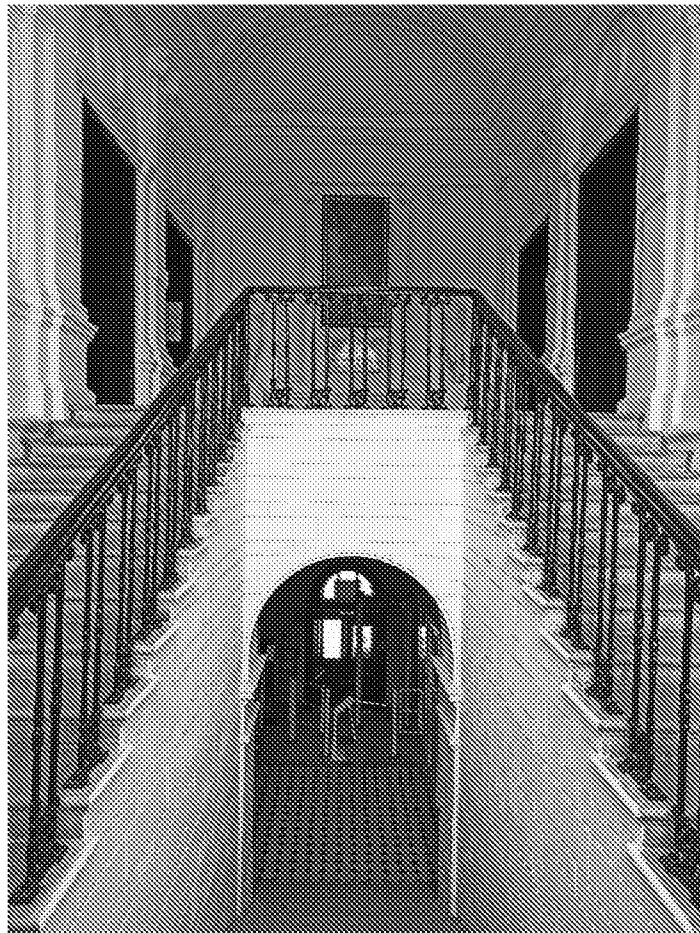
Фото бстонной лестницы, ведущей на второй этаж (03.08.2021)
