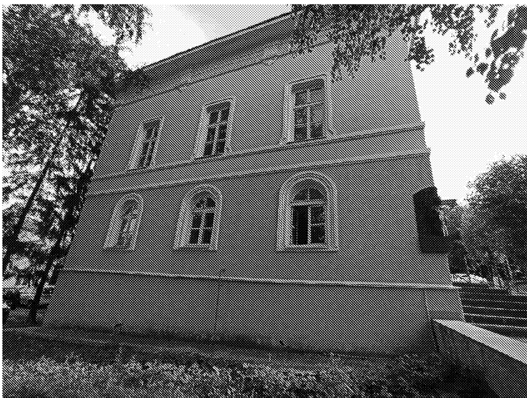
Вид на объект культурного наследия с северной стороны. Боковой фасад
