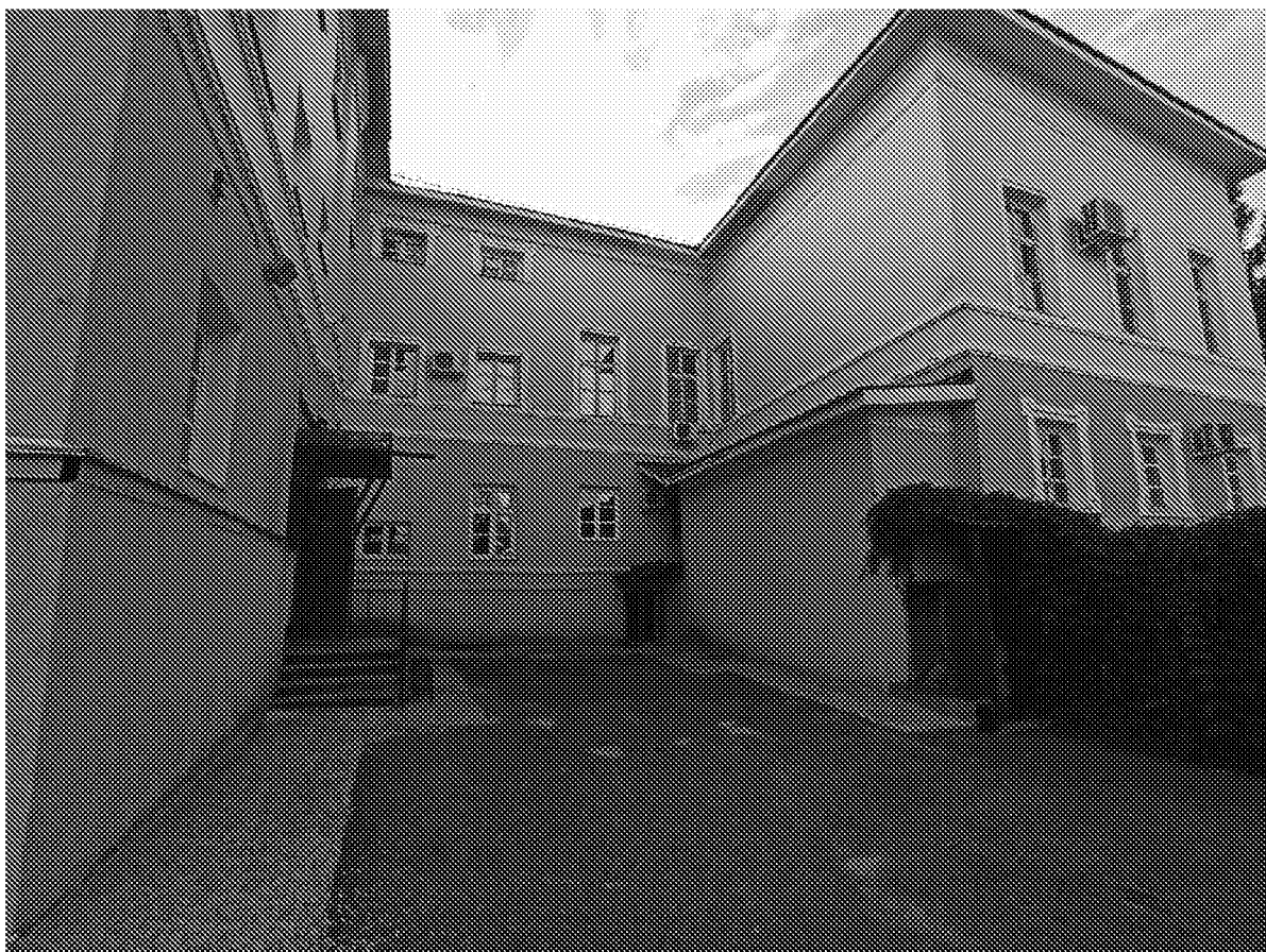
Фрагмент дворового фасада с восточной стороны
