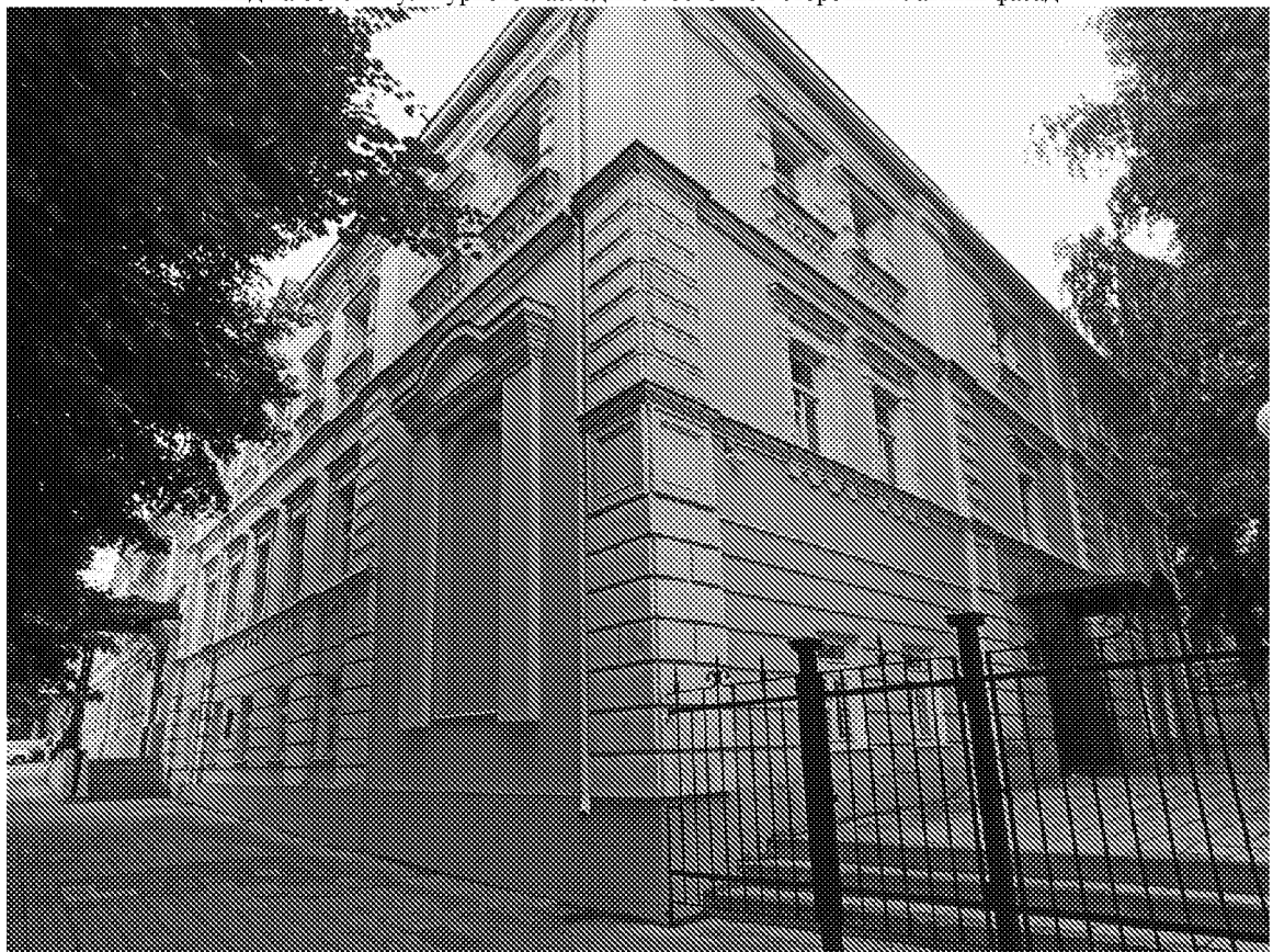
Вид на объект культурного наследия с северо - восточной стороны
