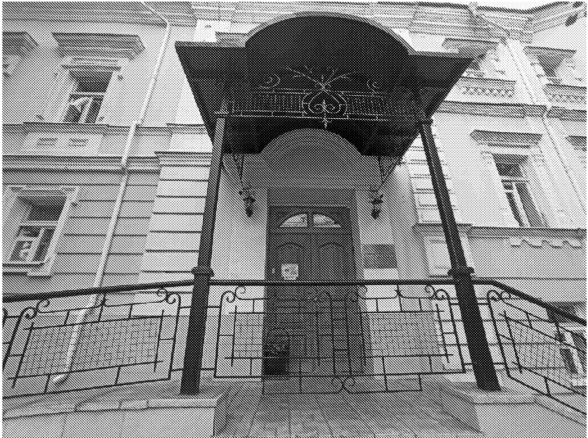
Вид на объект культурного наследия с восточной стороны. Главный фасад
