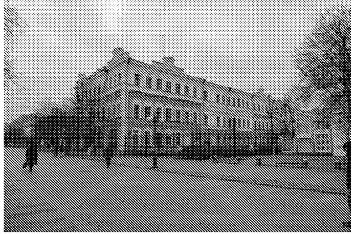
Северный и восточный фасады
